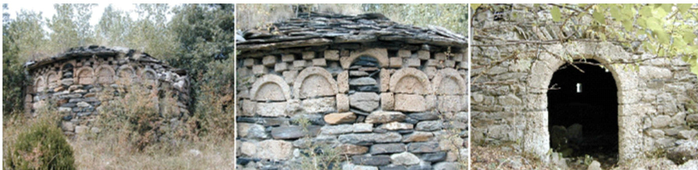
❶ Su ábside con los arquillos lombardos. ❷ Arquillos ciegos tallados en la piedra, es la parte más destacad del templo. ❸ A los pies dispone de su entrada con un arco de medio punto con dovelas de tosca. Fotos: Marta Puyol Ibort (SIPCA – www.sipca.es )
