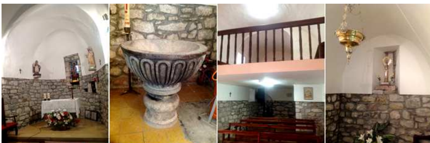
❶ Cabecera abierta con una pequeña ventana, y con bóveda de cañón. ❷ Pila bautismal con taza semicircular que bajo su borde dispone de gallones perfilados en relieves con un fuste con varios bocelos y una fina basa encastrada en el suelo, en una de las capillas del lado de la Epístola. ❸ A los pies dispone de un moderno coro elevado. ❹ Capilla con la Virgen del Pilar, en el lado epistolar.
