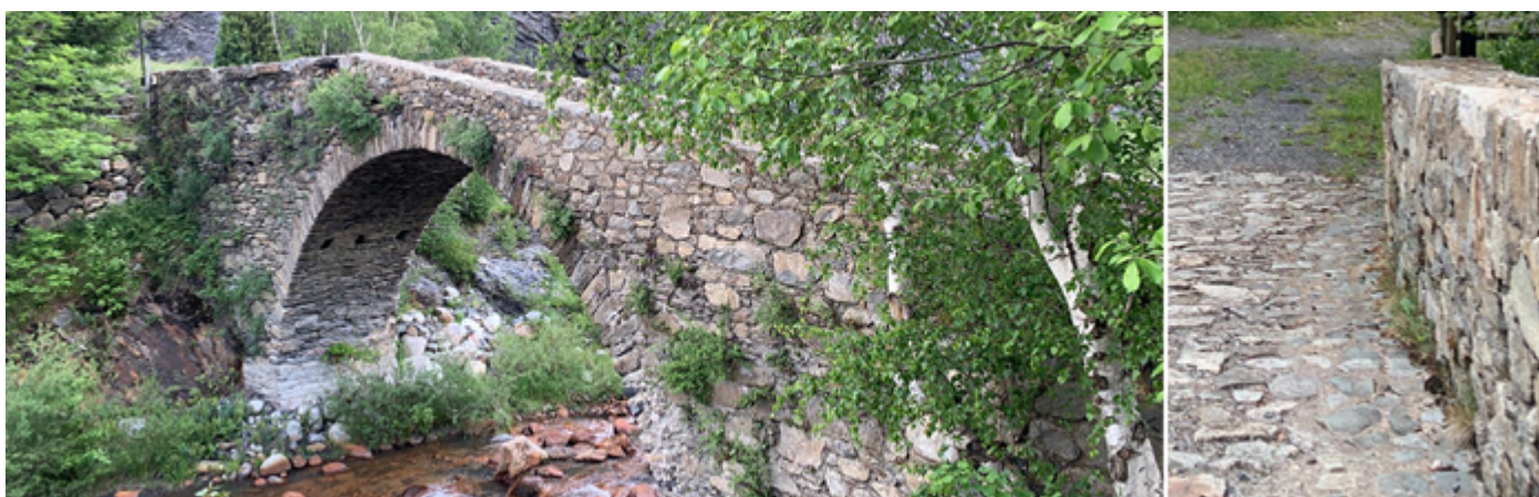
❶ Puente de San Jaime se realizó en sillarejo irregular de un solo ojo y lomo de asno, que intradós de su arco conserva los huecos de los mechinales. ❷ Con una calzada empedrada. Fotos: María Segura.
