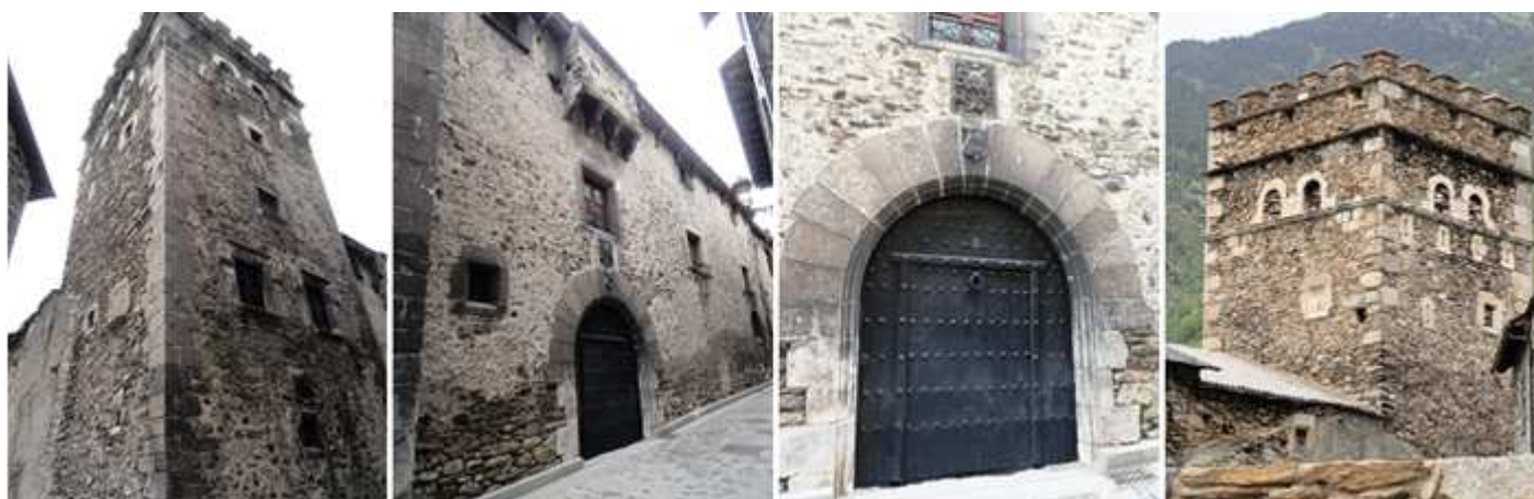
❶ La torre dispone de varios cuerpos y culmina con unas almenas. ❷ La vivienda se articula en torno a un patio, y cuenta con tres pisos. ❸ Sobre la clave de su puerta de medio punto ostenta el escudo que data de 1567. Y encima otro escudo donde en uno de sus cuarteles hay una cruz de Malta. ❹ En la torre podemos apreciar algunas ventanas de medio punto adinteladas y aspilleras.
