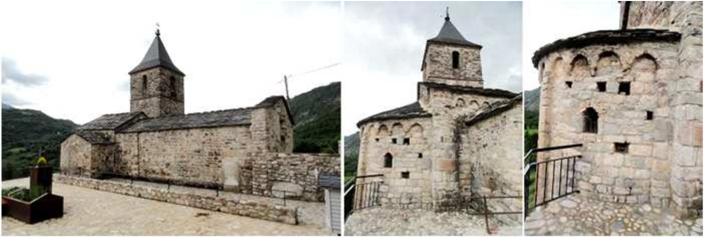
1 x. 2 Exterior del lado del Evangelio ante una plaza con una fuente. 3 Parte derecha del ábside y el presbiterio. 4 El ábside con tres paños separados por columnas adosadas y bajo su alero las arcuaciones ciegas lombardas.
