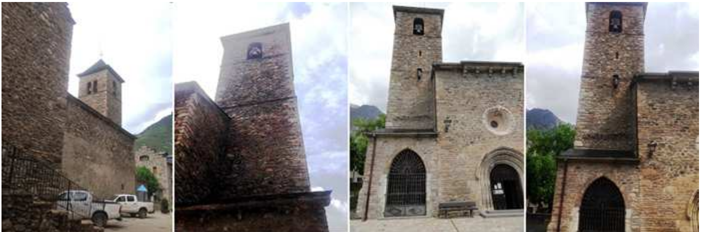
❶ Brazo del crucero y el lateral del Evangelio. ❷ Su torre con tres plantas separadas por impostas corridas. ❸ Fachada del lado de la Epístola, a la izquierda la capilla de la confesión con arco apuntado y a la derecha la puerta del templo. ❹ En la Guerra Civil sus campanas fueron arrojadas al vacío.
