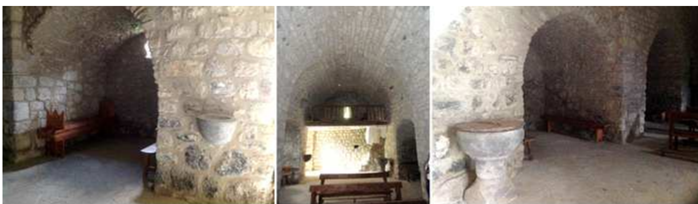
❶ Las capillas con bóveda de cañón y con cierta profundidad. ❷ Junto a la puerta de entrada en el primer tramo de la nave se encuentra un sencillo coro elevado, con una rudimentaria escalera de piedra. La parte inferior del coro tiene restos de pinturas de época moderna. ❸ Las capillas del lateral del Evangelio y la pila bautismal situada bajo la escalera del coro.
