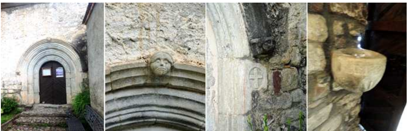
① La portada se encuentra cubierta con un guardapolvo sobre dos ménsulas con cabezas humanas y otra más grande sobre la clave. (rehecha la portada en el S. XVI). ② Cara con una mueca de disgusto. ③ En el lateral derecho y bajo la cara de una ménsula esta cruz excavada. En el lado opuesto se repite igualmente. ④ Pila agua bendita con taza semiesférica con inscripción bajo su borde, y en la parte inferior se encuentra una mano que hace el efecto de que la sostiene encastrada en el muro a la derecha de su puerta.
