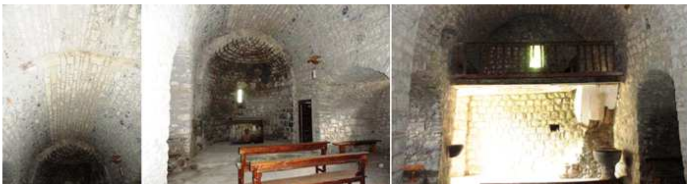
❶ Su bóveda ligeramente apuntada y el arco del tramo del presbiterio. ❷ Su ábside se encuentra elevado con un zócalo. ❸ Detalle de la parte inferior del templo.
