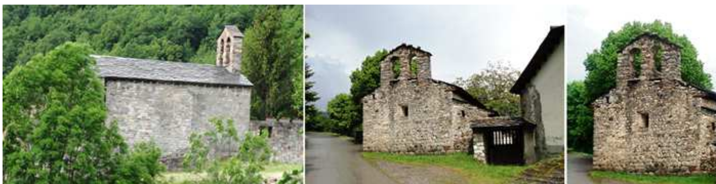
❶ Lateral del Evangelio. Templo de influencia jaquesa. ❷ Su hastial abierto con una venta adintelada y a su derecha un porche de entrada al recinto. ❸ Con una amplia espadaña de dos vanos vacía.
