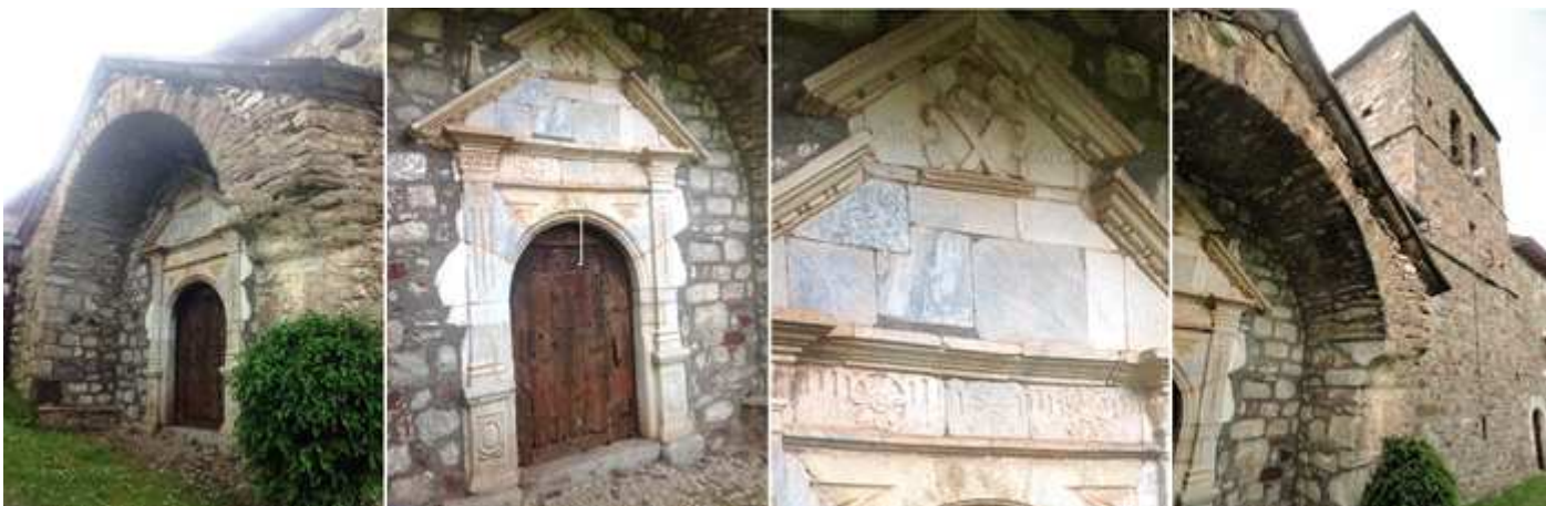
❶ Con un estrecho porche su puerta que se realizó en una reforma posterior. ❷ Con un arco de medio punto y finas columnas acanaladas con capiteles corintios adosadas a sus lados que sostienen un entablamento. ❸ Con un frontis triangular seccionado que en la parte superior posee un escudo con la inscripción a sus lados de: ANO 1658. ❹ A los pies del templo su torre de planta rectangular.
