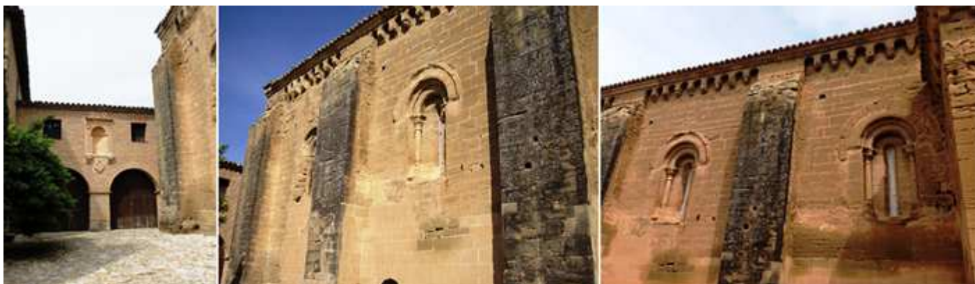
❶ Palacio prioral. ❷ En el exterior de los muros del templo, cada tramo está abierto con una ventana. ❸ Bajo su alero una serie de canecillos sostienen unos arquillos con leves molduras.
