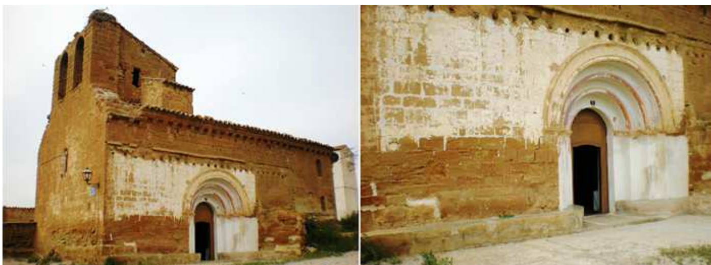
❶ Es un templo de pequeñas dimensiones. ❷ En el lado del medio día y situada en el segundo tramo su puerta de ingreso con unos mechinales en su parte superior de haber poseído un pórtico que cubriera su entrada. Fotos: www.fraella.com
