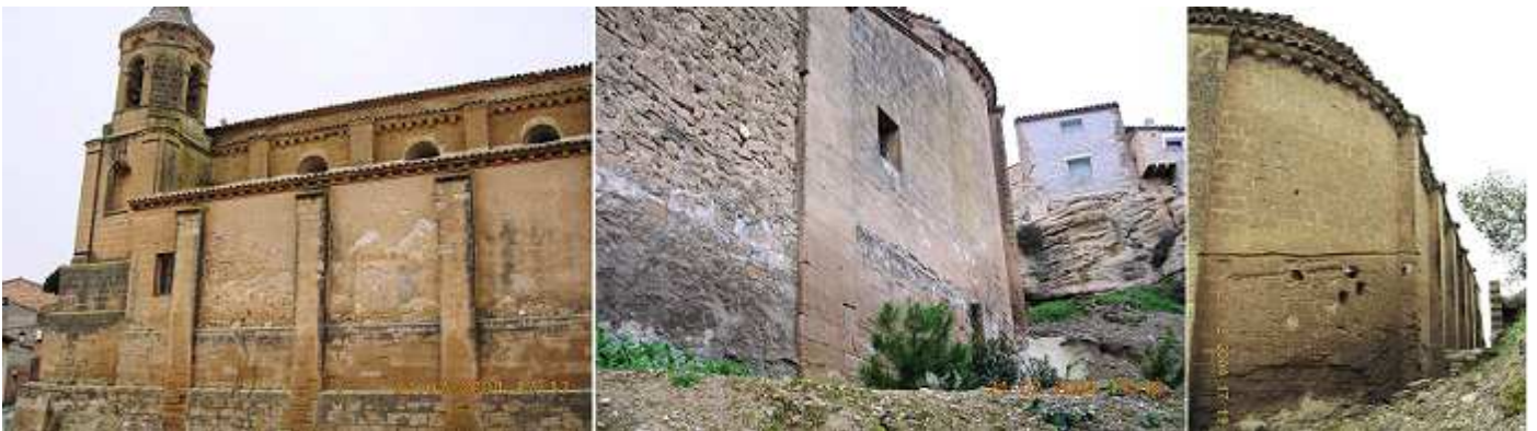
❶ Lateral de la Epístola donde se encuentran las capillas que poseen mayor profundidad. ❷ Tramo del presbiterio de este lado exterior y su cabecera. ❸ Su cabecera posee dos contrafuertes y en el paño central esta su ventana.
