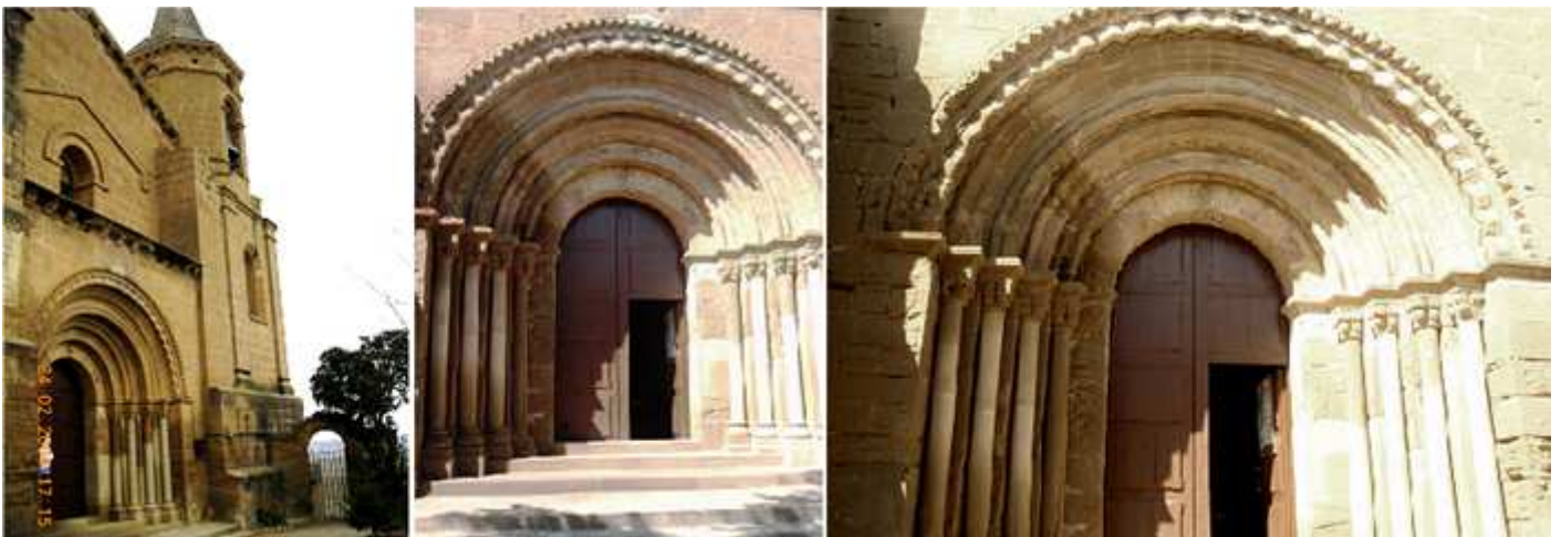
❶ Fachada de San Juan Bautista y sobre el tejazoz una ventana de medio punto. ❷ Portada de San Juan Bautista abocinada con seis arquivoltas, y decorada con un baquetón con puntas de diamante. ❸ Sus arquivoltas producen un abocinamiento de la portada.
