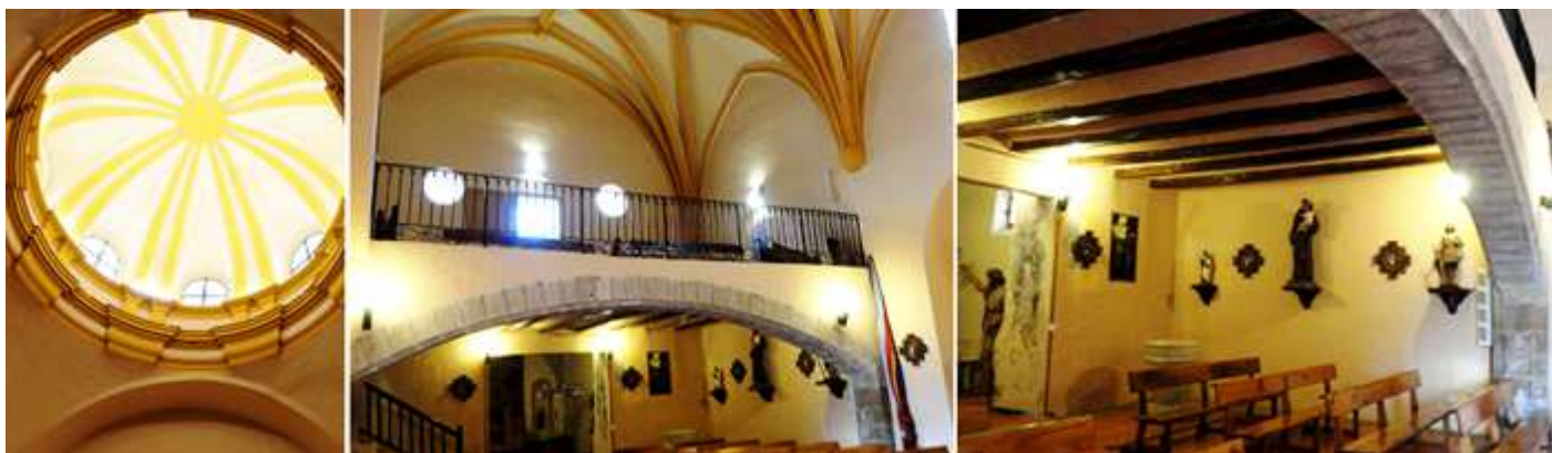
1 Posee un cúpula con ocho gajos y sus respectivas ventanas 2 El coro elevado sobre un arco rebajado. 3 Parte inferior del coro.
