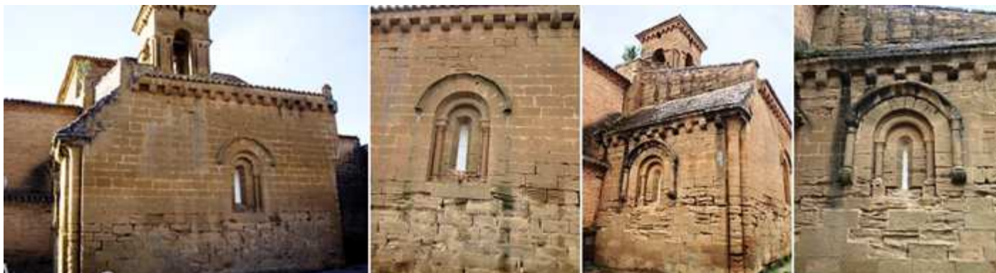
1 Esta torre era de señales. 2 Ventana con una arquivolta y guardapolvo. 3 Lateral de panteón con otra ventana. 4 Esta ventana tiene una arquivolta con columnas y capiteles y su guardapolvo igualmente descansa en capiteles y columnillas
