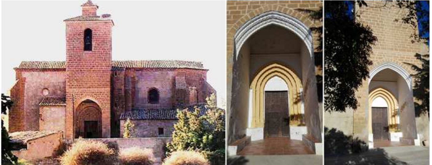
❶ Lado epistolar con su puerta bajo el pórtico alojado en la parte inferior de la torre. ❷ Bajo el primer cuerpo de la torre se abre un arco apuntado con un porche dorado a sus lados de bancos corridos y con una puerta igualmente ojival con tres arquivoltas que llegan hasta la bancada existente. ❸ Otra imagen bajo la torre de su ingreso. Fotos: Pablo Gracia Castel.
