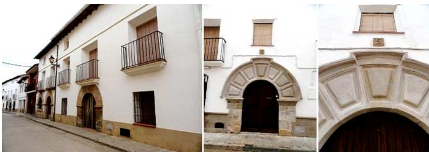
❶ En la calle de Ramón Sender algunas de sus casonas antiguas. ❷ Con puertas de medio punto. ❸ Como esta almohadillada 1103
