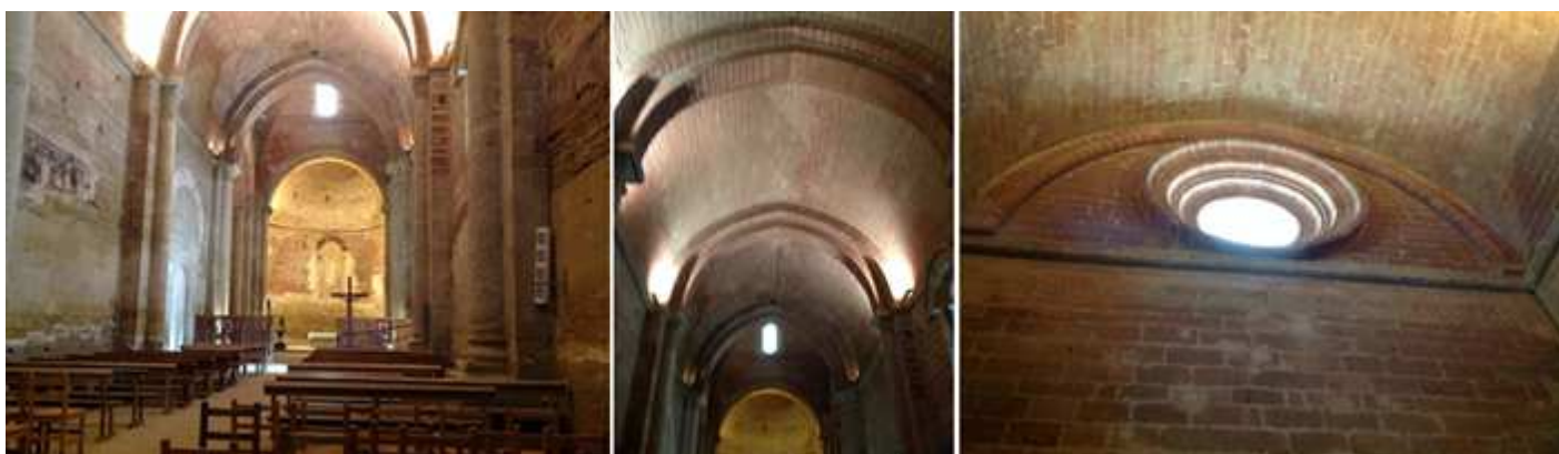
1 La nave de la iglesia vista desde los pies del templo. 2 Bóveda de cañón ligeramente apuntada sostenida por arcos fajones que descansan en grupos de una gruesa columna recta y otra redonda adosada, estas con capiteles. 3 Óculo baquetonado a los pies del templo y toda la nave esta recorrida por una imposta igualmente baquetonada.
