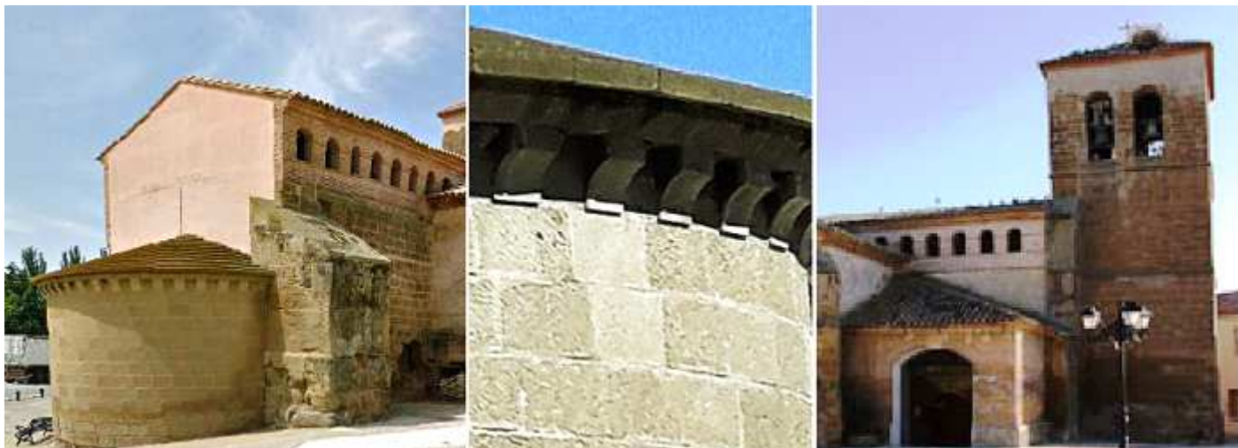
❶ Su cabecera con una desproporción con la nave del templo. ❷ Detalle de sus canchillos lisos bajo el alero. ❸ Su entrada albergada en un pórtico y su torre de tres cuerpos separados por impostas corridas. Foto: Ayuntamiento.
