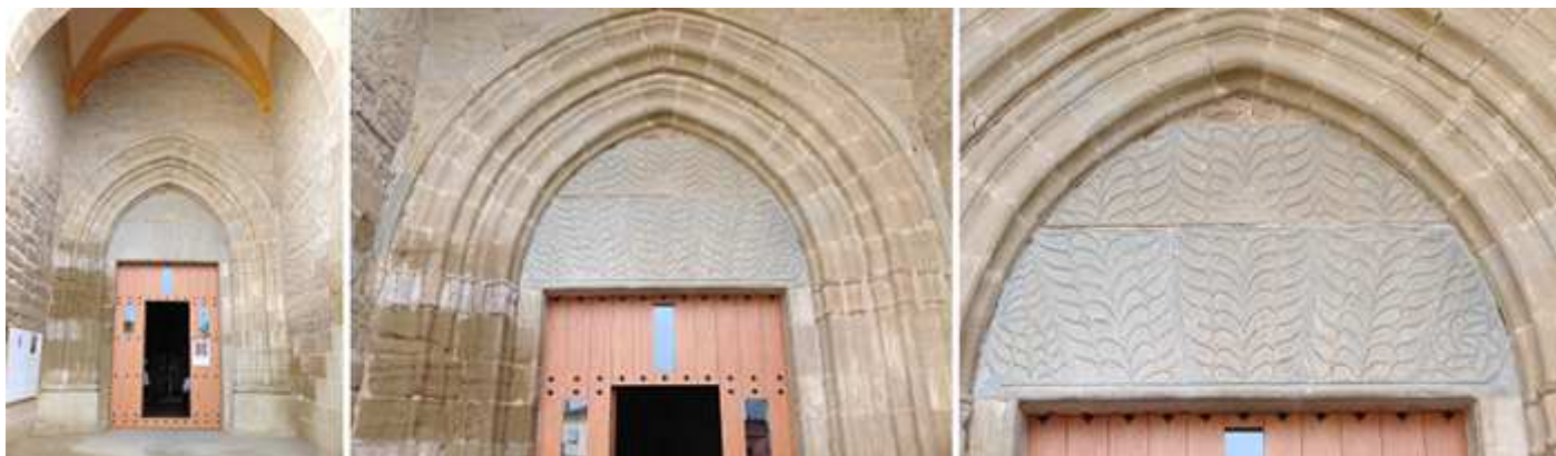
1 Portada dentro de un atrio. 2 Su portada sur de arco apuntado es de finas arquivoltas baquetonadas 3 Tímpano compuesto por dos losas que tiene grabados en relieve una decoración de vástagos vegetales.
