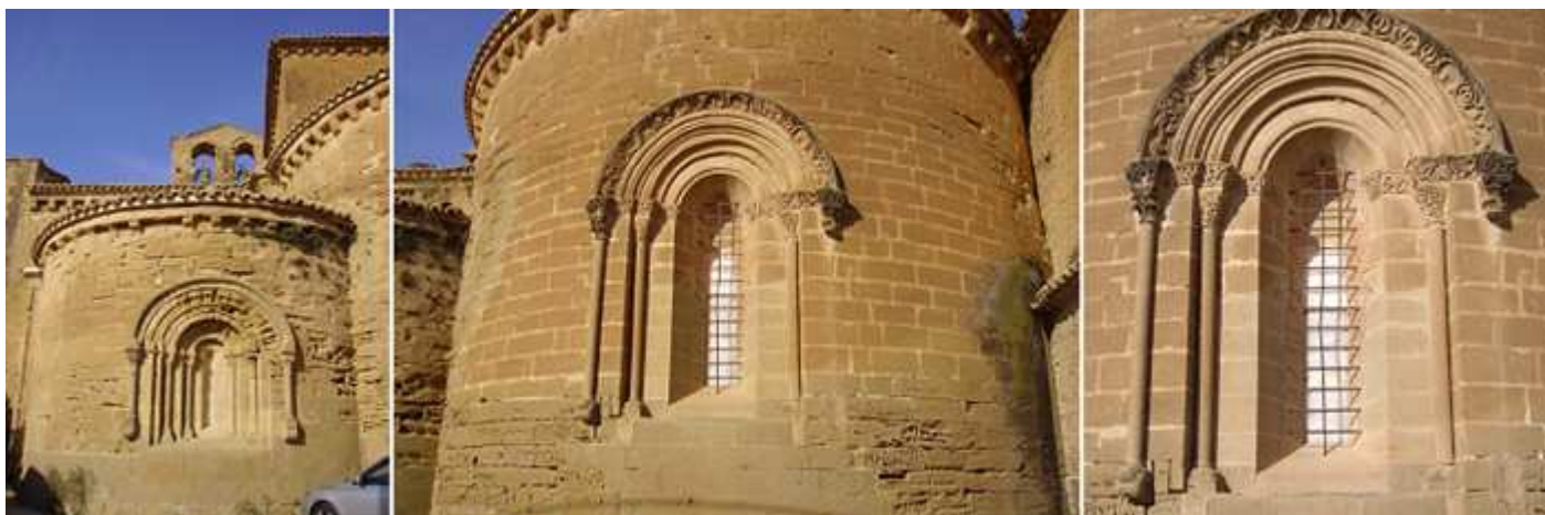
❶ Ábside del lado epistolar con cuatro arquivoltas baquetonadas y guardapolvo ❷ Ábside central. ❸ La ventana de este ábside tiene un guardapolvo con roleos y dragones con una imposta corrida decorada y cuatro columnillas (ha perdido una).
