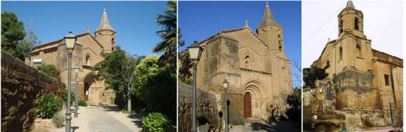
❶ Fachada de la iglesia. ❷ En la fachada, en su parte izquierda se aprecia, lo que sería su torre campanario del edificio original. ❸ En el ángulo derecho se eleva su torre de planta cuadrada con tres cuerpos que el último se vuelve octogonal para sus campanas.
