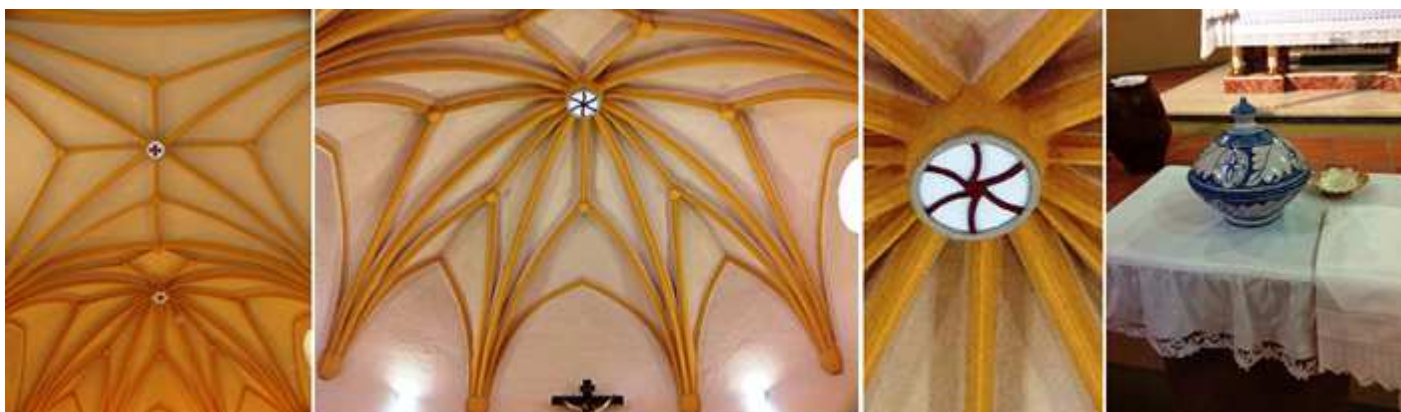
1 Bóveda del presbiterio y cabecera. 2 Preciosa bóveda estrellada sobre el alar Mayor. 3 En la clave central se encuentra la rueda de molino de San Vicente. 4 Pila bautismal de cerámica y una vieira.
