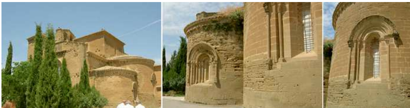
1 Conjunto exterior de su cabecera. 2 Los dos ábsides existentes. 3 Y la ventana del ábside central
