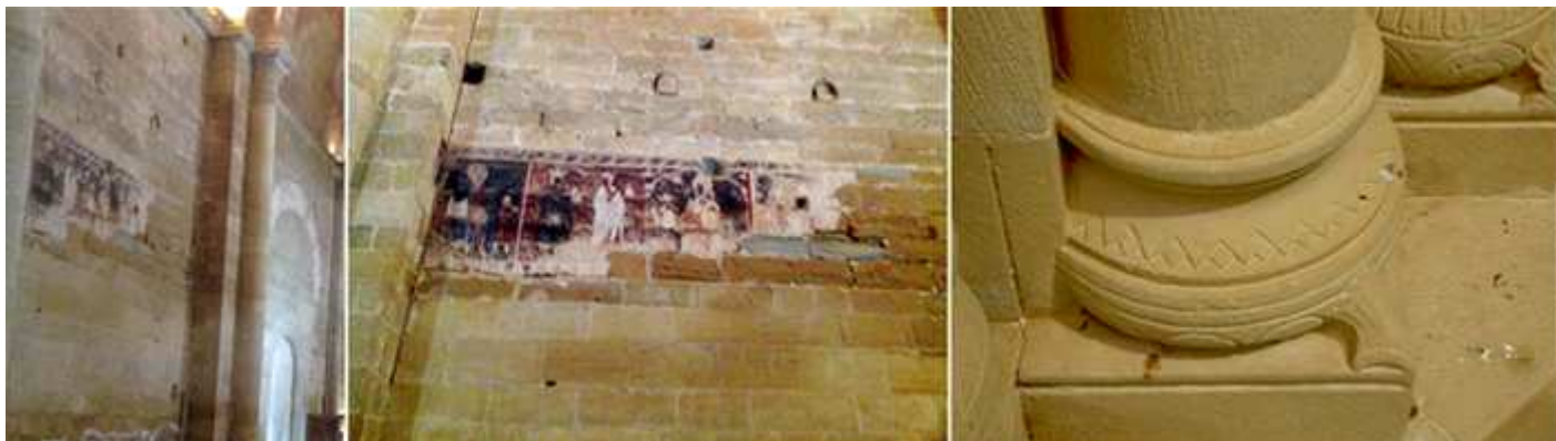
❶ En el muro del Evangelio del tercer tramo se encuentran estas pinturas. ❷ Parece interpretarse la Adoración de los Reyes Magos?. ❸ Detalle de las bases de las columnas adosadas a sus muros de la nave.
