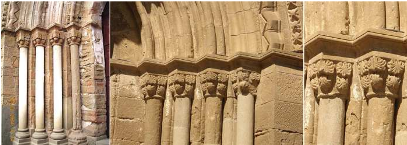
❶ Columnas con basas y capiteles con motivos vegetales del lado izquierdo. (alguna columna ya restauradas) ❷ Y las del lado derecho. ❸ Sus capiteles formados por seis hojas con gran relieve.
