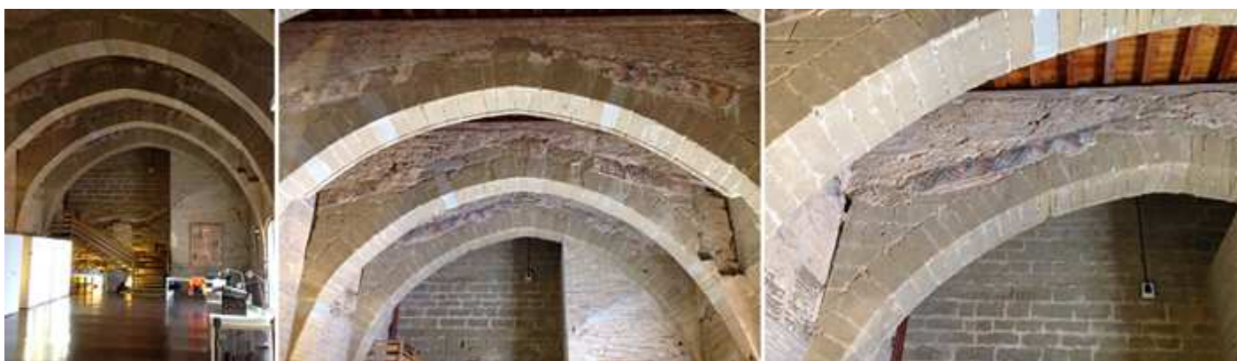
❶ Desde el exterior se accede por una escalera, por lo que el acceso es independiente de la visita del monasterio. ❷ En la restauración de estos aposentos aún podemos ver algunos trozos (muy pocos) con restos de sus pinturas. ❸ Sus arcos ligeramente apuntados.
