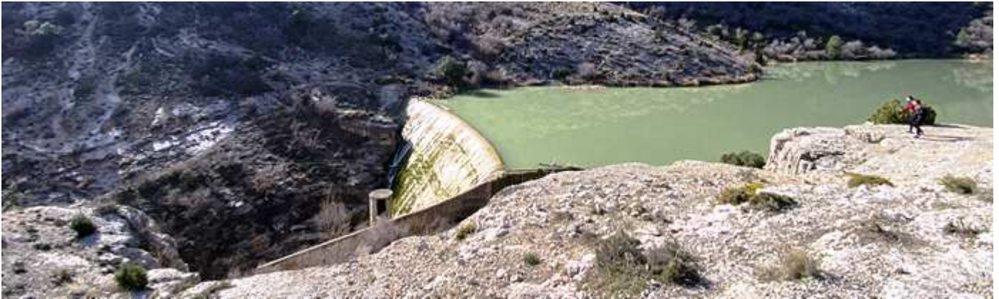
❶ La presa de Aliaga con una superficie de embalse de 20ha. Y su altura de 20m. .
