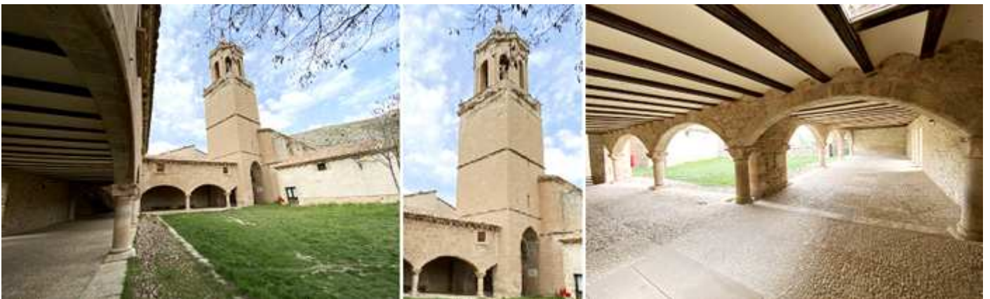
❶ Galería porticada renacentista. ❷ A los pies de la torre bajo una bóveda estrellada se encuentra su portada. De dovelas molduradas en su arco de medio punto con pilastras acanaladas, y sobre este primer cuerpo un entablamento sobre el que se aloja una hornacina avenerada con sendas columnas y un frontis triangular. ❸ El pórtico tiene forma de L y sus arcos son rebajados sobre gruesas columnas. En uno de sus recodos esta la Puerta del Cierzo y la parte alta del pueblo.
