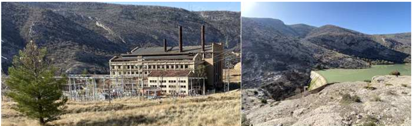
❶ Antigua central térmica de ERZ en Aliaga. ❷ La presa aprovecha el estrechamiento del río en la Hoz Mata y está construida en hormigón.
