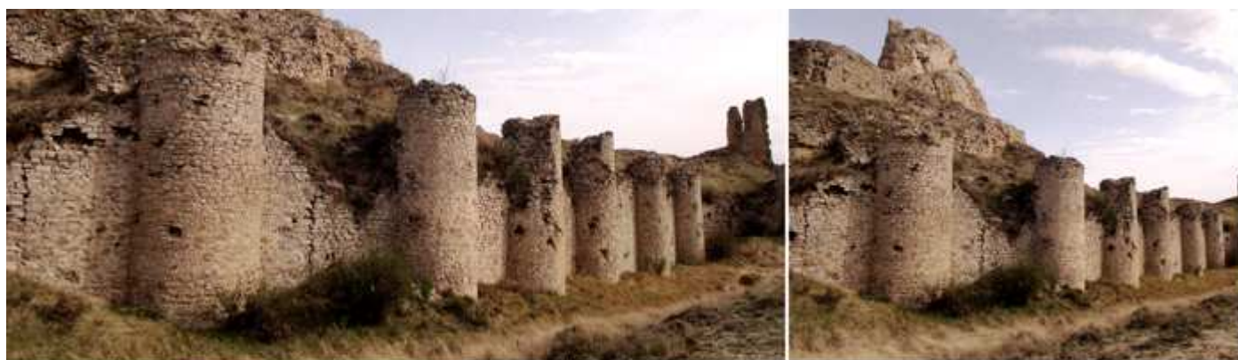
1 La parte de murallas mejor conservada con sus cubos redondos. 2 Solo se conserva su parte central y 12 torreones. Fotos: Wikipedia Attribution-Share Alike 3.0 Spat.
