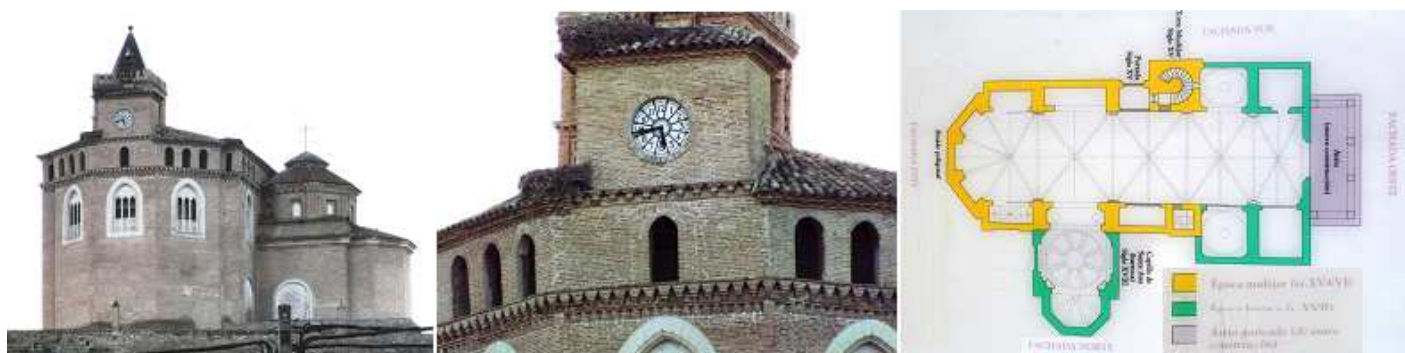
❶ Detalle del ábside poligonal y a su derecha la capilla de Santa Ana. ❷ Galería de arquillos coronada con la torre del reloj. ❸ Plano tomado del cartel informativo con la planta del templo y las fases de su construcción.
