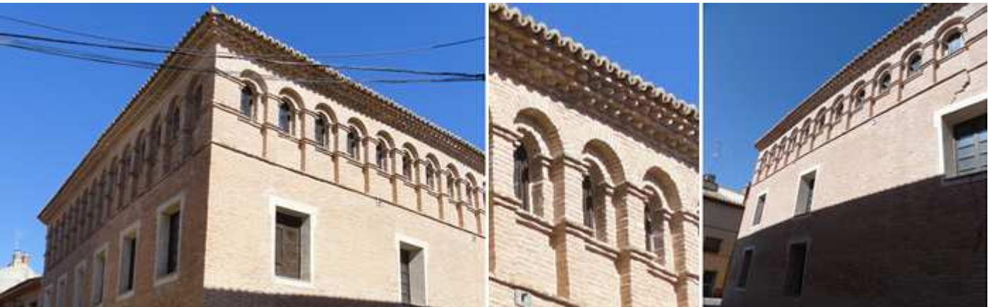
❶ Galería de arquillos de medio punto que presenta tres líneas de impostas corridas. ❷ A la altura de sus arcos, debajo de las ventanas y la línea divisoria de esta planta. ❸ Fachada lateral a la calle Espejos.
