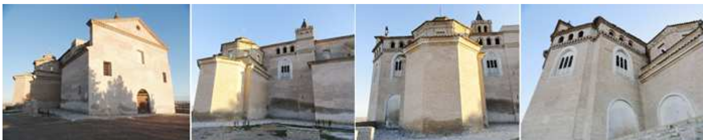
❶ Fachada de la Asunción. ❷ Lateral de la epístola. ❸ Capilla Santa Ana con su cimborrio ❹ Detalle del ábside.
