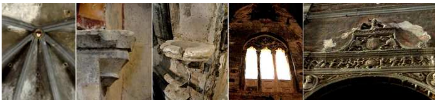
❶ Detalle de los nervios moldurados con triple bocel y la clave de la bóveda de la cabecera. ❷ Detalle arquitectónico. ❸ Pila agua bendita junto a la puerta de la Epístola. ❹ Ventana central del ábside con la decoración sobre sus arquillos trilobulados. ❺ Decoración del portal de la capilla del Santo Cristo.
