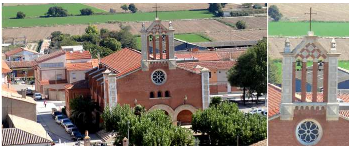
❶ Panorámica del templo con amplios contrafuertes entre sus capillas. ❷ Detalle de su estilizada espadaña sobre su rosetón de ocho arcos y con vidrieras.
