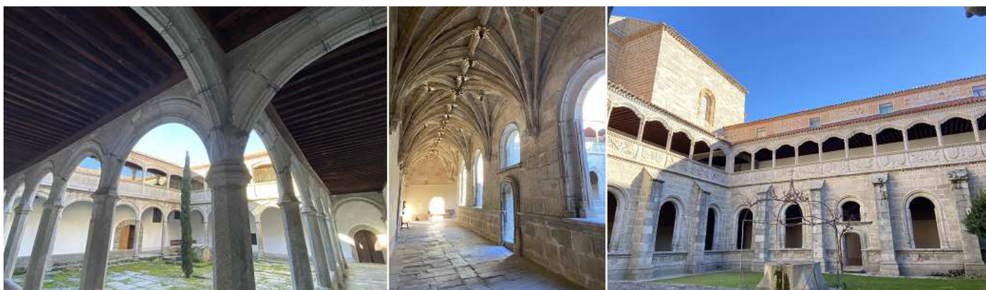
① Claustro del Noviciado con las pandas inferiores con arcos de medio punto con columnas ochavadas, y los del primer piso con arcos muy rebajados (escarzanos). ② Una panda del claustro del Silencio con bóvedas de crucería y sus claves decoradas. ③ Vista de este claustro de su patio, su planta baja está abierta con ventanas de medio punto, lo mismo que sus puertas.
