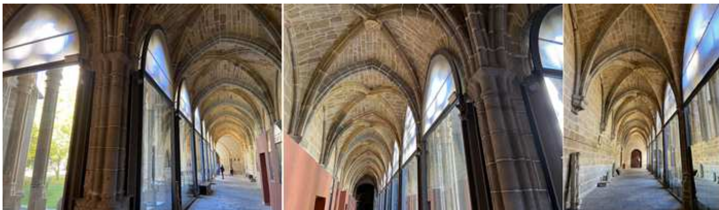
❶ Las pandas del claustro han sido acristaladas para resguardar a los visitantes en los meses de invierno. ❷ Sus triples ventanales con tres óculos sobre ellos y cobijados en un arco apuntado. ❸ Las pandas están cubiertas con bóvedas de crucería.
