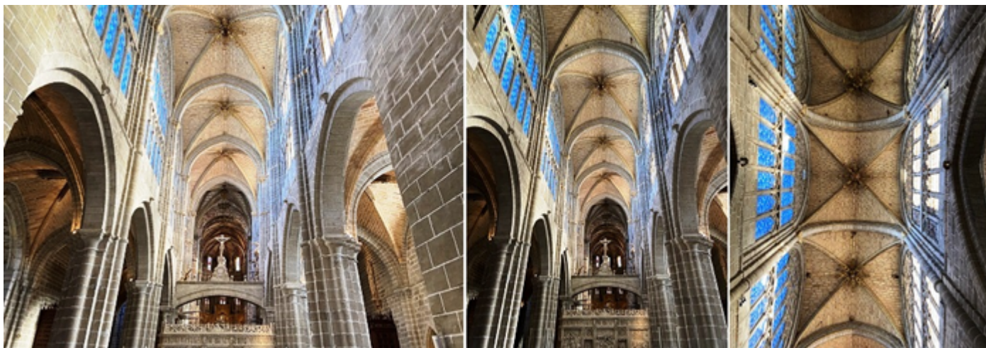
❶ Detalle de la nave central con las laterales con arcos apuntados. ❷ Enfrente el trascoro. ❸ Bóvedas de la nave central y las vidrieras en dos órdenes en cada cuerpo de la nave.
