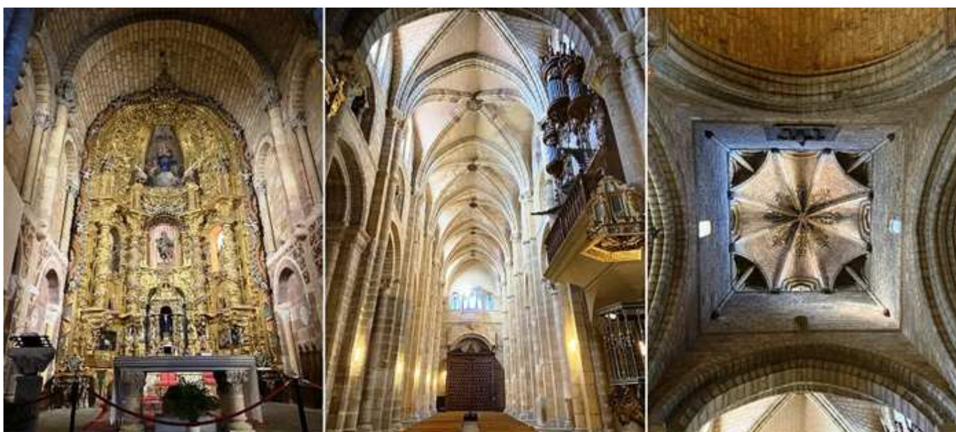
❶ La capilla Mayor cuyo retablo barroco oculta el ábside, a los lados sendos niveles de arcos ciegos. En el mismo está alojado San Vicente y sus hermanas. ❷ La nave central desde la cabecera con el cajón al fondo de sus puertas y a la derecha el órgano. ❸ El cimborrio del crucero, en un lateral se encuentra un Calvario. Este cimborrio data entre 1250 y 1280 y pasa de planta cuadrada a octogonal mediante sus trompas.
