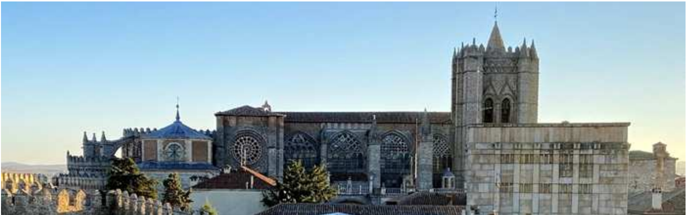
❶ Desde las murallas un punto para observar los detalles del exterior del templo catedralicio, los arbotantes en su ábside, cimborrio, rosetón del brazo de crucero, las vidrieras de la nave o la torre.
