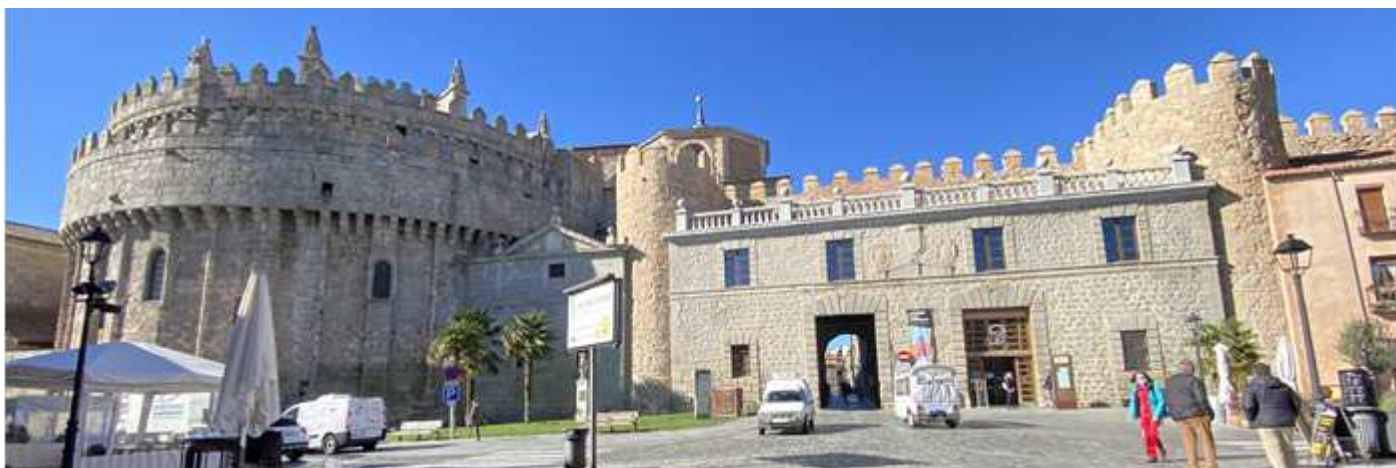
1 Parte posterior de la catedral, su ábside almenado que se encuentra adosada a las murallas como templo y fortaleza. A la derecha acceso a las murallas.
