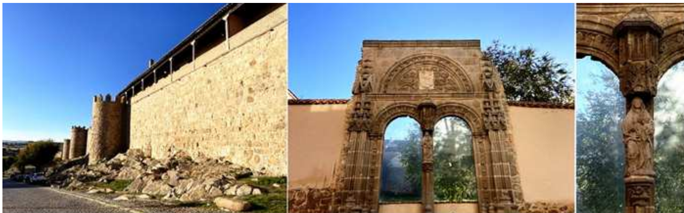
❶ Tramo de las murallas a la izquierda de la Puerta de la Santa. En el Paseo del Rastro. ❷ Puerta gótica en ruinas". Santa Escolástica. Con un tímpano sobre sus puerta doble decorado con ramas y flores y en el centro el espacio del escudo heráldico de los Bracamontes. La arquivolta de este tímpano y la de las puertas estas con flores entre los baquetones, a los lados columnas con pináculos y crestería, es de la segunda mitad del S. XVI. ❸ En el mainel entre las puertas la talla de la Virgen debajo de un doselete. En origen fue un convento cisterciense, y que posteriormente fue transformado en un hospital, esta puerta es el único resto del hundido edificio. Esta puerta fue realizada por Pedro de Vinegra.
