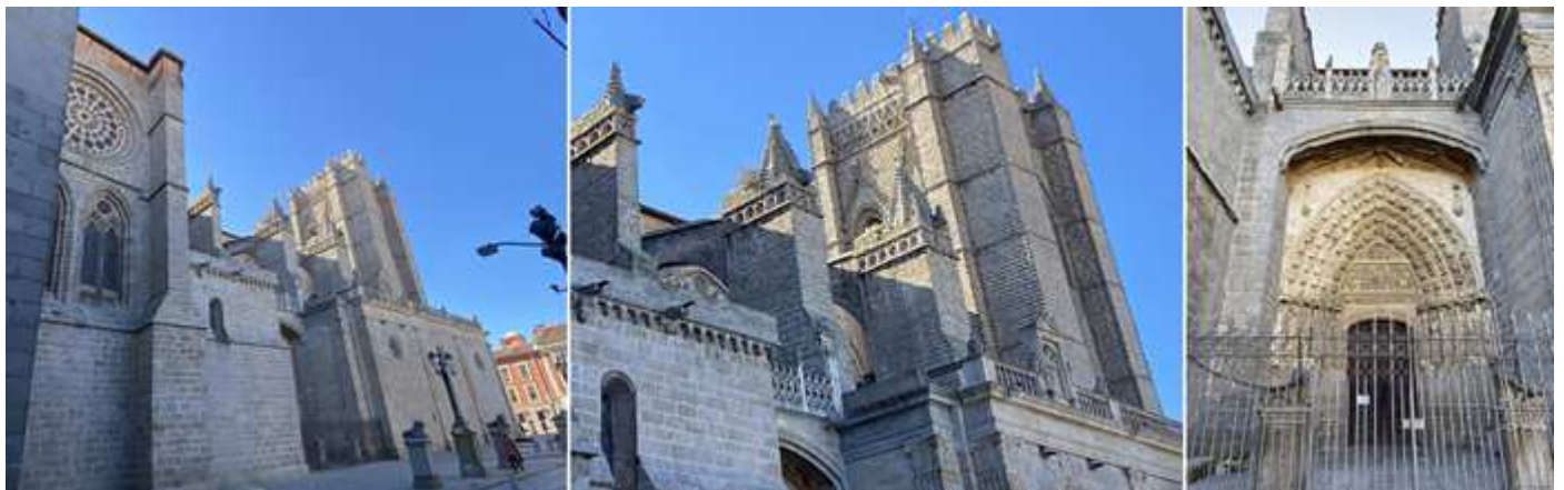
❶ Lateral exterior del lado del Evangelio Con el rosetón del brazo de Crucero. ❷ Detalle de este lado norte de la catedral y la parte posterior de su única torre acabada. ❸ Puerta norte S. XIII o puerta de los Apóstoles, su original ubicación era entre las dos torres dentro de un pórtico hasta el año 1470.
