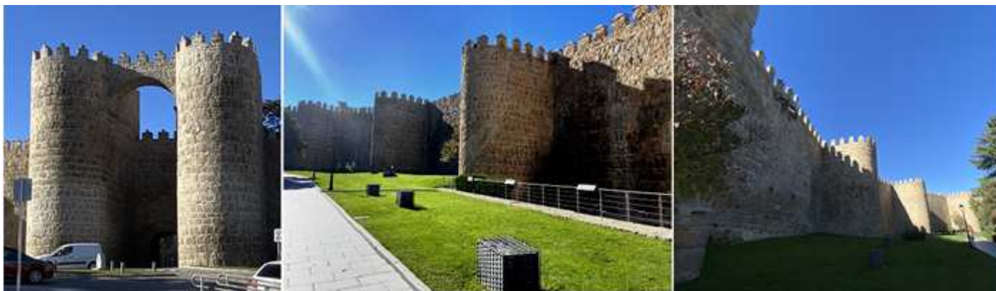
1 La puerta de San Vicente, alojada entre estos altos torreones con la parte superior almenada. 2 Tramo de las murallas en la Ronda Vieja con la puerta de San Vicente al fondo. 3 Tramo hacia la puerta del Mariscal. Los martes de 14 a 16h. Es gratuito.
