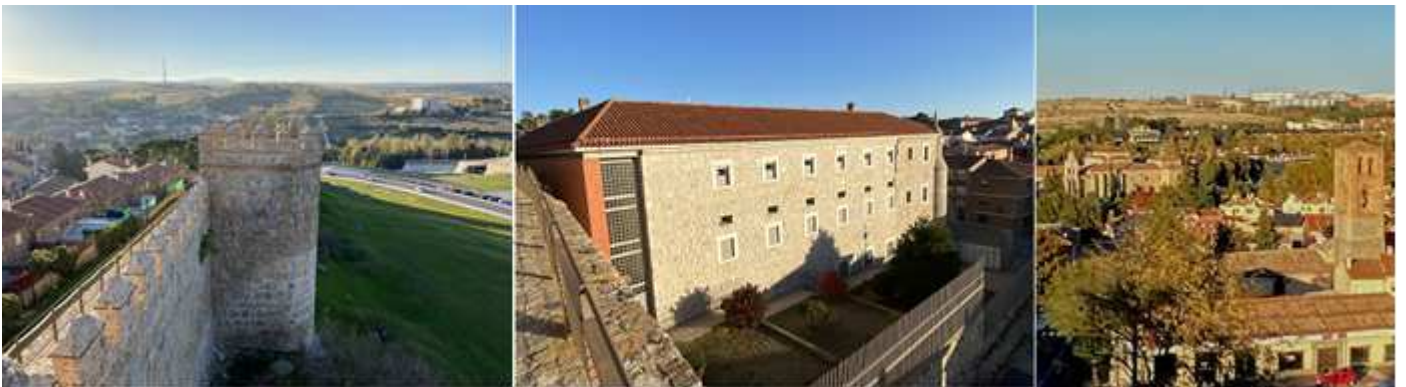
❹ Desde el tramo de las murallas paralelas a la Ctr a Vieja, donde se encuentra otra de las puertas, La del Mariscal. ❺ Archivo Histórico Provincial. ❻ A la altura de la rotonda con la calle Cardeñosa a mano izquierda según recorremos las murallas al fondo la espadaña del Monasterio de la Encarnación y a la derecha de la imagen la torre de la iglesia de San Martín, templo a extramuros del S. XIII, y que ha sufrido muchas transformaciones (1512, 1666, y 1700), y que conserva su torre construida con piedra berroqueña en su primer cuerpo y los siguientes en ladrillo, con arcos de medio punto su campanario.
