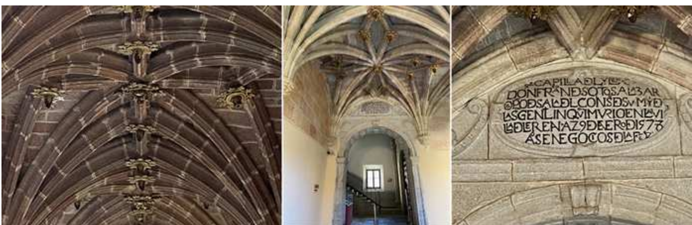
❶ Detalle las bóvedas y las claves decoradas. ❷ Escalera por la que se sube al coro de la iglesia. ❸ Inscripción sobre el arco.
