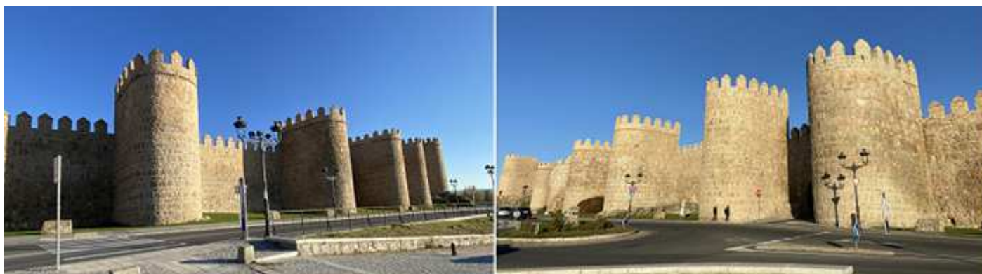
❶ Los cubos de las murallas sobre salen notoriamente de las mismas para facilitar las acciones defensivas. ❷ Ante esta pequeña rotonda se encuentra la Puerta de Adaja y a su izquierda de forma frontal la Avda. de Madrid.
