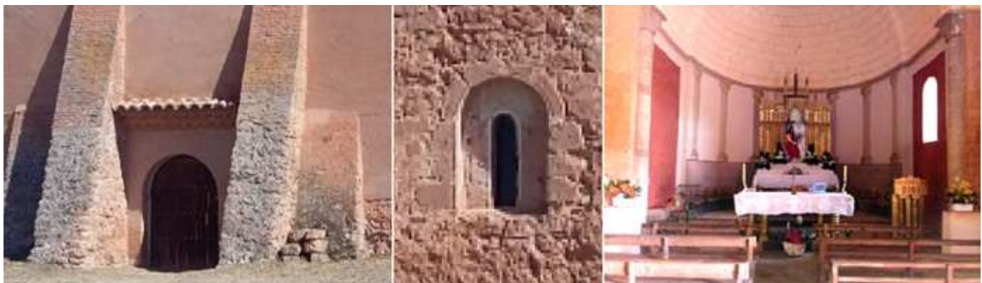
❶ Su sencilla puerta con arco medio punto de ladrillo con imposta y jambas de piedra cubierta con un alero también de ladrillo en el lado de la Epístola entre dos gruesos contra fuertes. ❷ En este lateral en el tramo del presbiterio dispone de una ventana de medio punto. ❸ Su cabecera elevada por unos escalones y con un arco triunfal con dos columnas de piedra redondas adosadas y con unos capiteles con motivos vegetales. Y cabecera con bóveda apuntada. Fotos Ayuntamiento.
