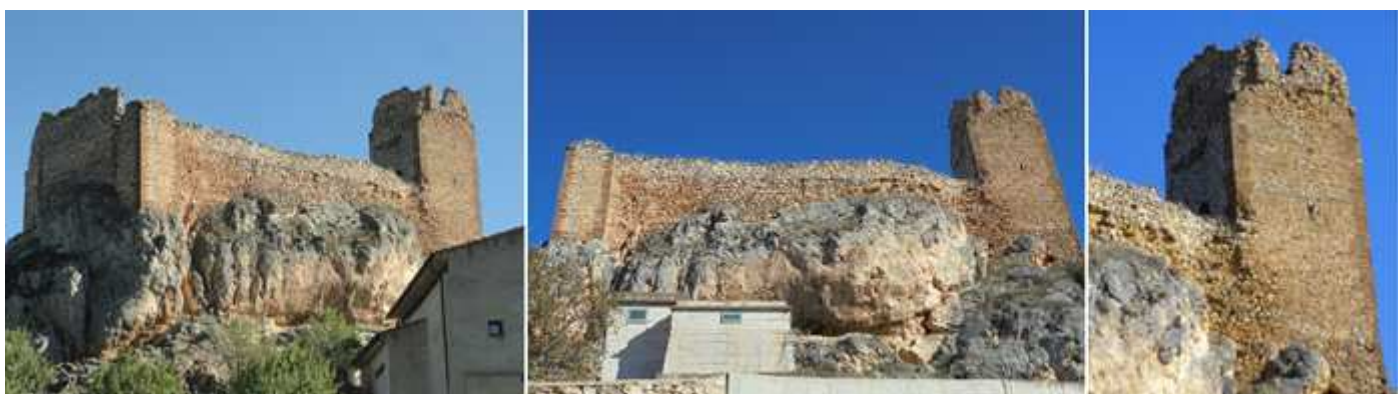
1 Sus lados se asoman a los cortados. 2 Por lo que dispone de una torre de más de 7m. en la zona más vulnerable para su defensa. 3 Su torre construida con sillería en sus ángulos y mampostería el resto. Fue fortificado por Pedro IV en 1357.
