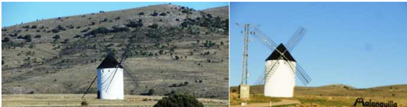
❶ Estampa del molino, con su palo de gobierno que servía para poder orientar girando la mejor dirección del viento. Y poder aprovechar la energía eólica. ❷ Dada la proximidad de la carretera es un reclamo publicitario de la localidad.
