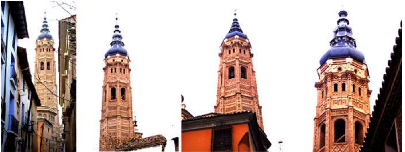
1 Diversas tomas de la torre. 2 - 3 - 4 Destacan la torre campanario de estilo mudéjar iniciada hacia el S. XV y terminada con un chapitel de 1770.
