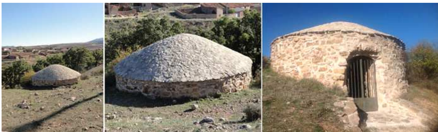
❶ Este pozo está excavado en la roca y completado con la construcción superior con mampostería. ❷ Tiene unas amplias medidas, con una altura de 8 m x 5m en su interior. ❸ Su puerta de acceso.
