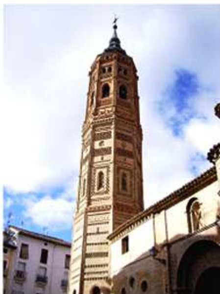
1 - 2 - 3 Imágenes de diferentes puntos de la torre de San Andrés, algo más baja en altura que su próxima de la colegiata de Santa María con bellos trabajos con la decoración mudéjar de sus ladrillos a base de esquinillas, cruces y rombos. Es de planta octogonal y de tres cuerpos.
