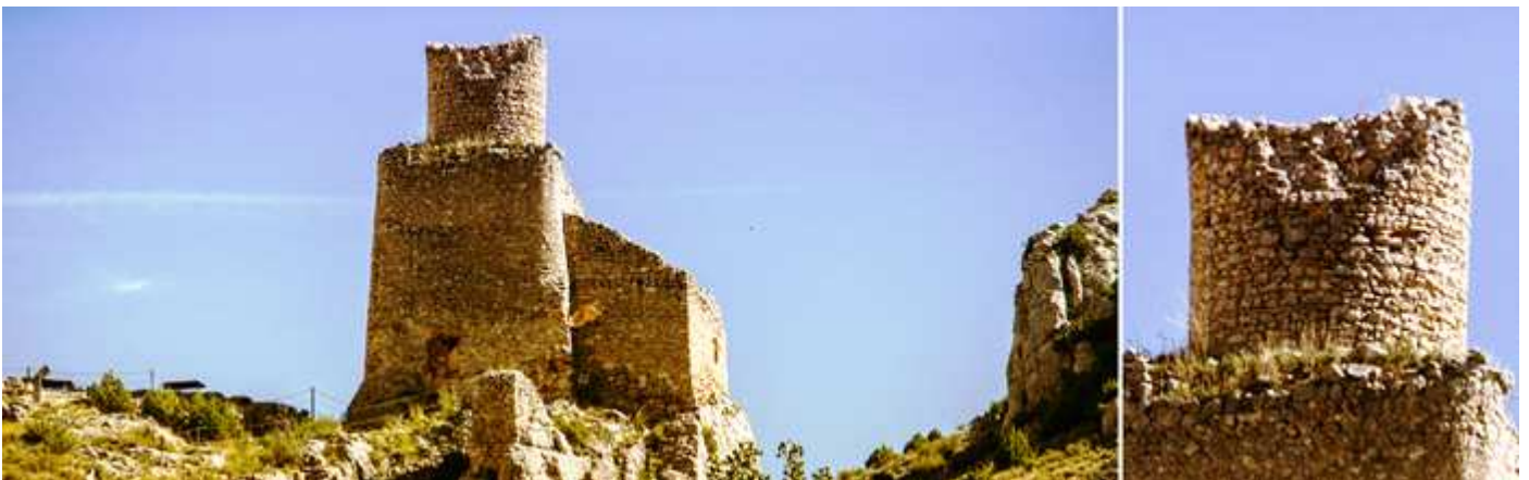
❶ Ubicado sobre este espigón rocoso, junto a un cañón del río Henar. Se compone de una muralla que se adapta al terreno, y en su interior se alza una torre circular. Esta construido con tapial y mampostería. El cuerpo central y a los lados dos construcciones adosadas. ❷ Detalle de su torre realizada en mampostería. Fotos: Wikipedia CC BY-SA 4.0
