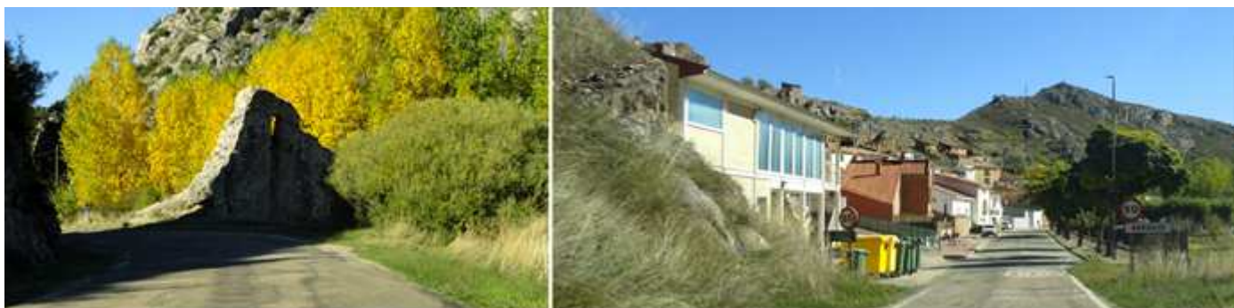
❶ Curiosa formación que fue atravesada por la carretera y a su derecha conserva un espacio adintelado como si fuera una puerta. ❷ Las construcciones en la parte baja junto a la Ctrº. A-1502.
