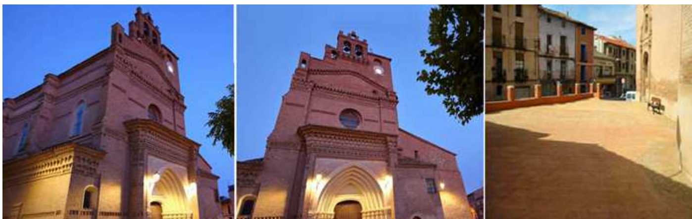
❶ La decoración exterior de sus muros empleando los ladrillos con labores de bandas de esquinillas en dientes de sierra y al tresbolillo. ❷ Frontal donde su portada se encuentra en un bloque adelantado que en sus lados la decoración en ladrillo lo mismo que su parte superior y el alero de esta puerta. La portada que con sus cinco arquivoltas en degradación confieren el aspecto de abocinada. Estas descansan en unos capiteles corridos con decoración de cardinas y figuritas de personas y animales. ❸ El amplio espacio en el lado de la Epistolar cerrado con valla (donde existió el cementerio) y en el primer cuerpo de la nave posee una
