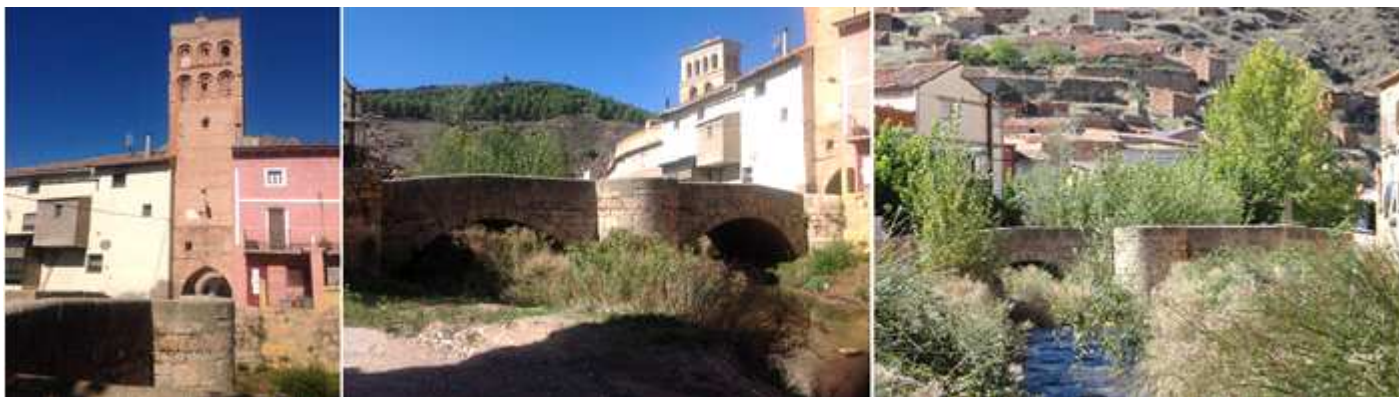
❶ Calzada del puente medieval sobre el río Manubles y al fondo la torre con la puerta. ❷ En su parte central posee los tajamares circulares. ❸ Al fondo parte de las bodegas que se apiñan en esta falda de la montaña.
