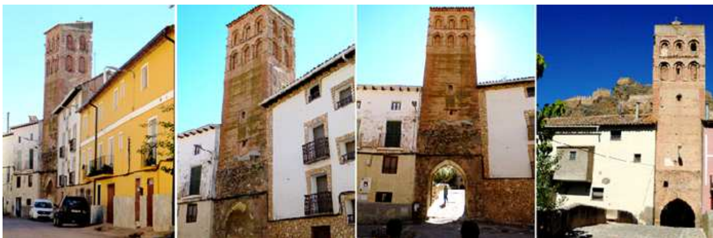
❶ Esta torre que es el símbolo de Torrijo de la Cañada. ❷ Esta puerta toreada formaba parte de la muralla que defendía la localidad de los ataques de las tropas de Castilla en la Guerra de los Pedros. ❸ Sobre un arco apuntado que hace de tránsito se eleva esta torre rectangular del S. XIV. ❹ Parte posterior con el puente ante la misma.
