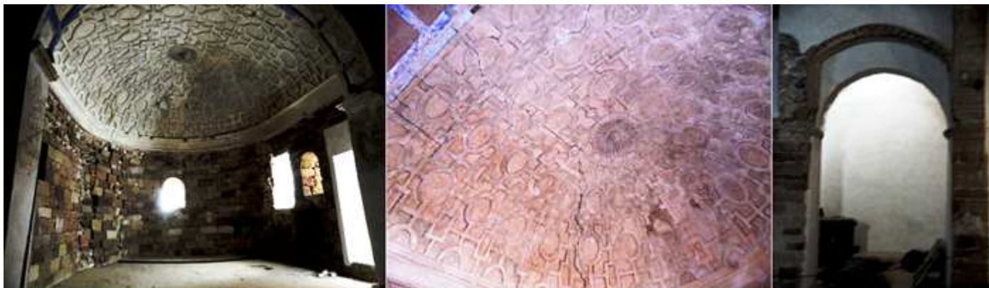
❶ En su ábside se decoró su bóveda con una yasería. ❷ Detalle de la decoración de su bóveda. ❸ En el lateral epistolar se encuentra la sacristía de la capilla de la Virgen del Río, de planta cuadrada.
