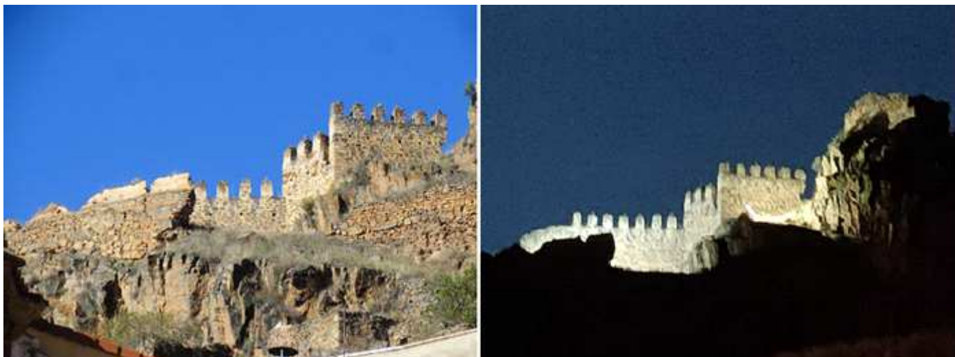
❶ La construcción se levanta sobre la roca viva con argamasa y tapial. ❷ La misma secuencia iluminada por la noche. Foto: Julia Bustinza.
