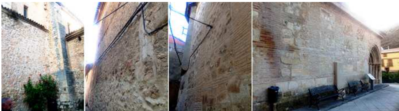
1 En el exterior de su lado epistolar tiene adosada alguna construcción. 2 Con su cabecera recta. 3 En la construcción se aprecia la alternancia del los sillares con la cantería irregular 4 Y también hay aparejo de ladrillo que forman hiladas.
