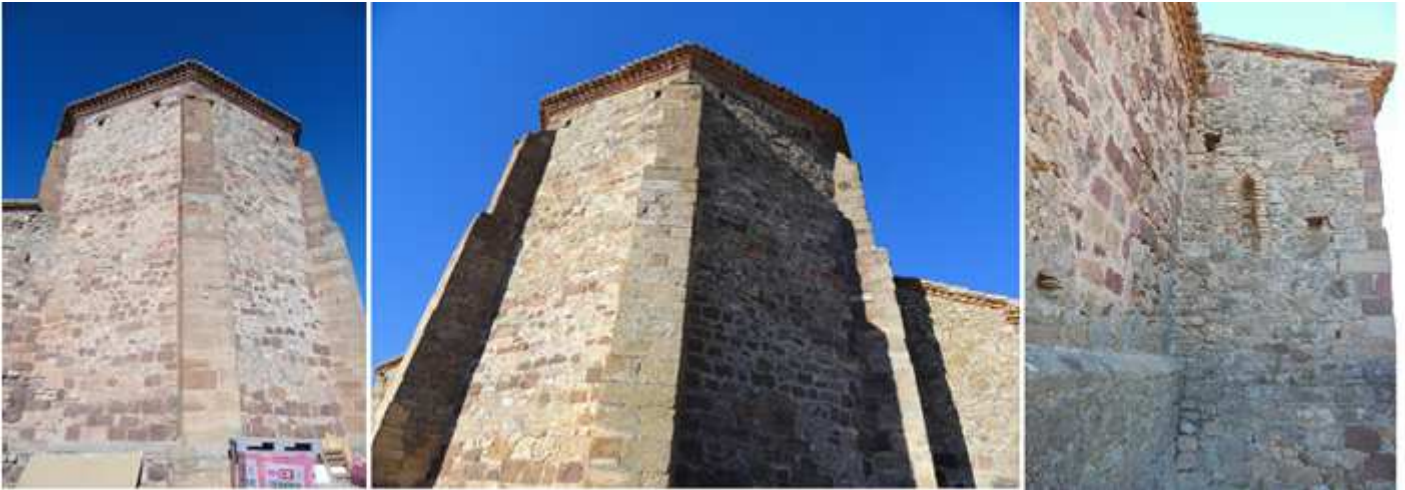
❶ La cabecera poligonal. ❷ Compuesta por dos lienzos y contrafuertes escalonados. ❸ Lateral del Evangelio con la capilla que tiene adosada.
