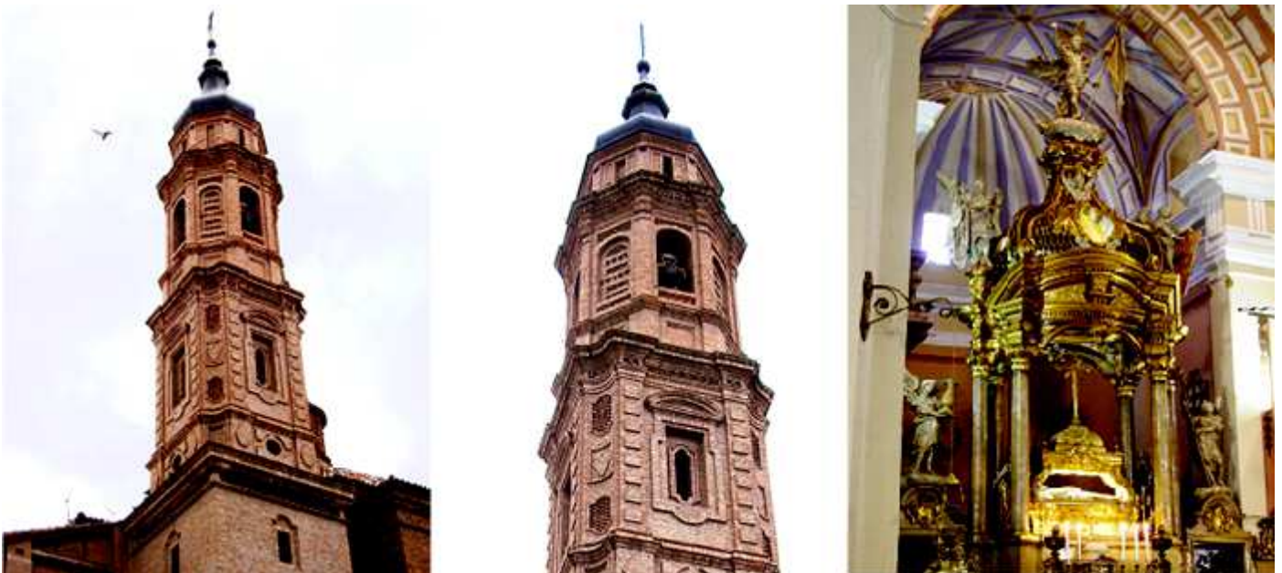
1 Dos torres dispone el templo en su fachada. 2 Realizadas en ladrillo con planta cuadrada, que pasa en el cuerpo siguiente a tener sus ángulos ligeramente curvados y los dos últimos de planta octogonal. 3 Baldachino del Altar Mayor, sobre seis columnas de mármol, donde está alojado un Cristo yacente.
