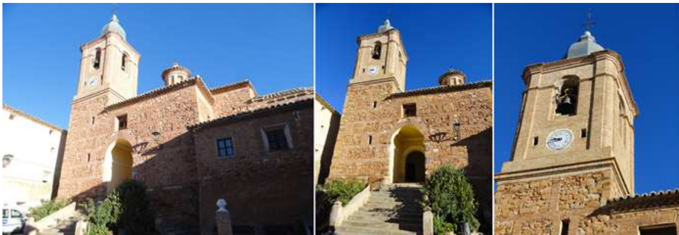
❶ Fotos exteriores del templo. ❷ Construida con cantería irregular e hiladas de ladrillos, su puerta elevada ante una amplia escalita. ❸ El cuerpo superior del campanario completamente realizado con ladrillos y amplios vanos de medio punto para sus campanas, posee un reloj y chapitel con silueta bulbosa. La torre se compone de dos cuerpos es fruto de la remodelación del templo en el S. XVII. Posee una puerta cegada en el muro oeste
