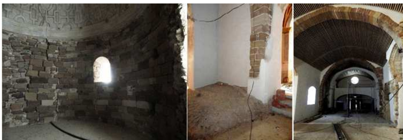
❶ Su ábside por el exterior posee una buena piedra sillar, sin embargo su interior está realizado con sillarejo. ❷ Detalle en el presbiterio de su arco original sobre la propia roca. ❸ Vista del templo desde la cabecera con un coro elevado sobre un arco rebajado.
