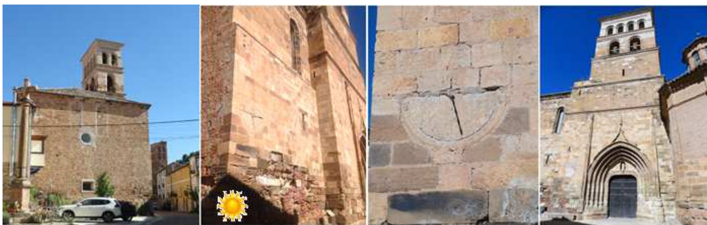
❶ El hastial del templo hacia la plaza de España y ante la Cruz del Arenal que en ella existe (que según la tradición en este punto fueron martirizados los santos patrones). En esta fachada se aprecian las dos ventanas que fueron cegadas. ❷ En el ángulo izquierdo de la fachada epistolar posee un reloj de sol. ❸ Tipo: horizontal, rectangular. Con las horas excavados, sin numeración. Orientación al mediodía Traza: de las 5 a las 6 h?. p.m.. Gnomon de varilla, la actual no es de apoyo, pues conserva su orificio. En los extremos del semicírculo posee dos espirales. ❹ Sobre la portada gótica del templo se eleva la torre.
