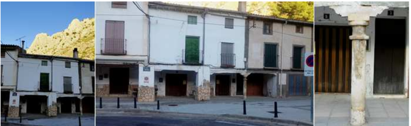
1 Pequeñas construcciones de tres alturas. 2 Con la parte inferior porticada. 3 Alguna de sus columnas de piedra con zapatas. Su caserío se alarga junto el curso de río Henar y la carretera A-2501.
