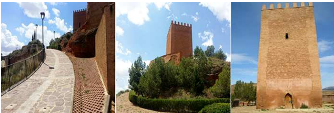
❶ Zona de acceso al castillo, en la explanada se alza con planta cuadrada y con una puerta de arco apuntado con dovelas lisas. ❷ Una de sus caras de esta torre con un remate de almenas. A la derecha queda un tramo de la cerca del castillo con una puerta apuntada. ❸ Fachada frontal con su puerta al ras del suelo. Este castillo se encuentra en una posición más elevada con resto al de la Reina. Fotos Ayuntamiento.
