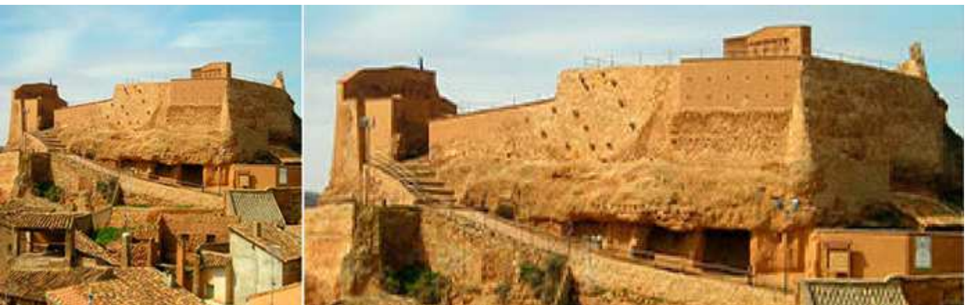
❶ Vista del frontal longitudinal de los restos del castillo, que han sido consolidados. ❷ Vista de los muros perimetrales del castillo por este lado. Fotos: Ayuntamiento.
