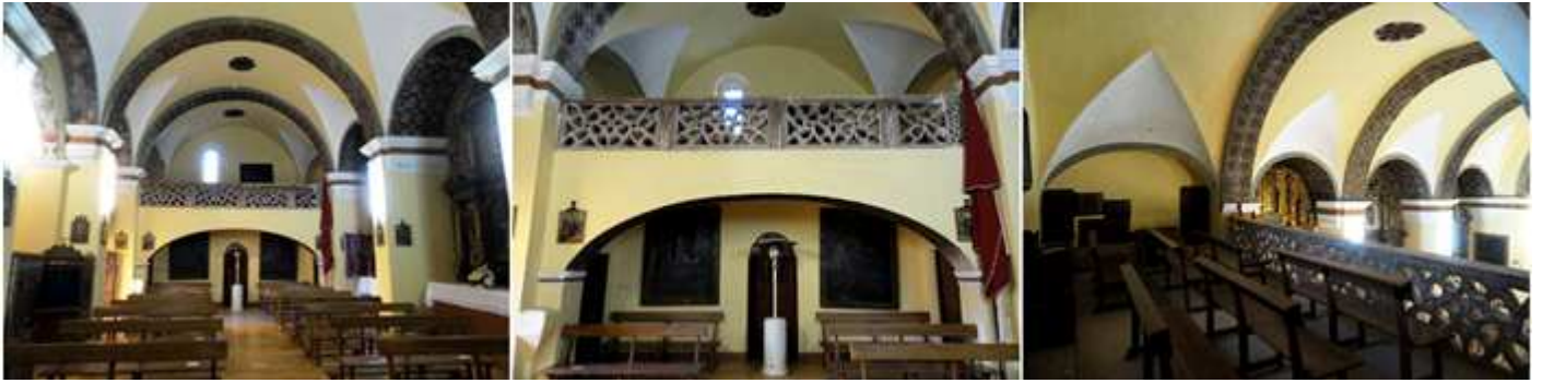
❶ Parte inferior del templo desde su cabecera. ❷ Con un arco rebajado sobre el que se encuentra el coro y con una balaustrada calada de yeso mudéjar. ❸ El Coro y los arcos fajones decorados con yeserías policromadas.
