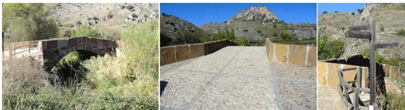
1 Posee un único ojo con un arco rebajado y su tablero ligeramente inclinado a dos vertientes. 2 Detalle de su calzada de canto rodado. 3 Cartel indicativo a la Cueva de la Cabrera (Bijuesca), Berdejo 150m. y Torrelapaja a 4 km.
