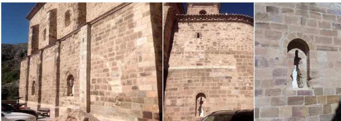
❶ En el quinto tramo de la nave se aprecian los rasgos de arcos. ❷ Tramo del presbiterio donde dispone de una tercera ventana de aspillera dentro de un arco. ❸ La citada ventana.
