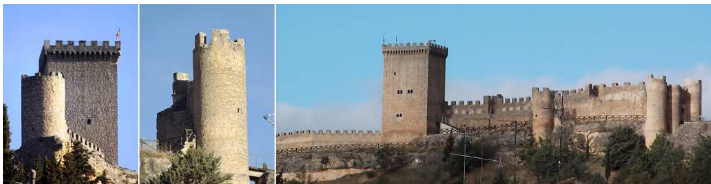
❷ Cubo de la muralla en la zona más extrema. ❸ El mismo cubo. ❹ Lateral del castillo donde destaca su torre del Homenaje.
