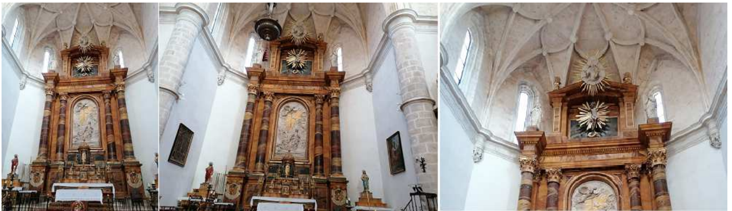
❶ Cabecera poligonal. ❷ Con un retablo neoclásico de 1783 diseñado por Ventura Rodríguez, de una calle con dobles columnas a los lados y en su parte central un relieve presidido por los ángeles y el Espíritu Santo, sobre el entablamento como ático un Santo Cristo y que a los lados sendas esculturas de la Virgen y San Juan, sobre el frontis triangular la figura del Santo Padre. ❸ Detalle de la bóveda de crucería de la cabecera. Fotos: Oficina de Turismo.
