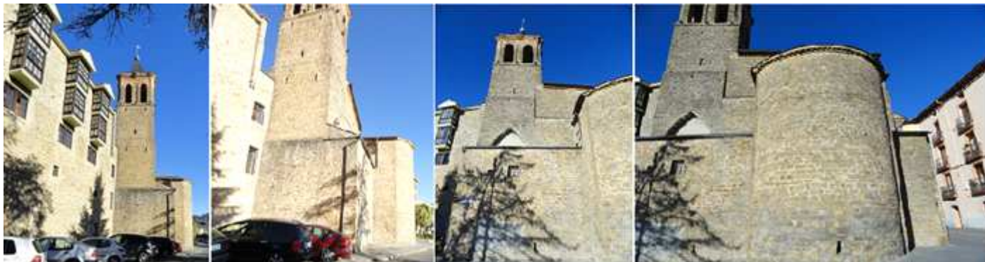
❶ Parte posterior del monasterio a la avda. Oroel. ❷ Con la torre de planta cuadrada adosada al lateral epistolar del templo. ❸ Cabecera de la iglesia. ❹ Y el ábside semicircular solamente abierto abajo para la cripta.
