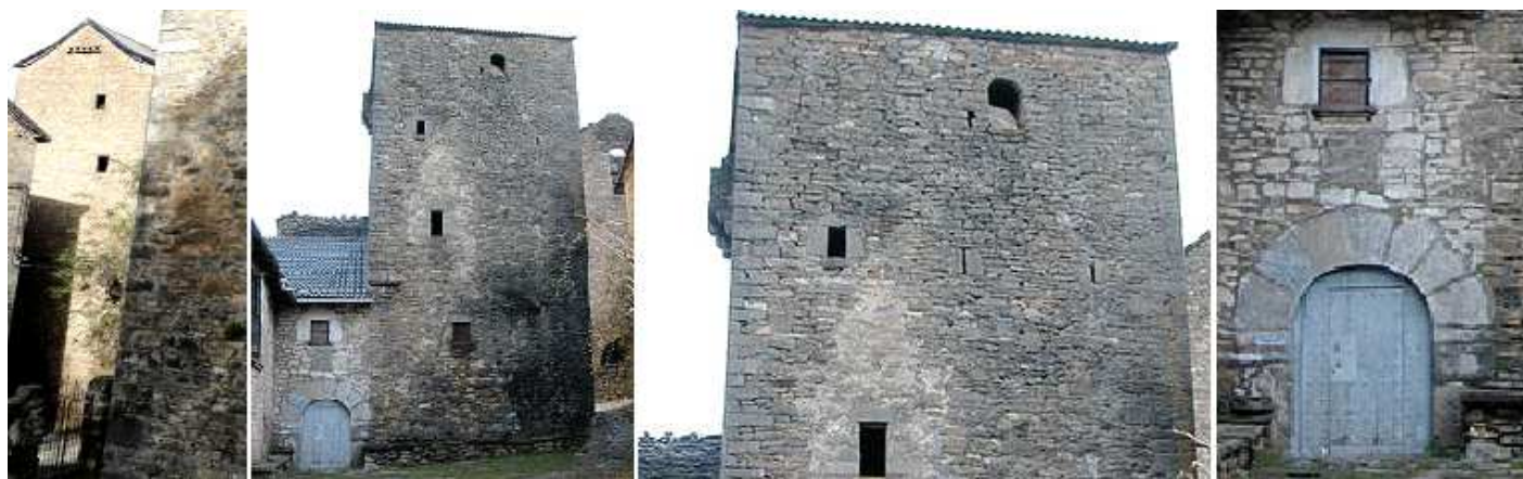
❶ Torre Casa Agustín junto a la iglesia. De un solo cuerpo y 4 pisos. ❷ Construida en el siglo XVI, fue remodelada y ampliada posteriormente. ❸ Parte superior con un matacán a su izquierda y con ventanas adinteladas y aspilleras. ❹ Portada del edificio que se le prolongó posteriormente, y en este lateral disponía de su entrada original.
