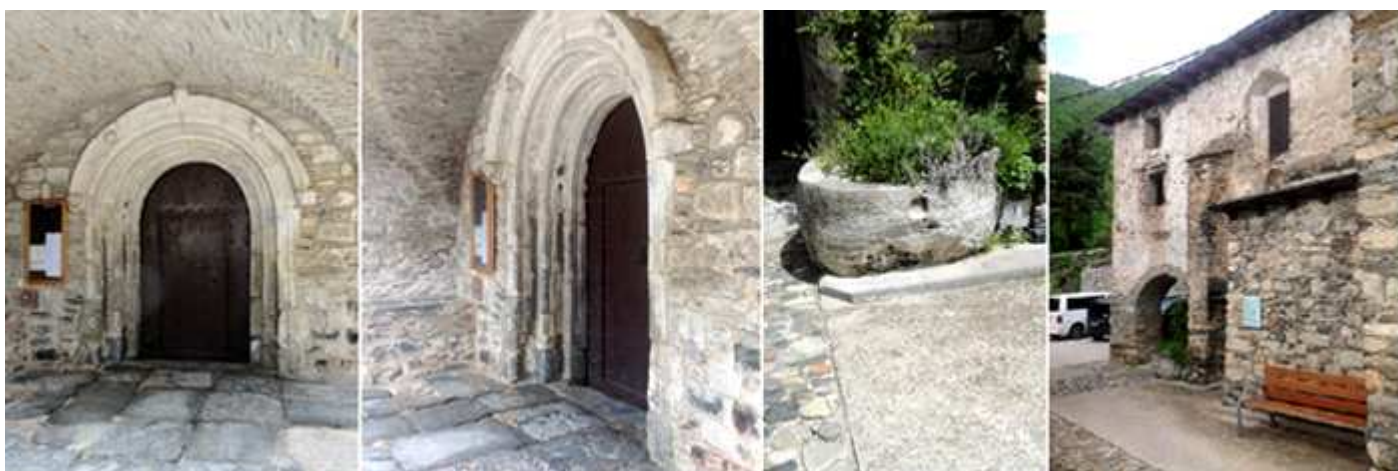
❶ Su puerta cubierta con tres arquivoltas a bocel con mensulillas en su guardapolvo. ❷ En sus arquivoltas tiene repartidas cinco alto relieves antropomórficos. ❸ Pila usada como jardinera. ❹ Lateral de la Epístola donde sobresalen algunas capillas.
