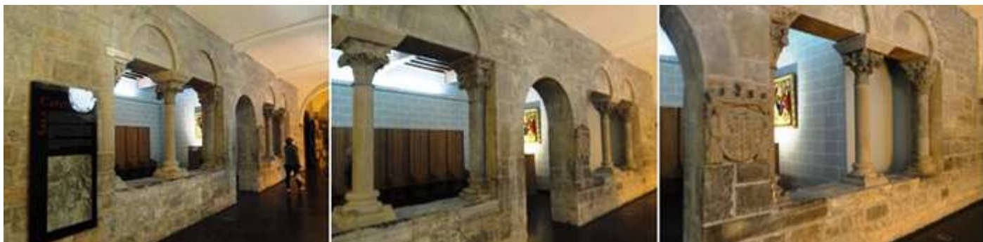
❶ La sala Capitular está abierta por dos dobles ventanas y un arco de medio punto de puerta. ❷ En sus arcos de las ventanas dispones de columnas con capiteles tallados con motivos vegetales. Arpías, o lazos. ❸ A la derecha de su puerta un amplio escudo.
