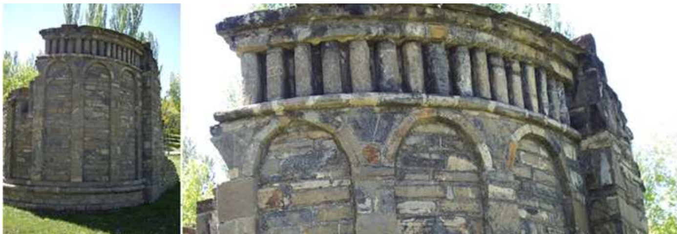
1 Ábside de Santa María de Gavín. 2 Instalada en el parque de Sabiñánigo.
