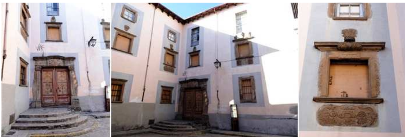
❶ Su puerta sobre un estrado de escaleras con dos columnas rectas decoradas, y un entablamento con un frontis que la parte central curva ostenta un escudo. ❷ m. ❸ Ventana adintelada con el escudo del Aragón y en la parte inferior con el capelo y las borlas eclesiásticas.
