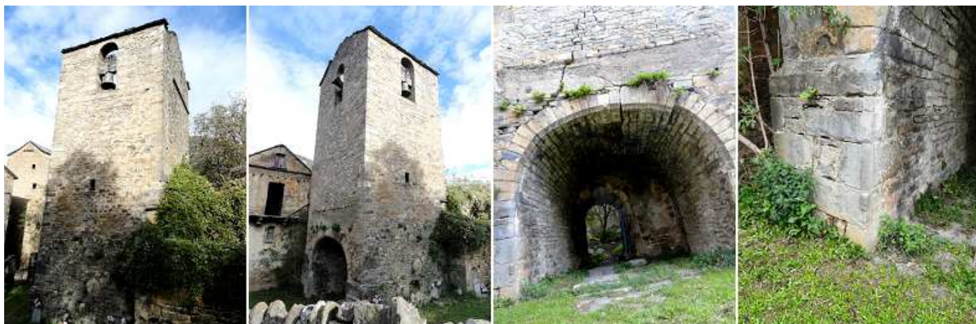
❶ Campanario por el lado de la Epístola. ❷ Perspectiva de la torre y su arco de entrada al interior del templo. ❸ Casi toda la base de la torre está ocupada por el arco que ya ha cedido algo con el tiempo. ❹ En una de las esquinas inferiores hay una carita en la parte inferior.
