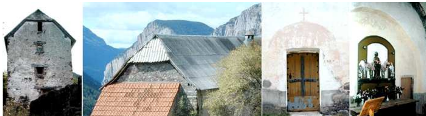
1 Fachada con las ventanas adinteladas de los diferentes pisos. 2 Fachada con la sacristía adosada. 3 Puerta de entrada a la ermita. 4 Fachada con el santo. Fotos: Marta Puyol Ibort (SIPCA – www.sipca.es )
