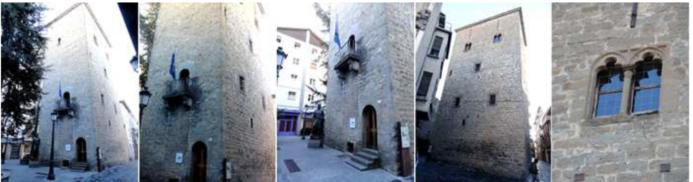
❶ Tiene planta cuadrangular. ❷ Construida con piedra sillar. ❸ Puerta de medio punto. ❹ Uno de los laterales. ❺ Con ventanas ajimezadas con arcos trilobulados con mainel.
