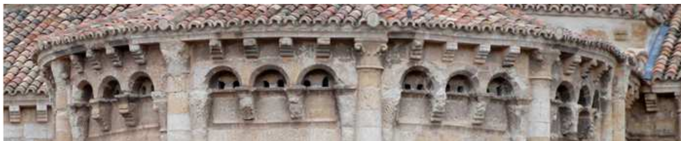
❶ Bajo el alero con canecillos de rollos y triple arquería en cada paño que igualmente se sustenta en canecillos.
