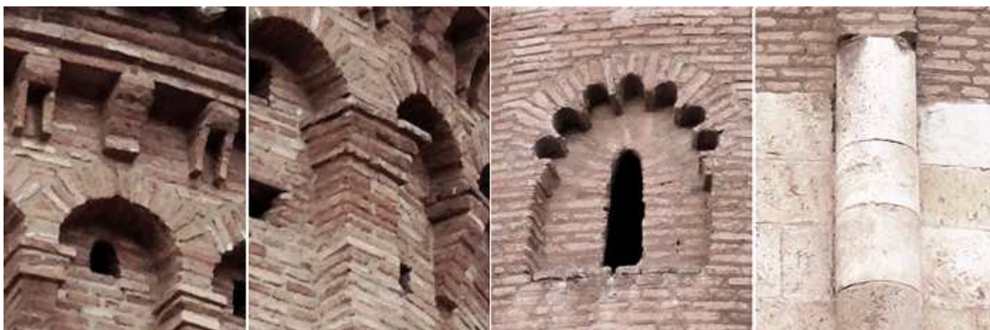
❶ Canecillos escalonados como rollos otros abiertos con ladrillos verticales. ❷ Sus arquillos ciegos sobre las columnas adosadas rectas y sobre ménsulas con ladrillos escalonados. ❸ La ventana central del ábside con siete arquillos polilobulados y una apertura de aspillera. ❹ Las columnas adosadas del ábside son redondas y sobre estas comienza la construcción de ladrillo de sección cuadrada. En los años 60 del siglo pasado se encontraba prácticamente en ruinas.
