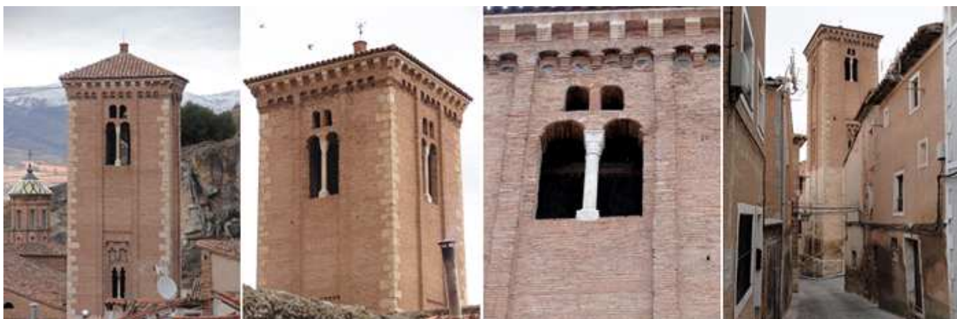
❶ La torre de planta cuadrada de Santo Domingo contemplada desde el perímetro de las murallas. ❷ En la parte superior posee dos parejas de ventanas en cada cara las inferiores con un parteluz con columna y capitel de piedra con volutas (moderno). Esta torre es la más antigua mudéjar conservada en Aragón. ❸ Bajo su alero con unos canchillos de rollos y platos de cerámica una línea de arquillos con otros platos de cerámica en verde. ❹ Bajando por la calle San Miguel para llegar a la iglesia.
