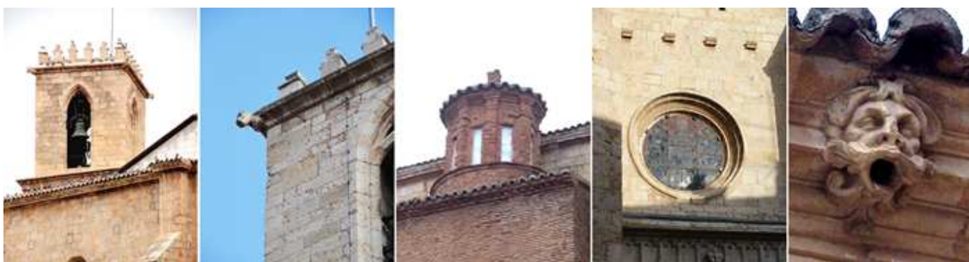
❶ Último cuerpo rematado con almenas. ❷ Esquina con una gárgola. ❸ Linterna de una capilla lateral. ❹ Vidriera del óculo sobre la puerta del Perdón. ❺ Gárgola de la nave lateral.
