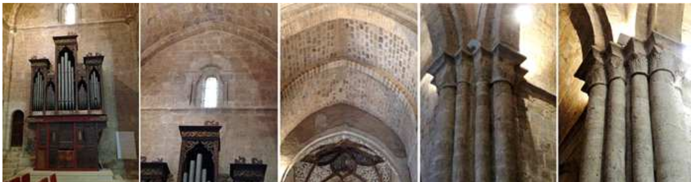
❶ Órgano del S. XVI(1575), que el siglo XVII a finales se le añadió la parte superior. ❷ La ventana del este lado del crucero. ❸ Los arcos fajones y la bóveda de la nave central. ❹ - ❺ Dos agrupaciones de columnas con sus capiteles con hojas anchas de palmas.
