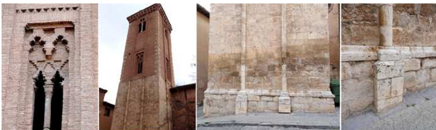
❶ En el segundo cuerpo, como el tercero realizado en ladrillo, dispone de una decoración de arcos mixtilíneos y dispone de una ventana doble de arcos mixtilíneos con parteluz. Además de decoración en rombos y esquinillas. Sus esquinas son de piedra sillar. ❷ La torre construida su primer cuerpo en piedra sillar. ❸ Y posee columnas redondas adosadas sobre pódium. ❹ Detalle de una de ellas. Su construcción duro del S. XIII al XIV.
