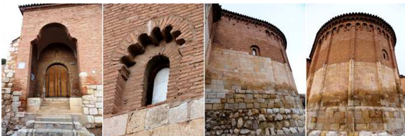
❶ Su puerta de arco de medio punto con una hornacina avenerada vacía y precedida de otra de su atrio con ménsulas muy voladas. ❷ Arcos polilobulados en sus ventanas de raíz andalusí. ❸ Lateral del presbiterio con la ventana anterior. ❹ El ábside está compuesto por seis lienzos con tres arquillos ciegos en su parte superior bajo el alero.
