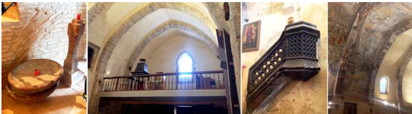
1 Pila agua bendita de taza plana (en realidad hay dos) que están restaurando con un futes de sección cuadrada arqueado, a la entrada del templo. 2 El coro en alto restaurado pero conserva la viga tallada. 3 Púlpito de yesería con celosía calada mudéjar (decoración de lacería). 4 Detalle de los arcos fajones y de sus pinturas que en los primeros tramos se han perdido.
