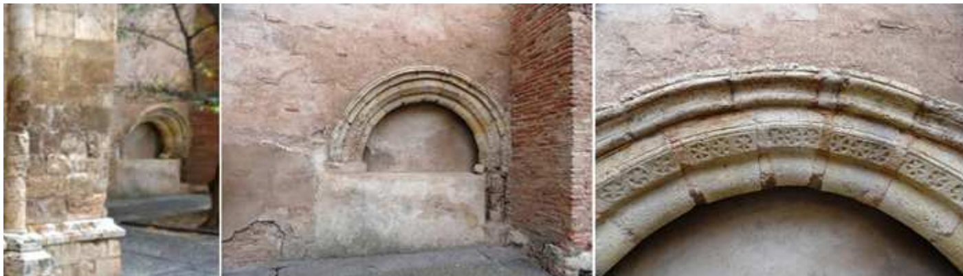
❶ Lateral del lado del Evangelio tras la torre. ❷ Que posee está puerta con dos arquivoltas la interior baquetonada la siguiente con decoración en su frente de rosáceas de seis pétalos, conserva parte de su imposta. ❸ Detalle de las rosáceas.
