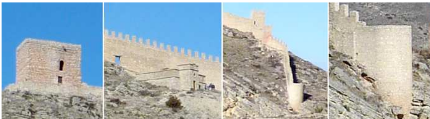
❹ Torre del Andador es una construcción califal. Tiene forma cuadrangular de 10 x 7 m, su parte superior carece de almenas. Esta torre se encuentra a 1240m de altura. ❺ El primitivo sistema defensivo contaba con tres castillos: Doña Blanca, El Señorío y El Andador. ❻ Existen tres tipos de rutas para recorrer las murallas. ❻ Uno de los cubos redondos de la murallas.
