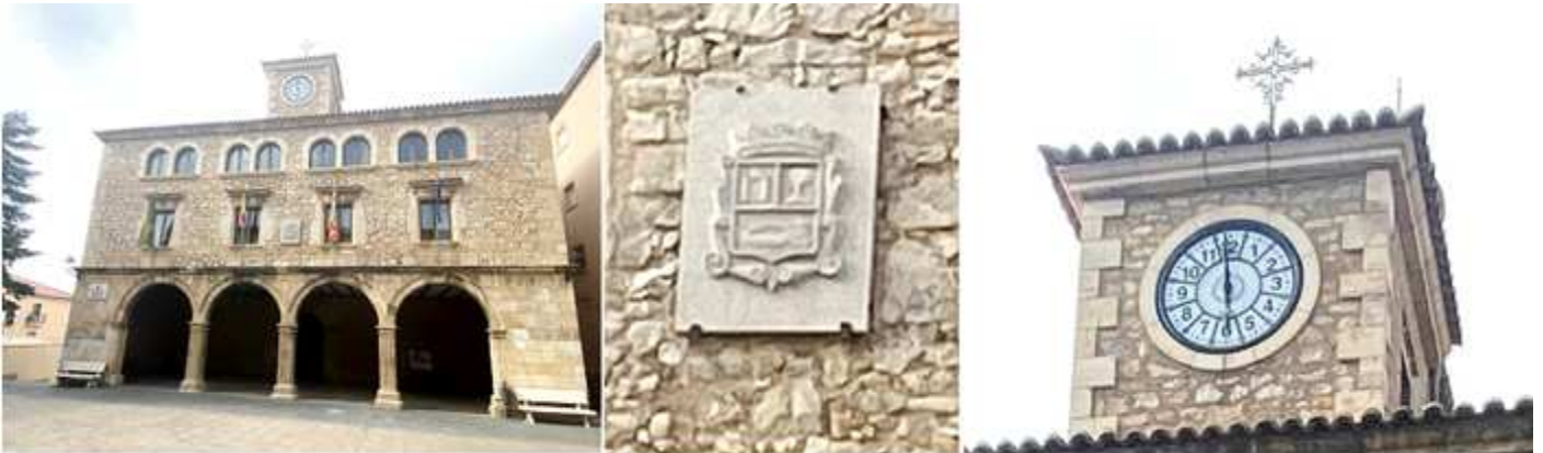
❶ Fachada del Ayuntamiento con su lonja inferior de arcos doblados y realizada con piedra sillar, los cuerpos superiores ya se realizaron con cantería. ❷ En la parte central de su planta noble ostenta el escudo heráldico local. ❸ Detalle de la torre con el reloj.
