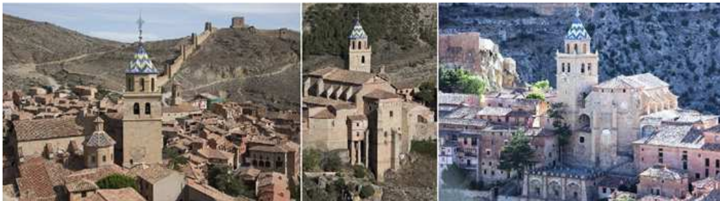
❶ Panorámica de Albarracín con la torre de El Salvador. ❷ Es un templo que se adaptado a la orografía del terreno. ❸ En su cabecera poligonal como en el exterior del templo se aprecian potentes contrafuertes. Fotos: Gobierno de Aragón; Blasco, Javier.
