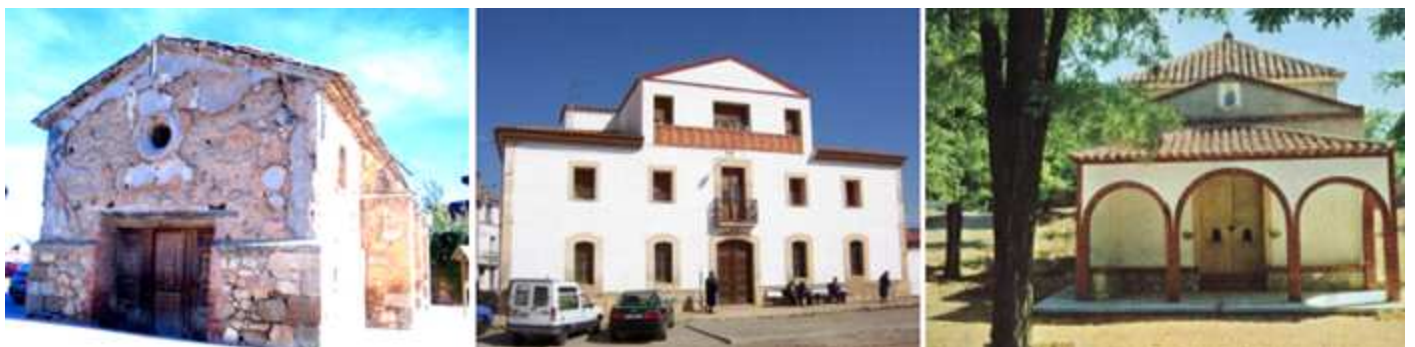
❶ Iglesia de San Juan. Templo de nave única y cabecera recta construido con tapial y mampostería con cubierta a dos aguas y contrafuertes en sus laterales. Posee en un lateral una puerta de medio punto actualmente cegada. ❷ Hospital de San José. Es un edificio de tres planta que se inauguró en el año 1886. Actualmente es Residencia de la 3ª Edad. ❸ Ermita de la Virgen del Carmen. Templo de una sola nave con pórtico de tres arcos construida en el S. XVII y que tuvo una ampliación en el año 1967. Fotos folleto Oficina de Turismo.
