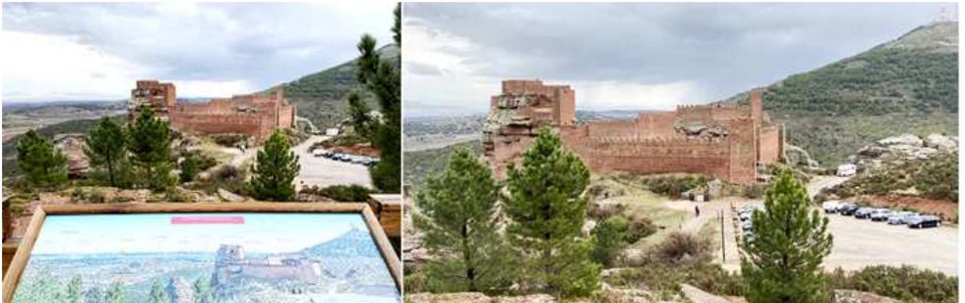
❶ El castillo al fondo desde este mirador elevado. ❷ Está construido con piedra sillar caliza y algunas zonas excavadas en las propias rocas donde se asienta.
