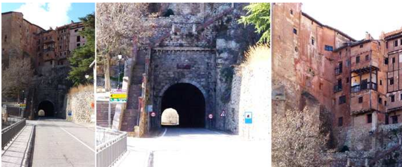
1 la carretera junto al río y al fondo el túnel. 2 Boca de este túnel carretero de 150m de longitud, excavado en la roca, para esta carretera A-1512. 3 Las casas a la derecha del túnel.
