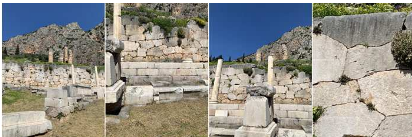
1 La vía Sacra continua dejando a la izquierda el Stoa de los Atenenses a la izquierda. 2 El Stoa llegaba hasta la columna de Naxos (a la izquierda). 3 ¿?. 4 Este muro que soporta la terraza del Templo de Apolo está construido con bloques irregulares y sus piedras se acoplan perfectamente sin apenas resquicios.
