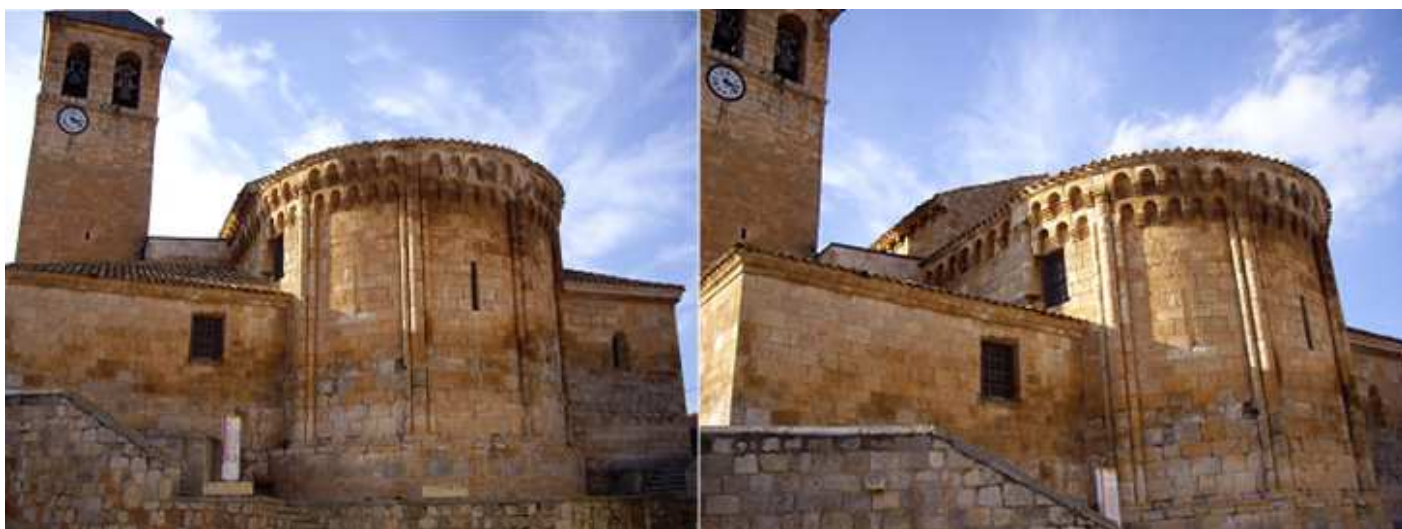
❶ El campanario y el ábside de la iglesia de San Miguel Arcángel de Caltojar. ❷ Los contrafuertes formados con tres semicolumnas. Y las construcciones más modernas no dejan visibles a los ábsides laterales.
