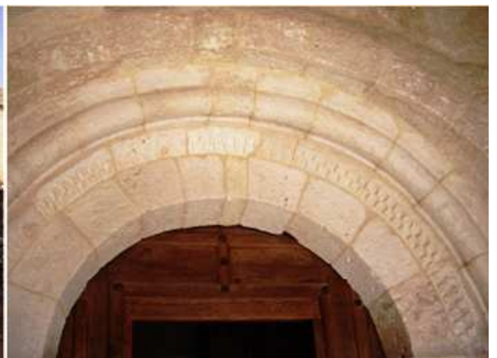
2 Su puerta con arco de medio punto con tres arquivoltas.
