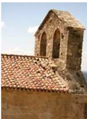
❸ Su hastial con un espadaña de dos vanos. ❹ Su construcción de mampostería con sillares en sus ángulos. ❺ Exterior del lado del Evangelio. Fotos: Junta de Comunidades de Castilla y León aportadas por el Ayuntamiento.
