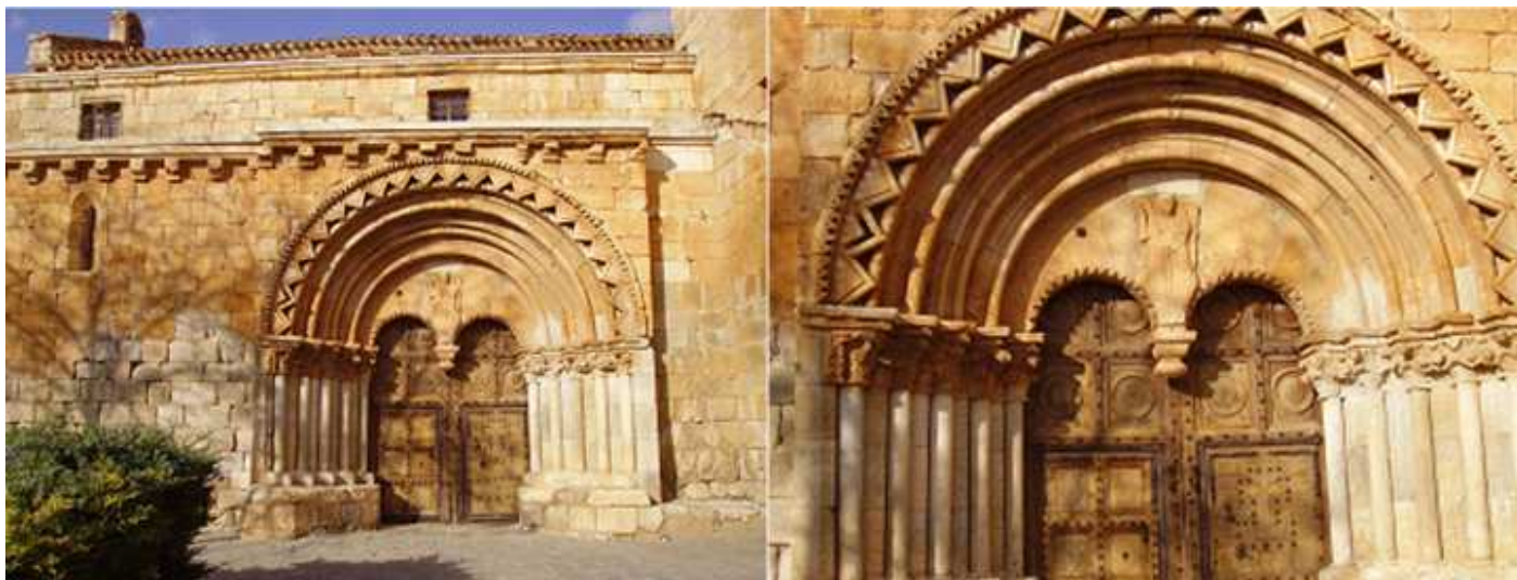
❶ Su portada meridional ligeramente adelantada y cubierta con un tejazoz con 10 canecillos. ❷ Posee esta puerta con dos vanos geminados en su tímpano. Y con sus cinco arquivoltas en degradación.
