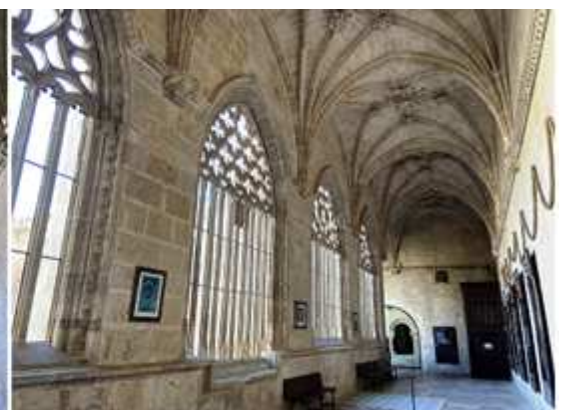
1 Un capitel central que alberga esta cara humana. Del vano derecho. 2 Las bóvedas de crucería de una de sus pandas. 3 Abiertas con amplias ventanas con arcos apuntados con tracería. Panda del lado sur.
