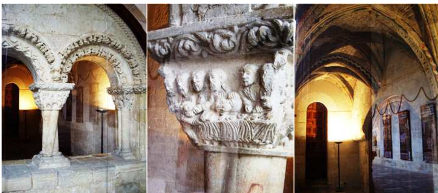
❶ Ventanas de la parte derecha de las sala Capitular con una columna torsa. ❷ Esta columna en uno de los lados de su capitel se encuentra la Santa Cena. ❸ Lateral derecho de la sala, esta está dotada con bóveda de crucería.
