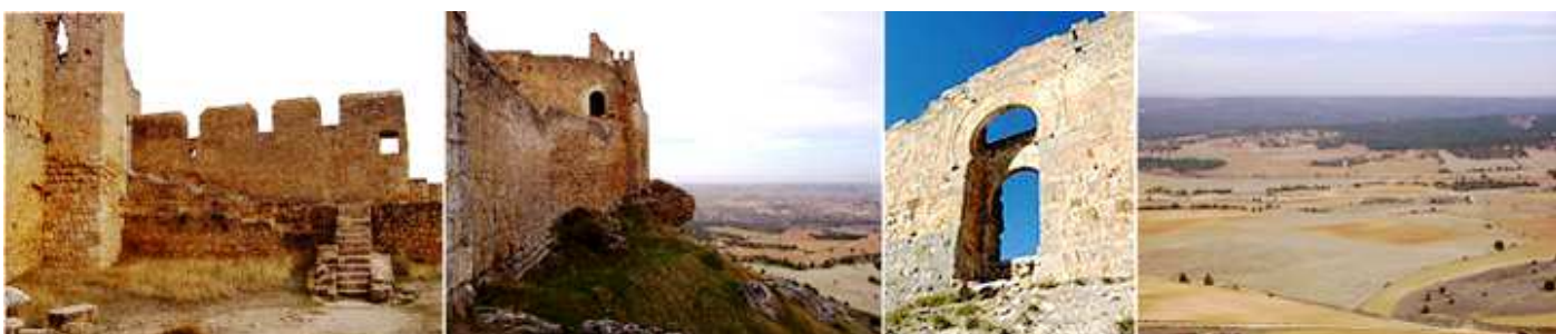
1 - 2 Diferentes partes del exterior del castillo. 3 Puerta califal. 4 Desde el mismo la visión es amplia en todos los sentidos.
