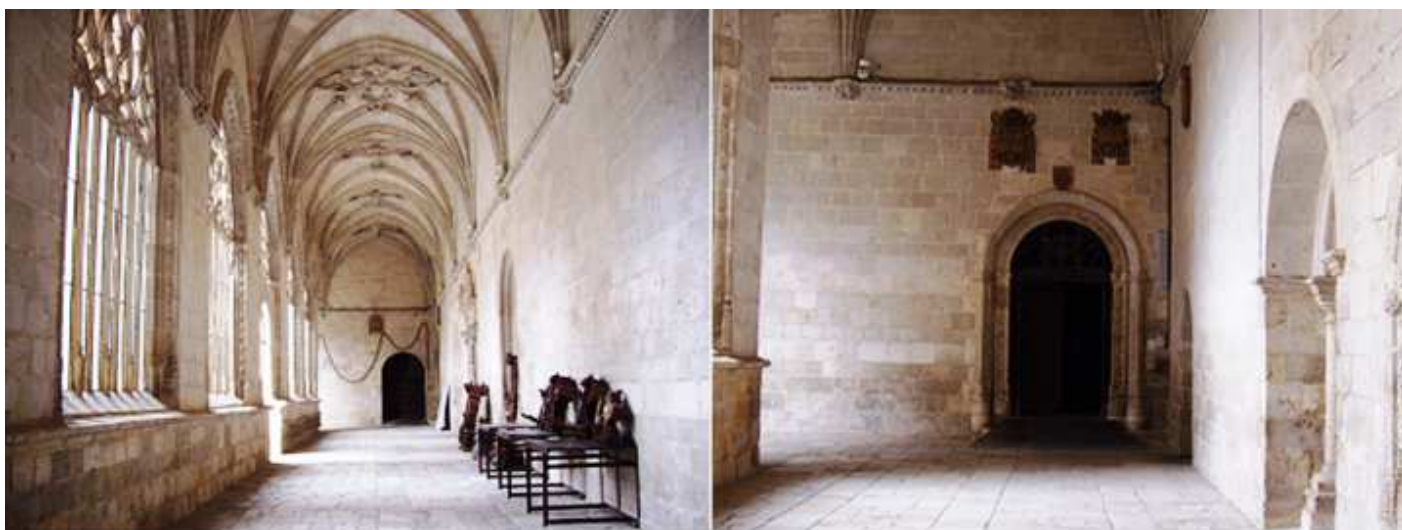
❶ Ala del claustro con algunas piezas de la exposición. Está cubierto con bóvedas de crucería nervadas y los nervios descansan sobre ménsulas historiadas. ❷ Es de planta cuadrada y adosado a la iglesia, y está cubierto con bóvedas de crucería nervadas, los nervios descansan sobre ménsulas historiadas.
