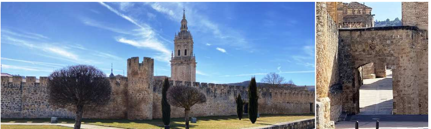
❶ Actualmente se pueden contemplar dos tramos bien conservados: la zona del Arco del Cubo (calle Poeta Malo de Molina) y especialmente el paseo que hay paralelo a la carretera de la Rasa. ❷ Esta es la puerta de San Miguel, la única que queda en el cerco de sus murallas. Y por donde comenzamos el recorrido.
