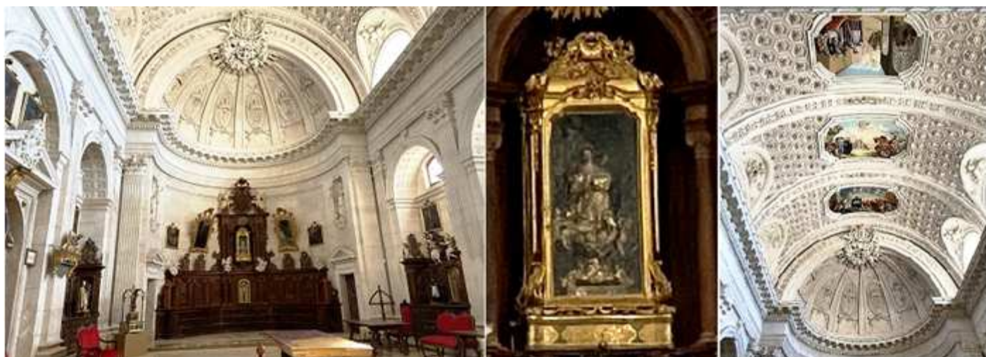
1 La sacristía Nueva. Cubierta con una bóveda de cañón y de horno 2 Sobre la cajonería de la cabecera se encuentra en esta hornacina la talla barroca de la Inmaculada. 3 En sus bóvedas realizadas en yeso se encuentran unos frescos que son alusivos a San Pedro de Osma, Santo Domingo de Guzmán y el Venerable Palafox.
