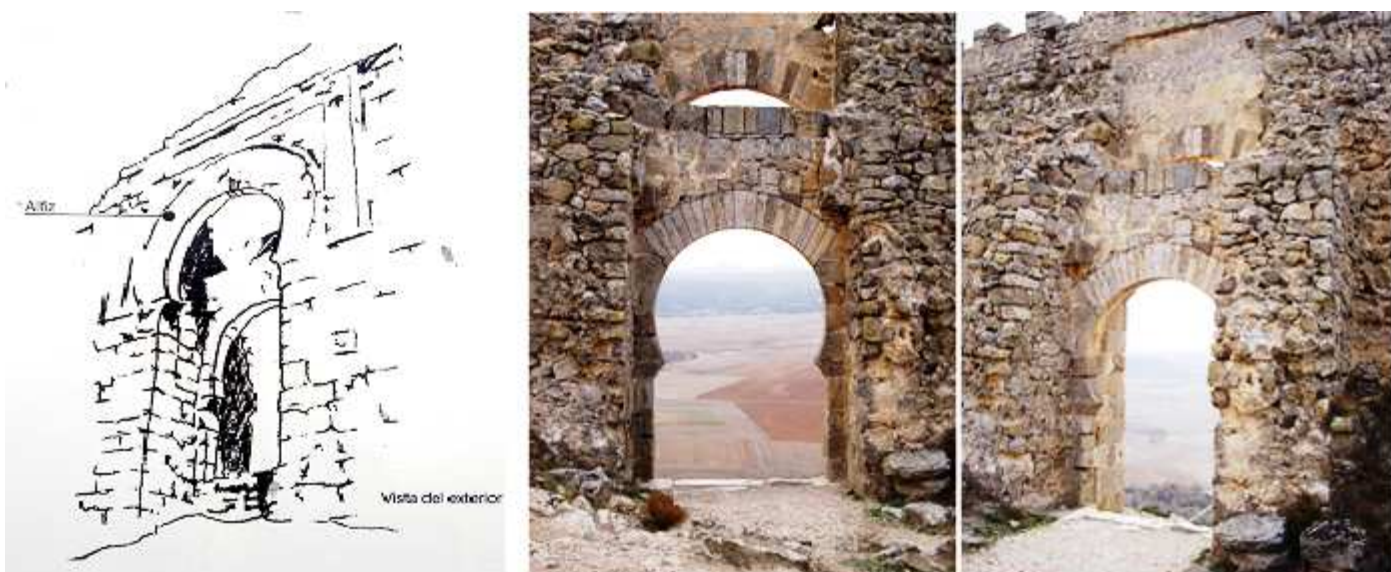
❶ Puerta Califal por su exterior. ❷ La misma puerta por su interior, en realidad tiene dos arcos y entre ellos se encuentra la buhedera, se trata de un espacio entre las dos puertas que permite el lanzamiento de proyectiles desde arriba. ❸ Otra de las puertas de acceso.
