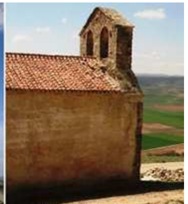
❸ Su hastial con un espadaña de dos vanos. ❹ Su construcción de mampostería con sillares en sus ángulos. ❺ Exterior del lado del Evangelio. Fotos: Junta de Comunidades de Castilla y León aportadas por el Ayuntamiento.
