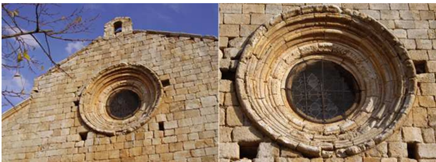
1 Rosetón de la fachada principal.
