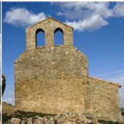
❸ Su hastial con un espadaña de dos vanos. ❹ Su construcción de mampostería con sillares en sus ángulos. ❺ Exterior del lado del Evangelio. Fotos: Junta de Comunidades de Castilla y León aportadas por el Ayuntamiento.
