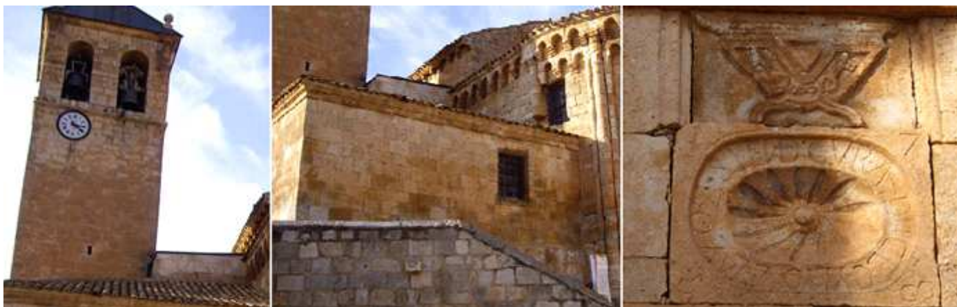
❶ Torre lateral este de San Miguel. ❷ El exterior de la sacristía construido en el S. XVII por lo que se suprimió el ábside epistolar y se adoso al central. ❸ Espacio adosado a la torre y a la cabecera. ❹ Detalle esculpido en su fachada fechado en 1758.
