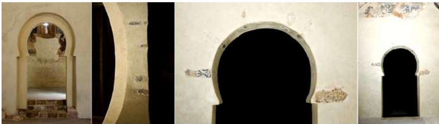
❶ Esta puerta posee dos arcos de herradura. Y unos escalones que acceden al ábside. ❷ Arco del presbiterio. ❸ La parte posterior del arco de herradura. ❹ El arco visto dentro de ábside (desde detrás del altar). En la parte superior la Creación de Adán y Eva. Fotos: Junta de Comunidades de Castilla y León aportadas por el Ayuntamiento.
