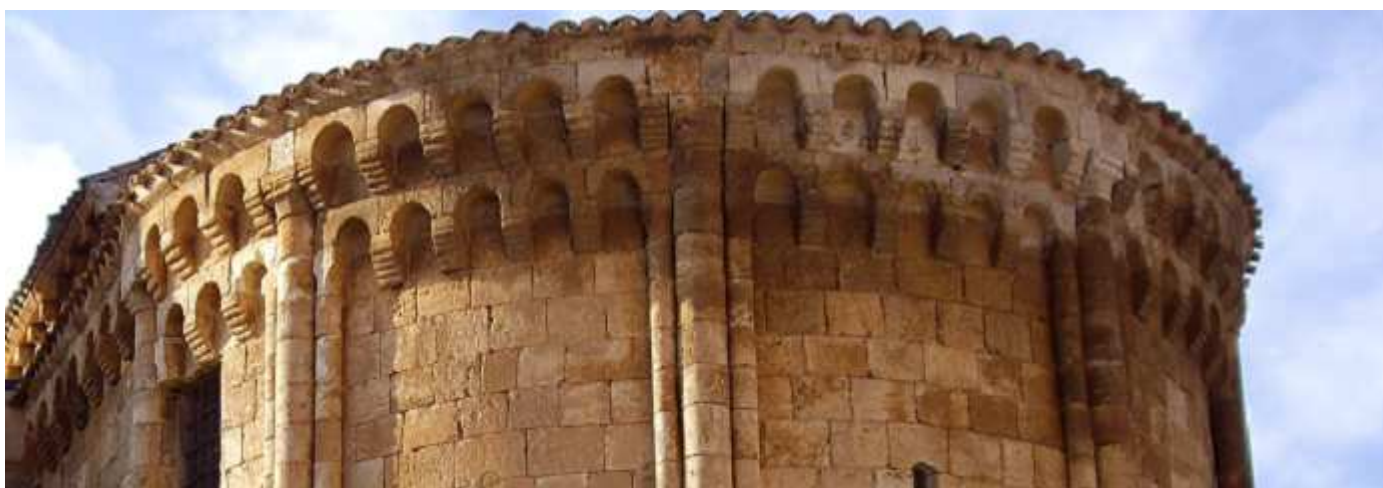
❶ En esta imagen se puede apreciar las dos líneas de arquillos de su ábside bajo su alero y dividido en cinco paños separados por grupos de tres columnas redondas adosadas.
