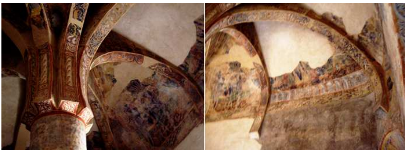
❶ Lado derecho visto desde el ábside.
