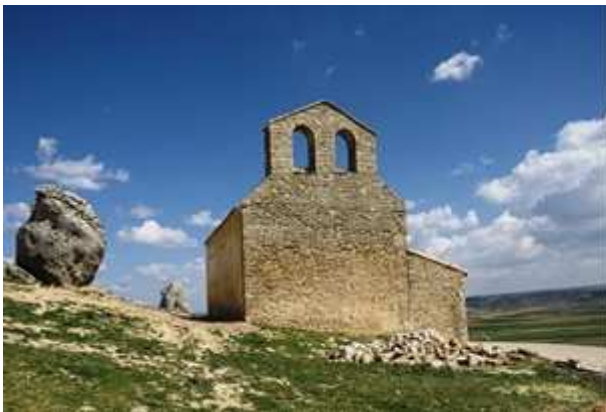
❸ Su hastial con un espadaña de dos vanos. ❹ Su construcción de mampostería con sillares en sus ángulos. ❺ Exterior del lado del Evangelio. Fotos: Junta de Comunidades de Castilla y León aportadas por el Ayuntamiento.
