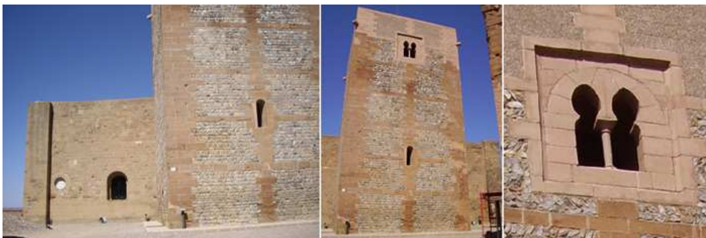
❶ La Sala Capitular al fondo y la parte baja de la torre del homenaje de frente. ❷ Lateral de la Torre del Homenaje su construcción data de los S. IX-X. ❸ Ventana dotada con dos arcos estrechos de herradura con una columnilla.
