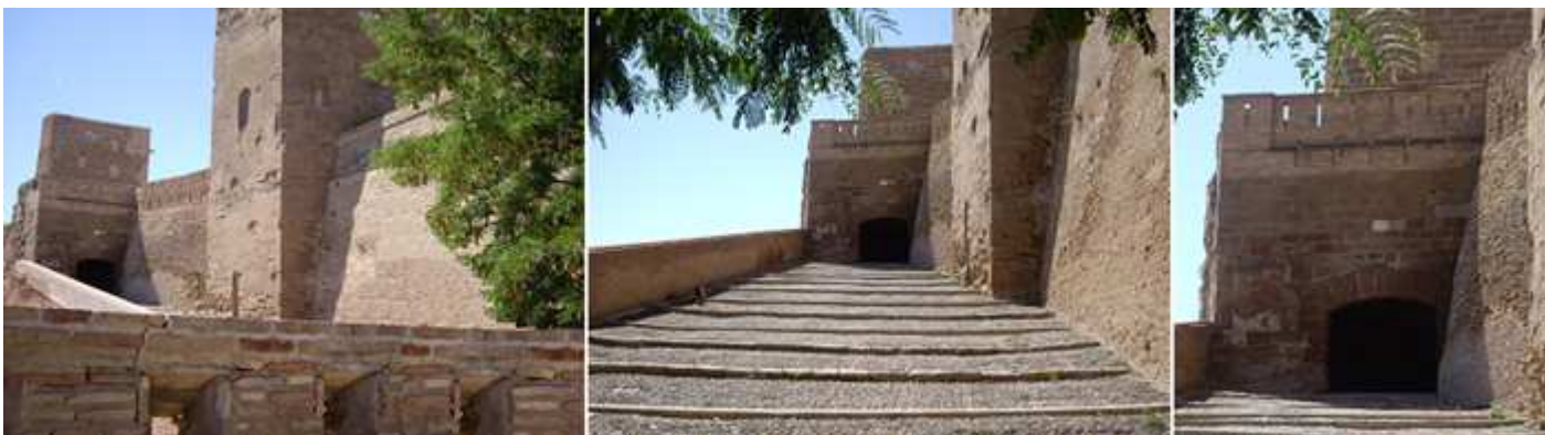
❶ Recodo antes de llegar a la segunda puerta. ❷ Y el último tramo del empedrado para entrar en la fortaleza. ❸ Con una puerta de arco rebajado.
