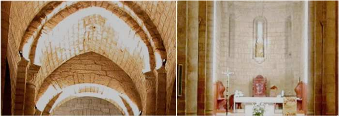
1 Detalle de los arcos torales apuntados que descansan sobre columnas adosadas. 2 Ábside semicircular con ventanas.
