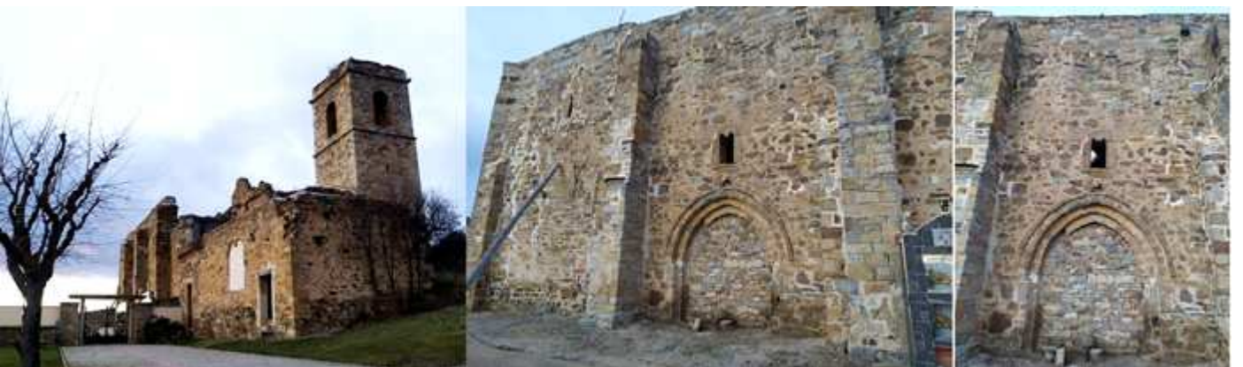
❶ Cabecera con las construcciones anexas y la torre. ❷ Lateral del muro de la Epístola con su puerta cegada en el segundo tramo de la nave. ❸ Y su puerta de arco apuntado con tres arquivoltas con un fino baquetonado en su arista interior, que descansaría en una imposta corrida inexistente, y cubierta con un guardapolvo con puntas de diamante. Sobre la puerta una sencilla ventana bífora a la que le falta su mainel o columnilla central. Fotos: Carlos Escribano Barrio.
