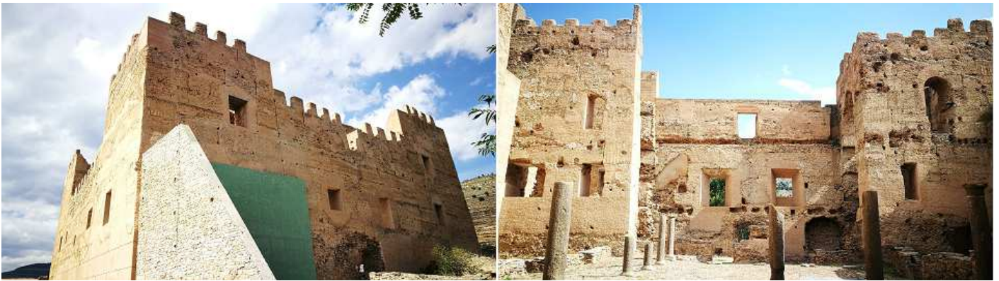
❶ Conserva todo su perímetro y algunas partes almenadas, y se aprecia la construcción con tapial. ❷ En su interior conserva algunas columnas de su patio porticado. Fotos: Carlos Escribano Barrio.
