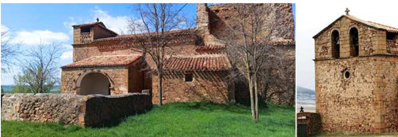
1 Panorámica del lateral sur del templo, con una cerca de piedra ante su pórtico, su puerta cobijada por un pórtico abierto y en el lado epistolar junto a la cabecera su sacristía adosada. 2 Hastial con un pequeño óculo y coronado con una espadaña de dos vanos. Fotos Parroquia.
