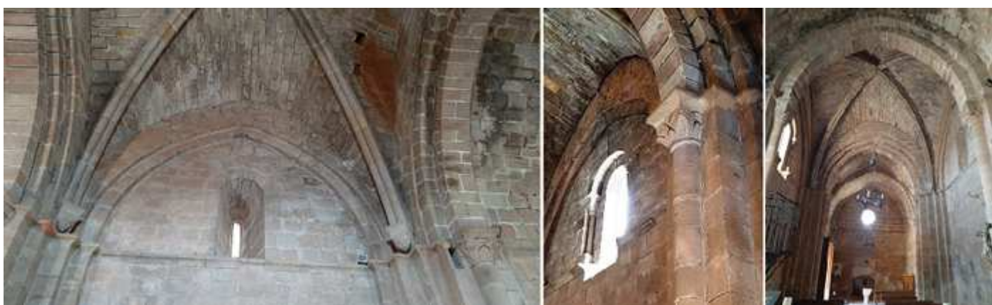
❶ Lateral de la nave en el crucero con una ventana con gran derrame interior y una imposta corrida a la altura de los capiteles. ❷ Otra de las ventanas laterales con columnillas y capiteles con hojas de palma, lo mismo que el capitel de la columna adosada que sostiene un arco fajón. ❸ Vista de la parte inferior del templo desde la cabecera Fotos: Ayuntamiento.
