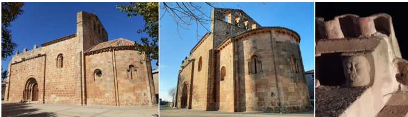
❶ Fachada al mediodía con el cuerpo de su portada que sobresale y que cuenta con un tejazoz con 18 canecillos lisos, y posee varias almenas. ❷ Este lateral de la Epístola abierto con una ventana con derrame exterior dentro de un arco con capiteles con motivos vegetales y columnas en el tramo del presbiterio. ❸ Canecillo con una cara humana barbuda situado en alero del presbiterio al final con el ábside. Fotos: Ayuntamiento.
