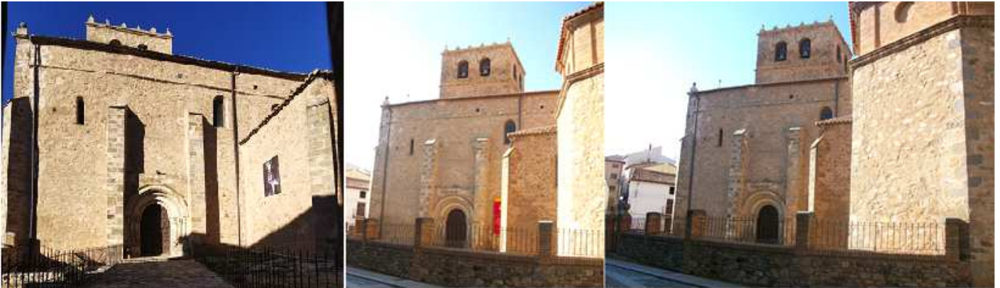
❶ La portada se encuentra entre dos contrafuertes. Foto Débora Soriano. ❷ Su torre de planta cuadrada se encuentra adosada en el lateral del Evangelio. ❸ A la derecha se encuentra la sacristía y la pila bautismal dado que este espacio fue el baptisterio.
