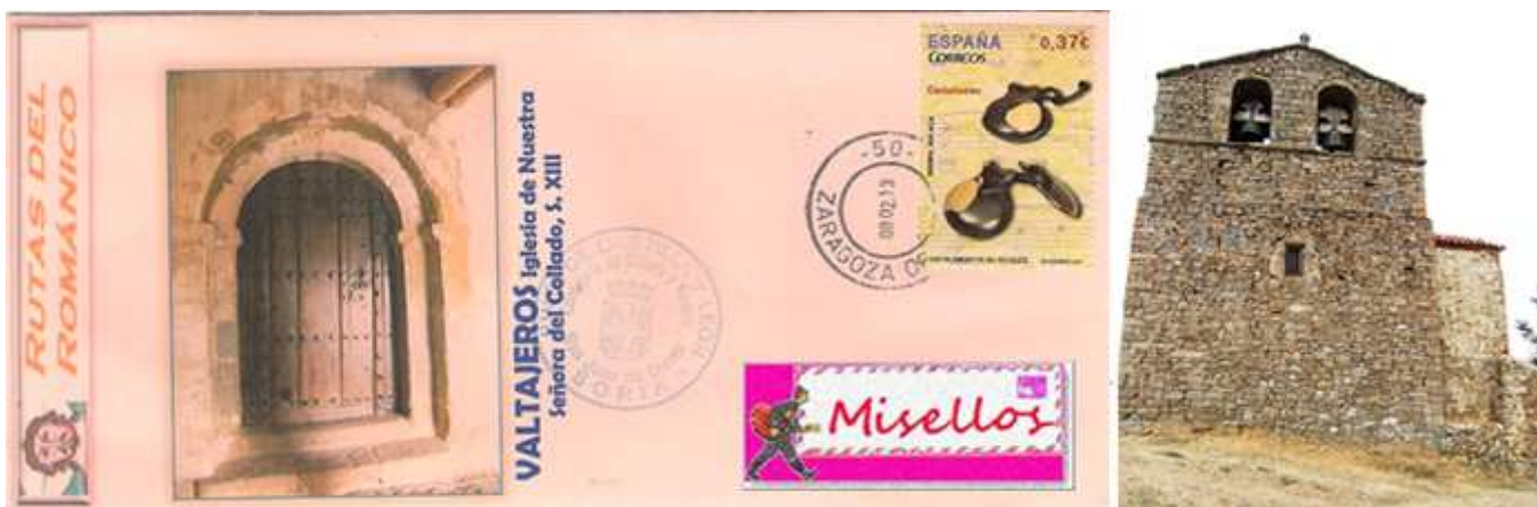
❶ Su sencilla puerta de medio punto. ❷ Hastial con una pequeña ventana adintelada sobre el mismo una espadaña con dos amplios vanos para sus campana y una imposta corrida bajo las mismas.
