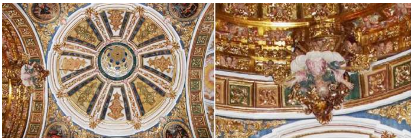
❶ Bóveda de ocho gajos con linterna y sobre pechinas en la capilla del Santo Cristo. Con yeserías doradas en sus arcos y bóvedas. ❷ Angelito de bulto en el intradós del arco. Fotos Oficina Turismo. Posee tres capiteles románicos, reutilizados como soporte del altar ¿ altar Mayor?. En ellos podemos ver: motivos vegetales, cuatro parejas de híbridos afrontados de cuerpo de ave y cabeza de felino. Y el tercero es la copa de la pila aguabenditera, está decorado con cuatro parejas de toscas aves que vuelven sus picos formando corazones. Y su Pila bautismal.
