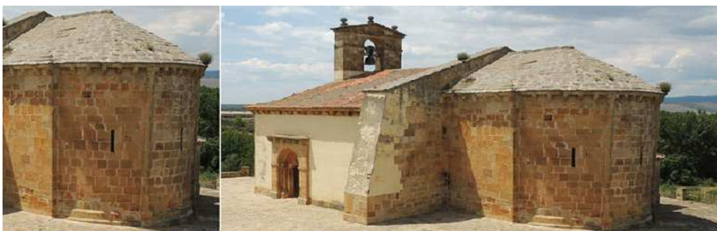
① Su ábside con tres paños separados por columnas redondas adosadas, y un amplio presbiterio. ② En su lado epistolar se encuentra su portada adelantada en este tramo ampliado y junto a un potente contrafuerte, sobre el hastial se eleva su espadaña de un solo vano. Foto: Wikipedia. © De Borjaanimal - Trabajo propio, CC BY-SA 4.0,
