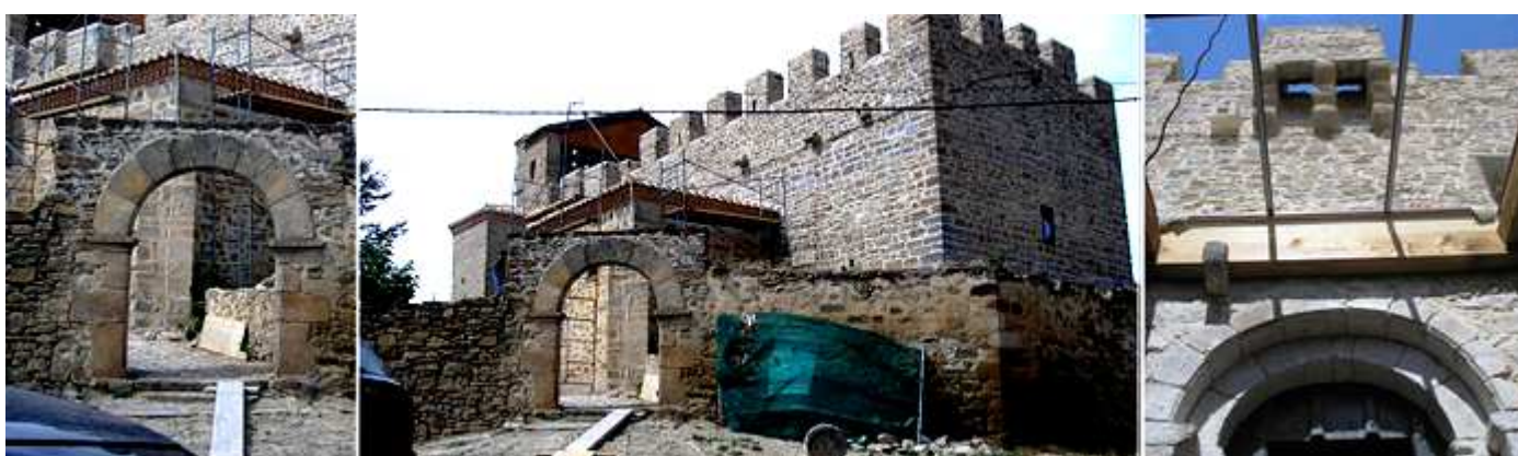
❶ La iglesia posee un muro perimetral con esta puerta de dovelas lisas con un bisel interior lo mismo sobre las impostas y jambas debió de ser construida en el S. XVI. ❷ Aspecto en los momentos de su reforma. ❸ Y el matacán que posee sobre su puerta de entrada. Fotos: Orlando Yagüe de Miguel.
