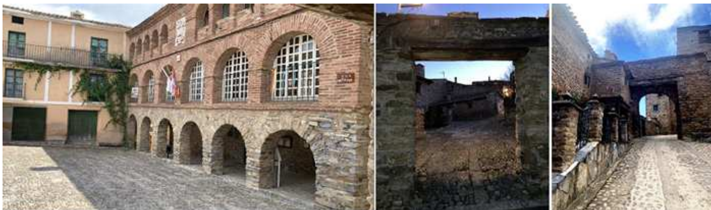
1 Edificio del Ayuntamiento construido en piedra y ladrillo de tres planta la inferior abierta con seis arcos, la superior igualmente con seis arcadas y la superior con arquillos de medio punto con cinco a cada lado del escudo de la fachada. 2 La Puerta de la Villa. 3 La puerta del Río sobre los restos de la muralla medieval, y acceso a la Villa. Fotos Oficina Turismo.
