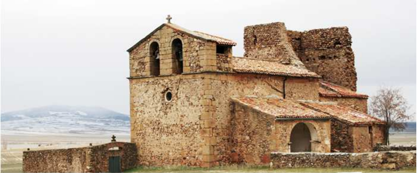
❶ Iglesia de Nuestra Señora La Blanca, con el cementerio a la izquierda, su puerta alojada dentro de un atrio en el primer tramo del templo y a continuación al atrio tiene adosada su sacristía. Y en este lado sur se encuentra rodeada con una cerca. En la cabecera esta la torre que además de parte de sus laterales, no está con cubierta. Foto: Wikipedia. © De Miguel Ángel Gracia - originally posted to Flickr as Montenegro-de-Ágreda., CC BY 2.0, https://commons.wikimedia.org/w/index.php?curid=9578791
