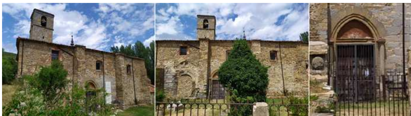
1 Lateral epistolar con dos potentes contrafuertes. 2 En este lateral se encuentra su puerta y a su izquierda otra de medio punto cegada. 3 Puerta de arco apuntado con tímpano liso y sendas columnas a sus lados. Fotos: Carlos Escribano Barrio.
