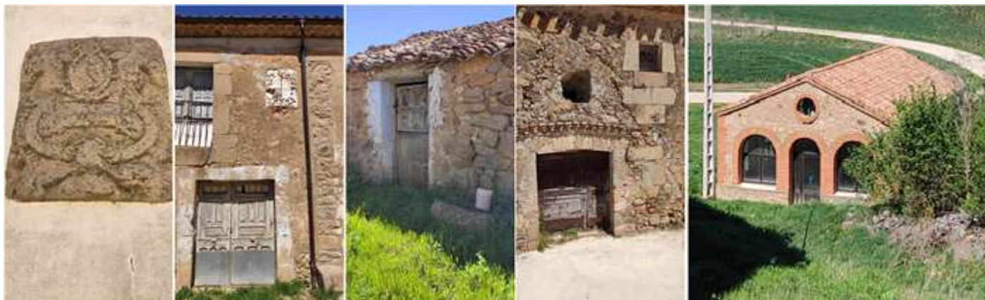
1 Algunos escudos reutilizados en viviendas. 2 Restos de otro sobre esta fachada. 3 Construcción antigua. 4 Casa con una puerta de arco rebajado. 5 El lavadero de 1958. Fotos: Sara Vera Asensio.
