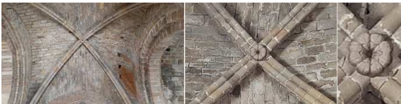
❶ Bóveda del crucero proto-gótica sobre ménsulas figuradas con cabezas. ❷ Detalle de los nervios de esta bóveda. ❸ Clave con una flor de ocho pétalos, llamada dríada. En el cristianismo el ocho se asocia a la resurrección. Fotos: Ayuntamiento.
