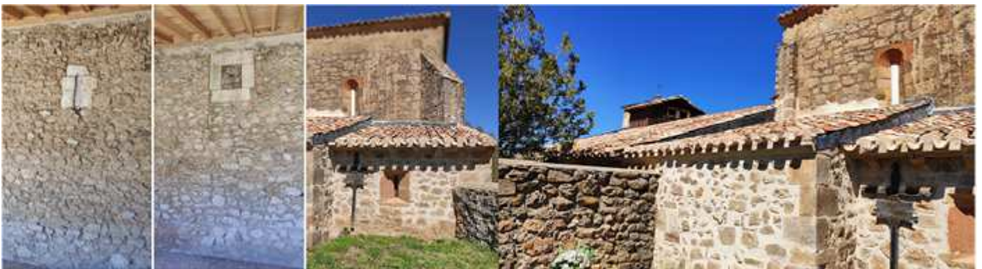
❹ Ventana de aspillera en el muro de la nave. ❺ Otra adintelada. ❻ Parte de su cabecera en el lado epistolar con la sacristía adosada. ❼ El templo en este lado desde el Campo Santo. Fotos: Sara Vera Asensio.
