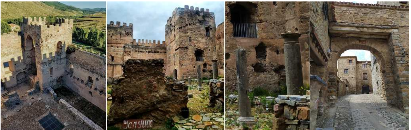
❶ La parte interior del castillo desde una de sus torres. ❷ m. ❸ Detalle de las columnas que tenía su patio porticado. ❹ Puerta del Río y parte de la Muralla. Fotos: Carlos Escribano Barrio.
