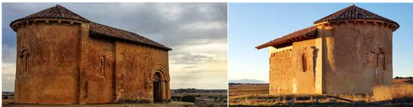
❶ La cabecera algo más alta que el presbiterio y la nave. ❷ Y posee un contrafuerte a cada lado. Fotos: M a . Sandra Martínez.
