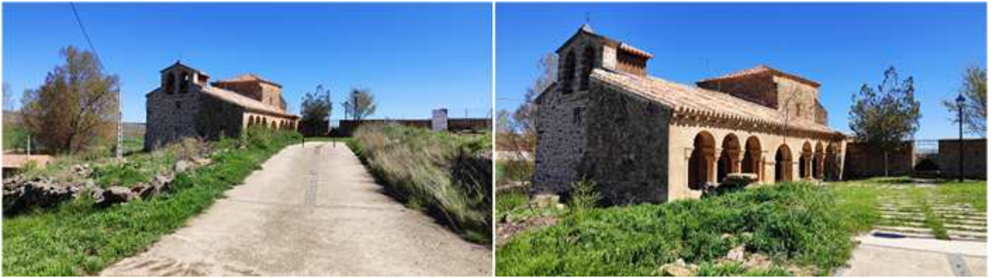
1 En el mismo camino que lleva al cementerio. 2 Templo en plena restauración con la Galería porticada ya culminada. Fotos: Sara Vera Asensio.
