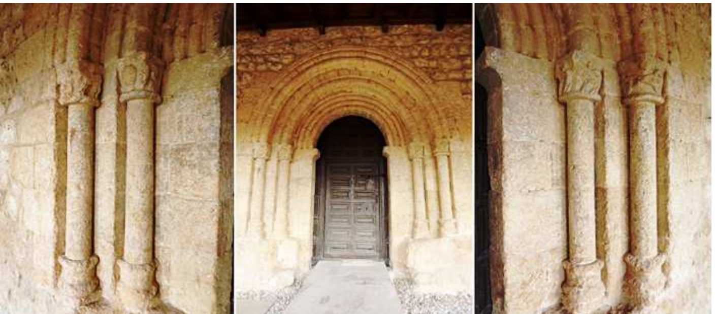
❶ Capiteles portada lado izquierdo, con unas caras y piña el interior y dos caballos ¿? el exterior. ❷ Portada con tres arquivoltas acanaladas de diferentes grosores descansando sobre columnas y la interior sobre jambas. ❸ Las columnas descansan sobre un podio, y los capiteles de la parte derecha decorados con animales el interior y entre lazos el otro.
