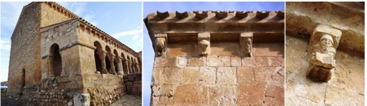
❷ Perspectiva del porche con un vano al oeste. ❸ Todo su alero esta sostenido por canecillos decorados algunos de buena factura y expresión. ❹ Canecillo con un monje con el libro abierto, donde indica "Era MCXVIII (1081) y también Julianus Magister Fecit" el maestro constructor.
