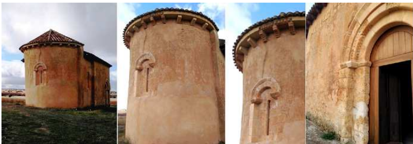
❶ Con su cabecera semicircular y algo más alta que la nave. ❷ Realizada en mampostería revestida, con una ventana de aspillera en el centro. ❸ Ventana que ha sido expoliada de sus capiteles y columnillas. Conserva en su alero, algún tramo decorado y algunos canecillos originales como estos de rollos y con bolas. ❹ En su portada que ha tenido que ser reconstruida conserva rosetas y adornos en los restos de sus arquivoltas. Ermita también llamada de las Nieves. Fotos: Ayuntamiento.
