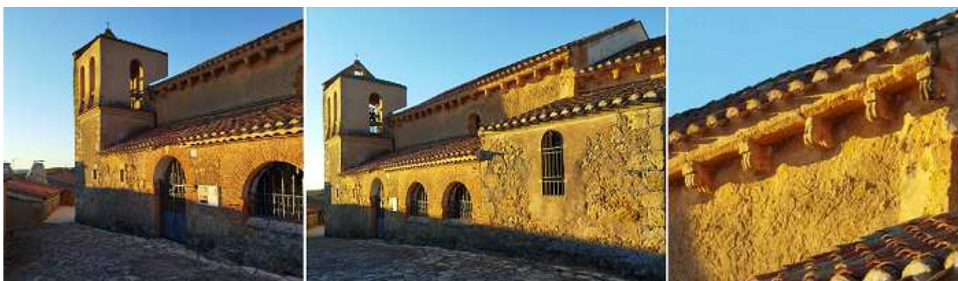
❷ Frontal del lado sur con en el acceso y con dos ventanas adinteladas a su izquierda. ❸ La galería posee dos ventanas de medio punto realizadas con ladrillo. El muro de la nave dispone de una ventana de medio punto que está decorada sus dovelas con taqueado jaqués y con bolas, el ajedrezado se repite en sus impostas. ❹ En el alero de la nave sobre la galería porticada dispone de canecillos con volutas, cabezas de animales y figuras humanas. Fotos Sergio Fernández Barranco.
