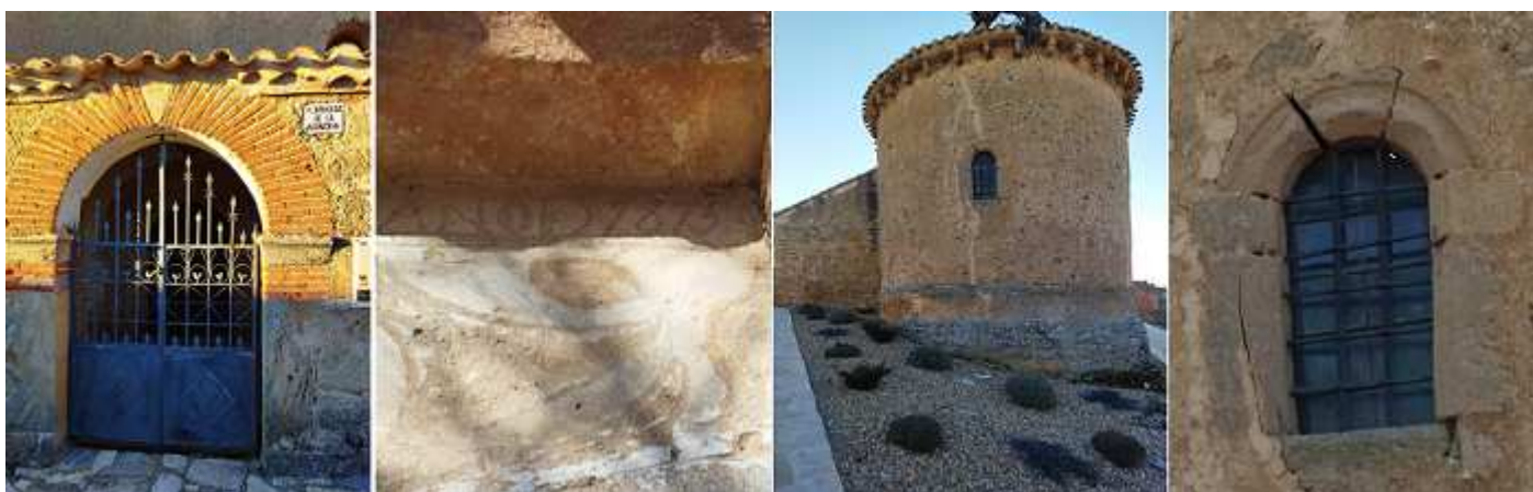
❶ La puerta de la galería de ladrillo salvo la clave y las impostas biseladas en piedra. ❷ En la parte izquierda de la misma bajo su alero dispone de una inscripción (año 1875) de la reforma o arreglo de esta galería. ❸ Su ábside semicircular, abierto con una ventana algo ladeada y su alero con canecillos. Y otra adintelada junto al presbiterio. Su ábside exteriormente liso de su construcción de mampostería. ❹ Ventana del ábside con un leve acanalamiento. Fotos Sergio Fernández Barranco.
