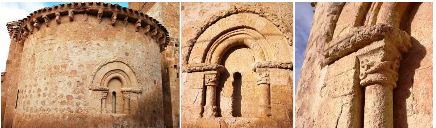
❶ Ábside abierto con una ventana. ❷ Ventana con un guardapolvo decorado con dos arquivoltas la exterior recta y lisa y la interior baquetonada y acanalada que descansan sobre una imposta, su interior está abierta por una aspillera. ❸ Detalle del capitel decorado con lazos, sobre columna redonda.
