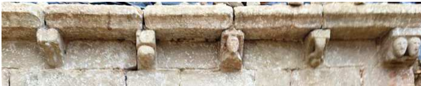
❶ Alero de su puerta para acceder al templo de medio punto en la galería con canecillos con figuras humanas la mayoría. Foto: Carlos Vera Lallana.
