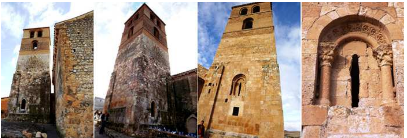
❶ Parte de la torre de planta cuadrada y con tres cuerpos el primero de piedra y los dos superiores de ladrillo recrecida para el campanario. Su escalera se encuentra embutida en sus gruesos muros. ❷ La torre por la parte exterior del lado del Evangelio, de época posterior. En la parte inferior dispone de una pequeña puerta de acceso. ❸ Cara de la torre junto al ábside. Una de las estelas funerarias que posee el templo re-aprovechadas está en la parte occidental de la torre. ❹ Detalles de la ventana inferior con arquivolta decorada con motivo vegetal y dos capiteles con aves sobre columnas redondas.
