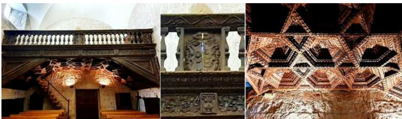
❶ Coro de estilo mudéjar de 1558 tallado en madera de pino. ❷ Escudo del obispo Acosta que lo mandó realizar, situado en la parte central del frontis de su balastrada. Siendo tutor de este templo. ❸ Detalle de los hexágonos y de la decoración de este artesonado. Fotos Oficina Turismo.
