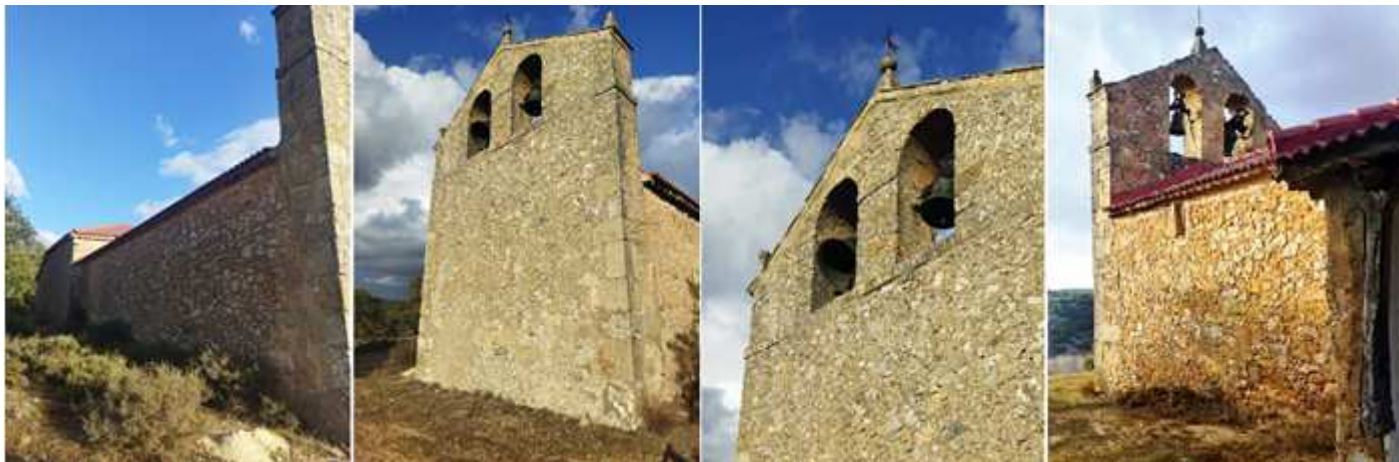
❶ Exterior del lado del Evangelio. ❷ En su hastial se alza una espadaña con dos vanos para las campanas de fabricación moderna se llaman Santa Bárbara y San Pedro, de 1895 y 1948 respectivamente. ❸ Con un remate triangular y con pináculos. ❹ El tramo meridional hasta el pórtico abierto de su entrada. Fotos: Sergio Fernández Barranco.
