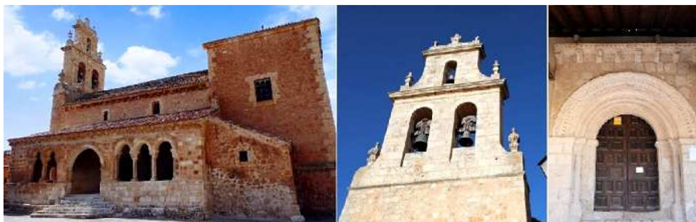
① Fachada sur del templo, cuya galería porticada hasta hace poco tiempo estuvo cegada y utilizada para usos agrícolas. En ella se puede apreciar el ensanchamiento de su arco central a costa de suprimir a la izquierda uno de los ventanales. ② Sobre el hastial dispone de esta espadaña de dos piso con tres vanos para sus campanas y decorada con pináculos. ③ Su puerta de medio punto. Fotos: Camping Río Lobos.
