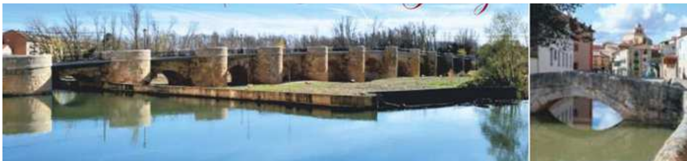
1 El puente grande visto desde la Avda. de Valladolid, que cuenta con dieciséis ojos. 2 El puente pequeño que cruza el canal para la harinera.
