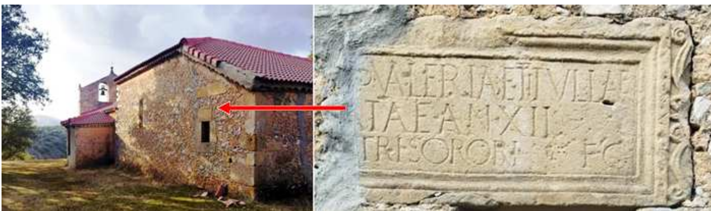
❶ En su parte posterior se encuentra la sacristía de la ermita y en esta ventana, se encuentra encastrada como dintel la estela funeraria romana. Se encontró al construir en 1772 la sacristía. ❷ En la misma se encuentra el epitafio dedicado a Valeria Titulla y su hija pequeña, encargada por otra hija. Con el texto ...S VALERIAE TITVLLAE/...ATAE AN XII / ...TRESORORI FC. Fotos: Sergio Fernández Barranco.
