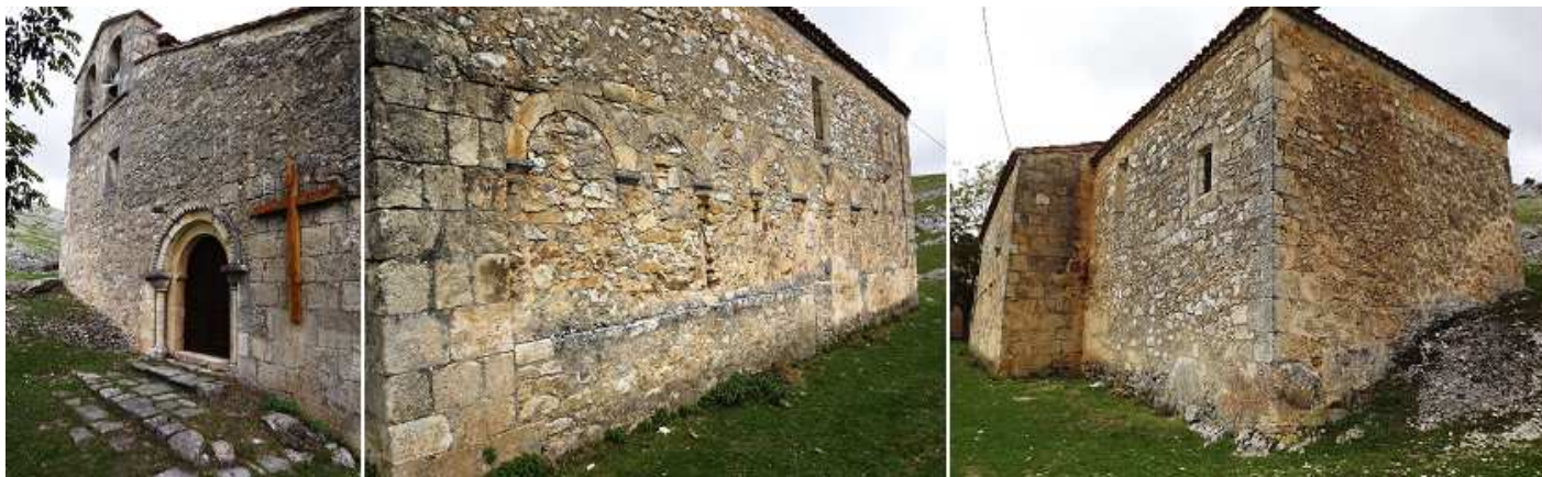
❶ Esta fachada está más elevada que la cubierta de la nave. ❷ Otra imagen de la galería cegada. ❸ Y la parte de su cabecera que es la sacristía.
