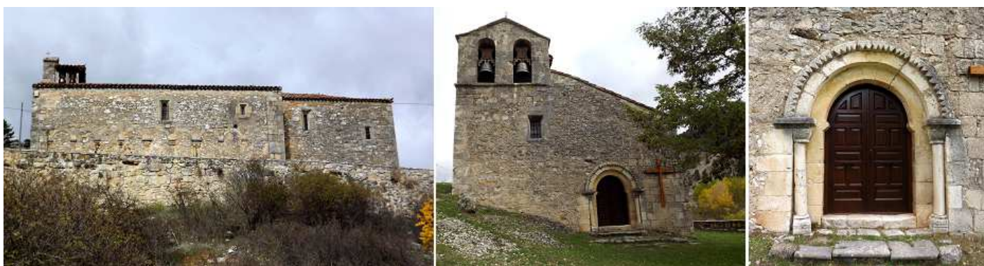
❶ Lateral del templo contemplado desde la carretera. ❷ Hastial de la iglesia con una espadaña de dos vanos y su puerta ladeada a la derecha. ❸ Portada con un arco de medio punto con una arquivolta lisa y un guardapolvo decorado con puntas de diamante.
