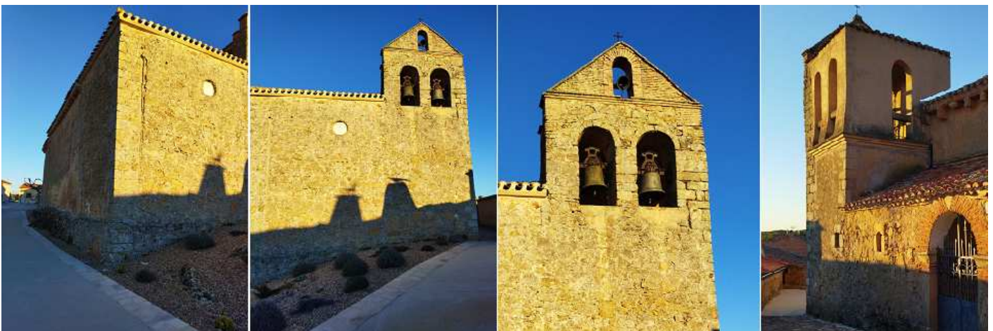
1 Lateral exterior del Evangelio. 2 Fachada a los pies dispone de un pequeño óculo. 3 Y a la derecha una espadaña con dos grandes vano y uno más pequeño. 4 Los vanos de la parte sur y este mucho más amplios y esta parte del campanario sobre el cuerpo anterior separado por una imposta. Fotos Sergio Fernández Barranco.
