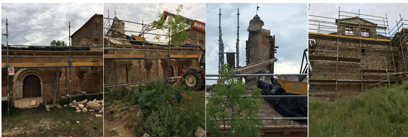
❷ Detalle de la parte central de la galería. ❸ Con la restauración de la cubierta del templo. ❹ La espadaña. ❺ Hastial del templo con su espadaña de dos vanos. Esta iglesia dentro de la tipología del románico rural se reconstruyó a mediados del S. XVI y en los siglos siguientes XVII y XVIII se reforzó con contrafuertes en el muro norte, se compone de una sola nave con su cabecera recta con bóveda de crucería, sobre su hastial se eleva su espadaña de dos vanos (de 1893) y que en el año 2021 ha sido restaurada. Fotos: Carlos Vera Lallana.
