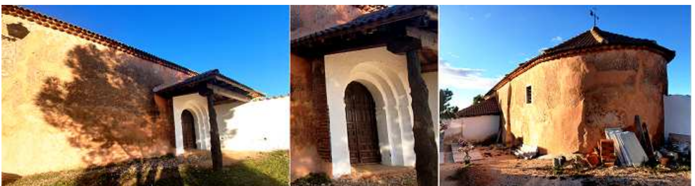
❶ Su portada con tres arquivoltas sobre impostas naceladas y jambas realizadas en ladrillo ubicada en el lateral epistolar y cubierta con un porche. Es una construcción de mampostería. ❷ Su puerta realizada en ladrillo con tres arquivoltas planas sobre jambas. ❸ La cabecera semicircular se encuentra dentro del cementerio. Fotos: M a . Sandra Martínez.
