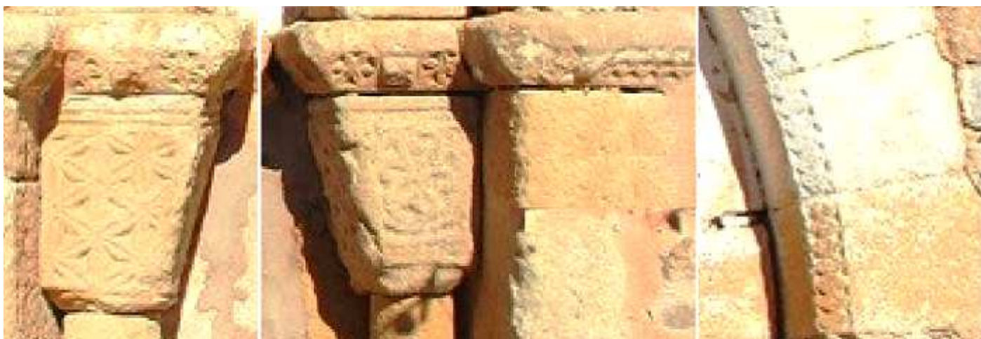
❶ El capitel izquierdo tronco piramidal con un tramado de flores hexapétalas, igual que los cimacios en su frontal y en el lateral con tres flores. ❷ El capitel derecho se repite con una flor de mayor tamaño. ❸ Detalle de la simple decoración en el bisel interior de la tercera arquivolta. Fotos: Ayuntamiento.
