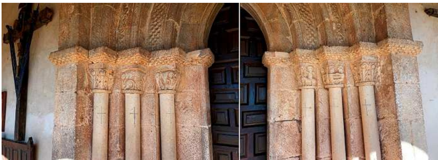
❶ El grupo de capiteles del lado Izquierdo. ❷ Y los del lado derecho, la imposta taqueada continua por el frontal de los contrafuertes. Las columnas apean sobre basas decoradas con bolas. Fotos: Valentín Blanco.
