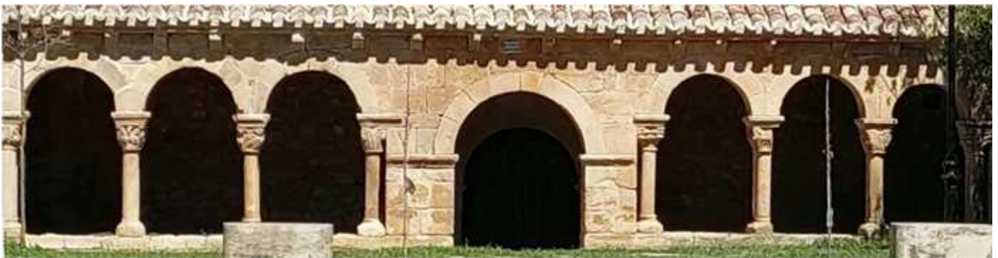
1 Compuesta por seis arcos con capiteles decorados sobre dobles columnas más el arco de de acceso algo más ancho que los anteriores sin decoración, con impostas y jambas rectas. El alero de la Galería posee unos sencillos sin decoración. Foto: Sara Vera Asensio.
