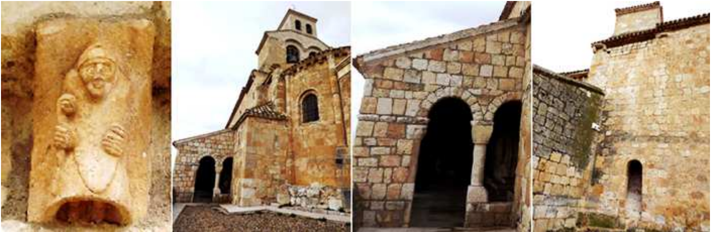
❶ Canecillo báculo, ❷ Detalle del ábside del que solo queda esta ventana al exterior en la parte central se adoso el camarín de la Virgen. ❸ Los dos arcos de la galería en la parte este. ❹ Lateral del muro del Evangelio y una puerta de acceso a la izquierda la sacristía construcción posterior adosada.
