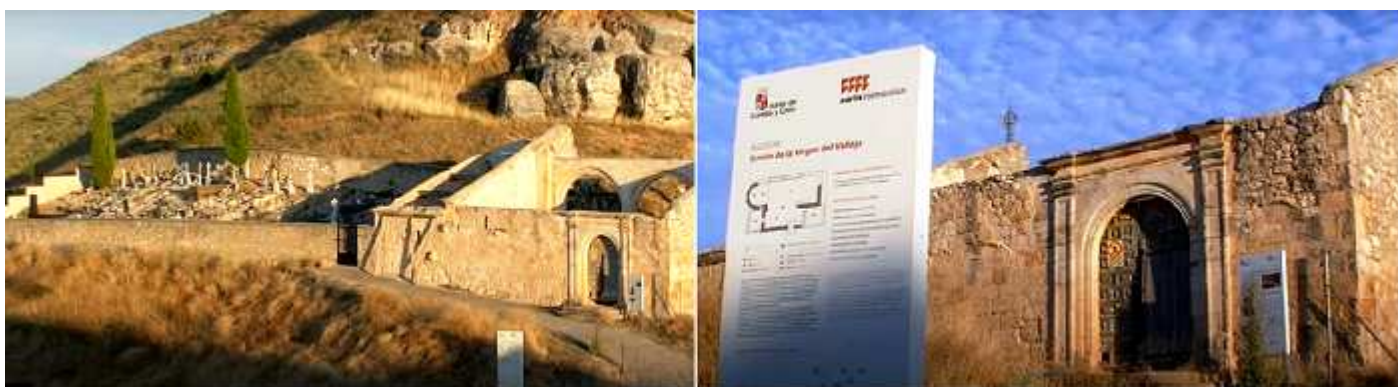
1 Fachada colindante con el Campo Santo colindante. Se conservan los arcos que separan las dos naves 2 Fachada norte con su puerta renacentista. Fotos: Asociación Alcozar.
