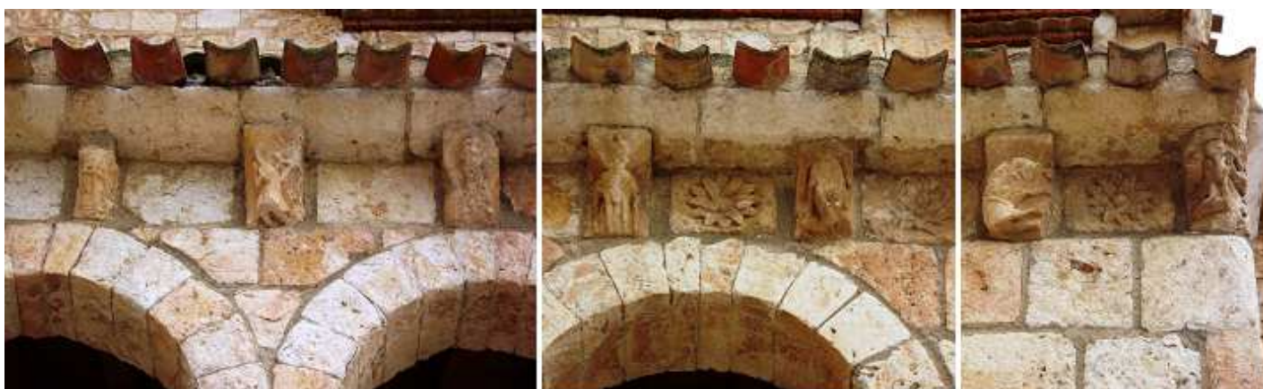
❶ - ❷ - ❸ Diferentes canecillos de izquierda a derecha sobre el pórtico y metopas con flores, en el lado de la derecha.
