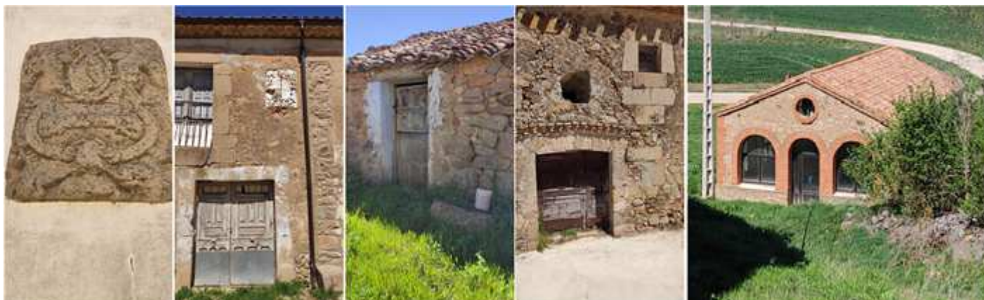
❶ Algunos escudos reutilizados en viviendas. ❷ Restos de otro sobre esta fachada. ❸ Construcción antigua. ❹ Casa con una puerta de arco rebajado. ❺ Lavadero una construcción de 1958. Fotos: Sara Vera Asensio.
