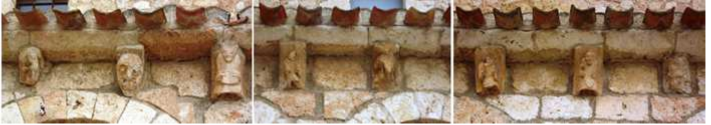
❶ - ❷ - ❸ Diferentes canecillos de izquierda a derecha sobre el pórtico y metopas con flores, en el lado de la derecha.
