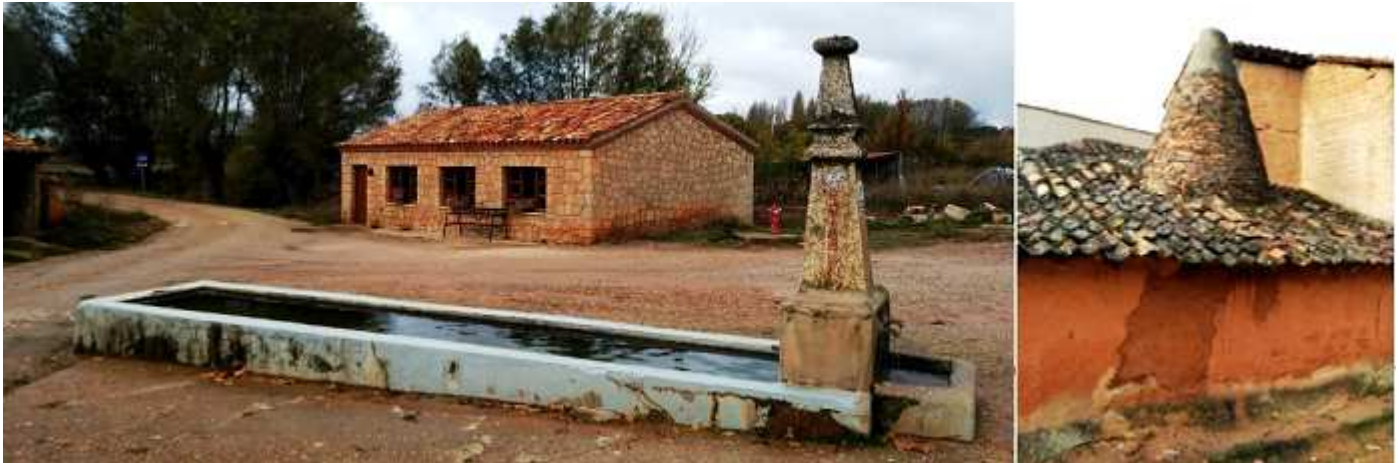
❶ La fuente y abrevadero existente. ❷ La chimenea pinariega construida con piedras y forma troncocónica. Fotos: Ayuntamiento.
