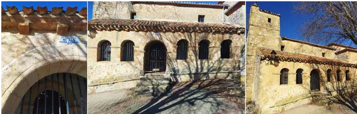
❶ El arco de entradas con baquetón de perfil fino. ❷ La galería compuesta por seis arcos de medio punto. . ❸ Cada arco con impostas de perfil de listel y sin columnas. Fotos: Segio Fernández Barranco.
