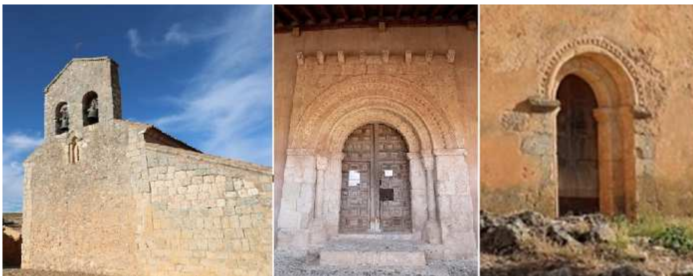
❶ Hastial en el muro oeste con una pequeña ventana bajo su espadaña tardo románica de dos vanos. Es una ventana de aspillera con un arco de medio punto con impostas capiteles lisos y columnillas. ❷ La puerta en el muro sur dentro de la galería porticada. Cuenta con tres arquivoltas ampliamente decoradas, la interior lo hace con flores de cuatro hojas, la interior baquetonada mas una decoración a bolas, y la exterior con entrelazos, bolas y ajedrezado. ❸ En el exterior del muro norte se encuentra esta puerta algo más sencilla que dispone de dos arquivoltas la exterior con un fino baquetón y la otra baquetonada y en el exterior lleva una decoración a bolas, sobre jambas rectas. Fotos: Camping Río Lobos.
