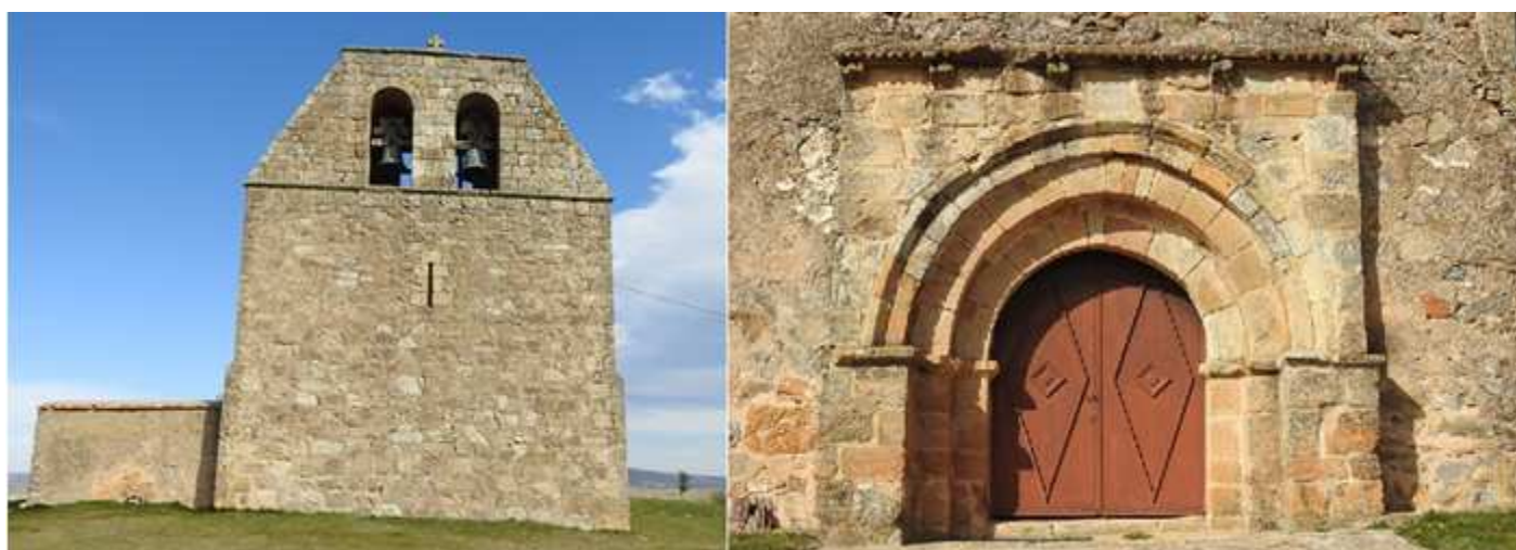
❶ Frontal de su hastial con una pequeña aspillera y sobre la imposta corrida se alza su espadaña de dos vanos. ❷ Detalle de su portada con arquivoltas lisas y guardapolvo, sobre la misma posee un tejeros decorado con cinco canecillos. Fotos: Sergio Tierno.
