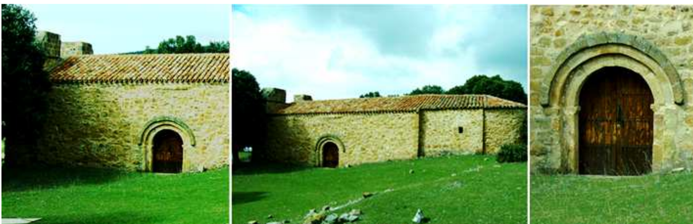
❶ Lateral de la ermita con su portada y en el hastial los restos de su gran espadaña. ❷ Es un templo rectangular, con ábside semicircular. ❸ Portada con dos arquivoltas de arista viva y un gran guardapolvo liso.
