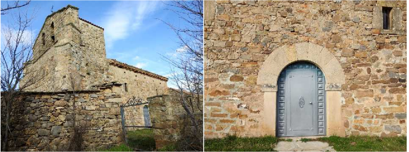
① Detalle del hastial del templo con gruesos contrafuertes y coronado con la espadaña de dos vanos que hace de campanario. ② Su puerta de medio punto con grandes dovelas lisas. Fotos: Sergio Tierno
