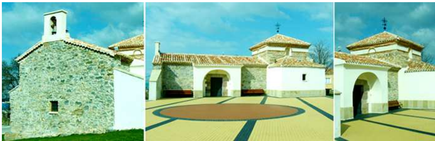
❶ Hastial del templo que posee una pequeña espadaña de un solo vano ❷ Su puerta adintelada protegida por un pequeño porche abierto. ❸ Fachada de la ermita, ante una gran plaza.
