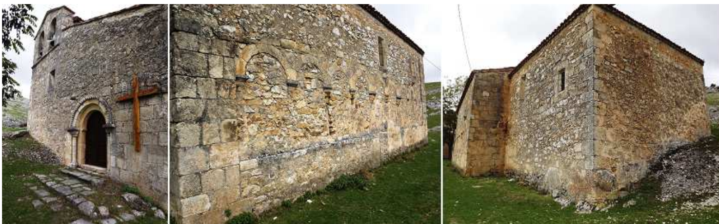
❶ Esta fachada está más elevada que la cubierta de la nave. ❷ Otra imagen del la galería cegada. ❸ Y la parte de su cabecera que es la sacristía.
