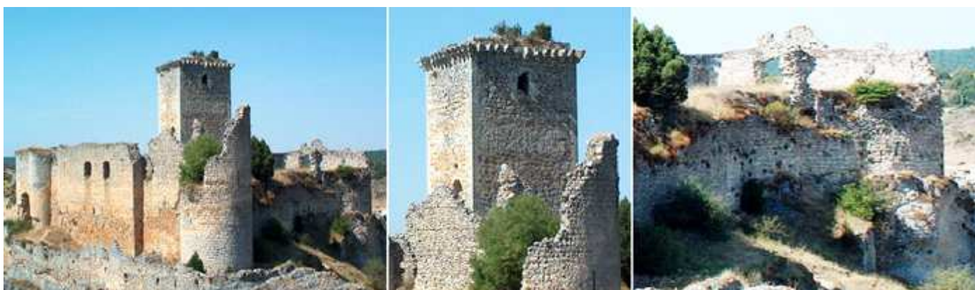
1 Perspectiva del Castillo con su acceso en el ángulo izquierdo con una puerta dotada con un escudo sobre la misma. 2 La torre del Homenaje ante ella los restos de un cubo semicircular. 3 Lateral muy desmoronado. Foto: Wikipedia. CC BY-SA 3.0,
