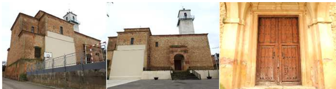
① Fachada del Templo. ② Portada con un atrio abierto que posee un escudo con puerta adintelada ante un tramo de escaleras. ③ Torre que se reconstruyó en 2008-09 con cinco plantas y que posee un elevador interior. Por lo que es un punto panorámico del entorno subir a ella. Fotos: Sergio Tierno.
