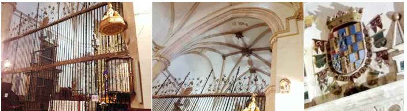
❶ Esta reja gótica es de maestro Osón de 1534 y ayudante del rejero Juan Francés. ❷ Parte superior de la reja que cierra el presbitero y la bóveda de crucería de la capilla Mayor. ❸ A ambos lados del retablo barroco están situados una pareja de escudos
