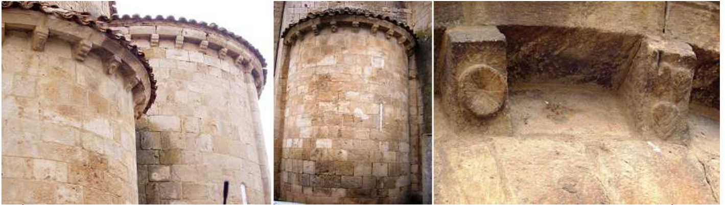
❶ Ábside de la Epístola y central, que cuenta con cuatro columnas adosadas y sus capiteles con motivos vegetales. ❷ Ábside del lado del Evangelio. ❸ Canecillo con una roseta y otro con tres hojas.
