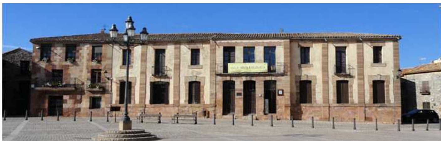
1 Fachada del edificio, en su planta superior se encuentran las salas que lo componen.
