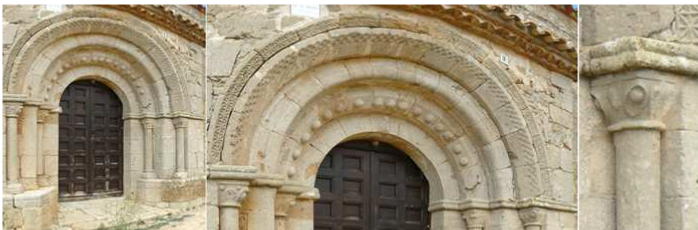
1 Portada meridional. 2 Su portada cubierta con un tejazoz posee cuatro arquivoltas decoradas (del exterior al interior) con taqueado, baquetonada, con bolas y de arista, que descansan en una imposta corrida y una pareja de de columnas con capiteles y jambas rectas. Con un guarda polvo decorado con estrellas. 3 Detalle de una de sus columnas. Foto: Wikipedia. CC BY-SA 3.0 De Rowanwindwhistler
