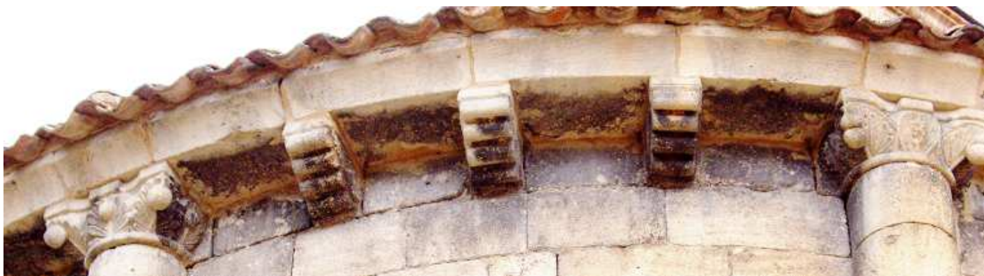
❶ Bajo la cornisa podemos apreciar modillones de cuatro rollos escalonados en buen estado de conservación.
