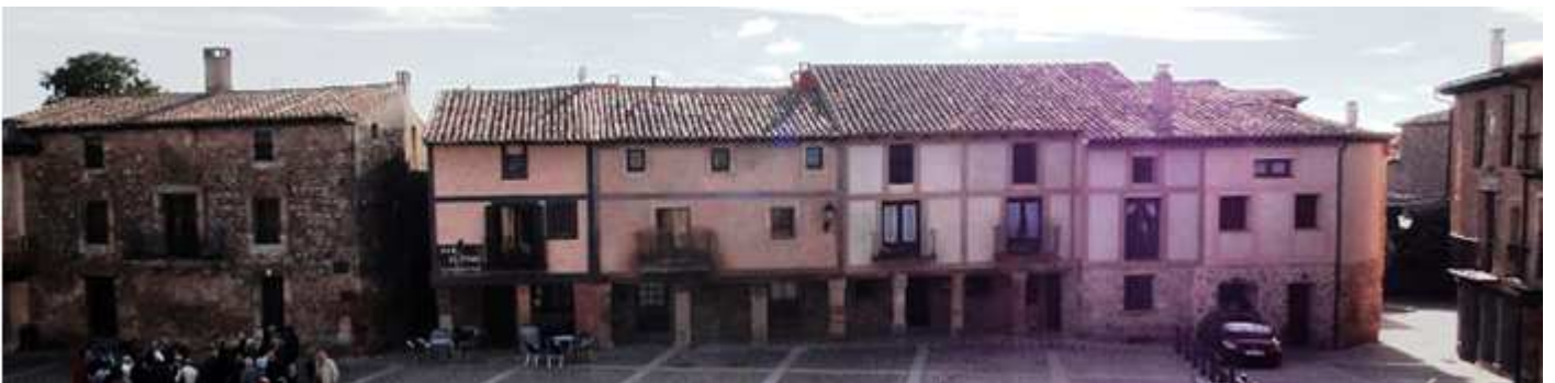
❸ Otro de los tramos de esta plaza con algunos espacios porticados.
