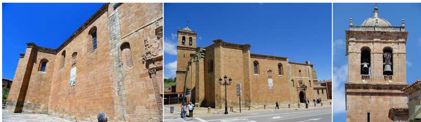
❶ Lateral de lado de la Epístola y al fondo la cabecera de la capilla de Nuestra Señora del Azoque. ❷ Fachada sur de la concatedral. ❸ La torre de sillería.
