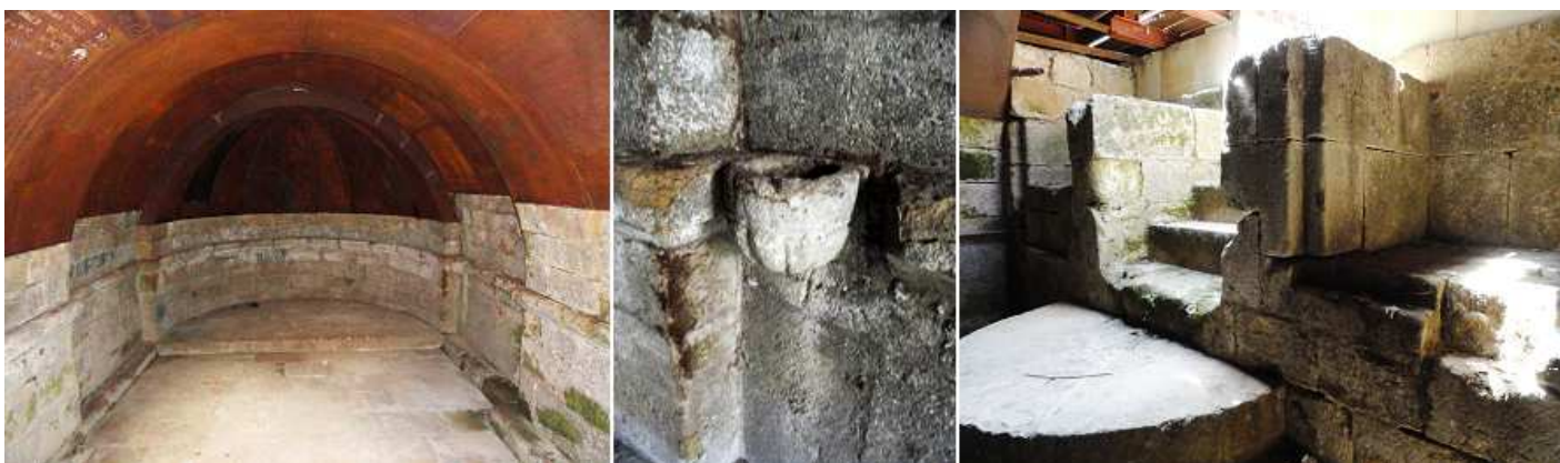
❶ Imágenes de los restos de su cripta y la parte superior restaurada. ❷ En el lateral de la Epístola dispone de esta pequeña pila de agua bendita que esta encastrada en la pared, y con una sencilla labra en su parte inferior de gallones en relieve. ❸ Parte inferior con su escalera que sus primeros peldaños de adentran en la misma cripta.
