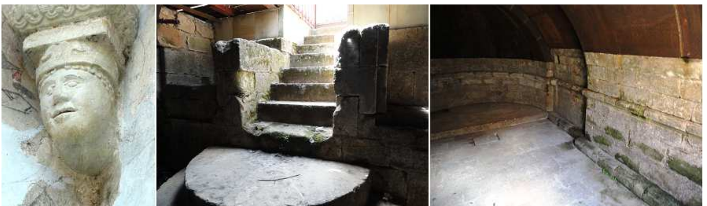
❶ Ménsula con una cara humana en el arranque de la bóveda donde están las pinturas. ❷ Escaleras de bajada a la cripta. ❸ Lateral de lado derecho, y una imposta corrida redondeada recorre toda la cripta.
