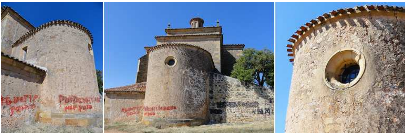
1 Parte posterior del templo con el resto del ábside románico. 2 Imagen de la cabecera por su exterior. 3 Un óculo muy simple en la parte superior y un alero liso y sin canchillos, todo ello construido con cantería salvo la bancada de bloques.
