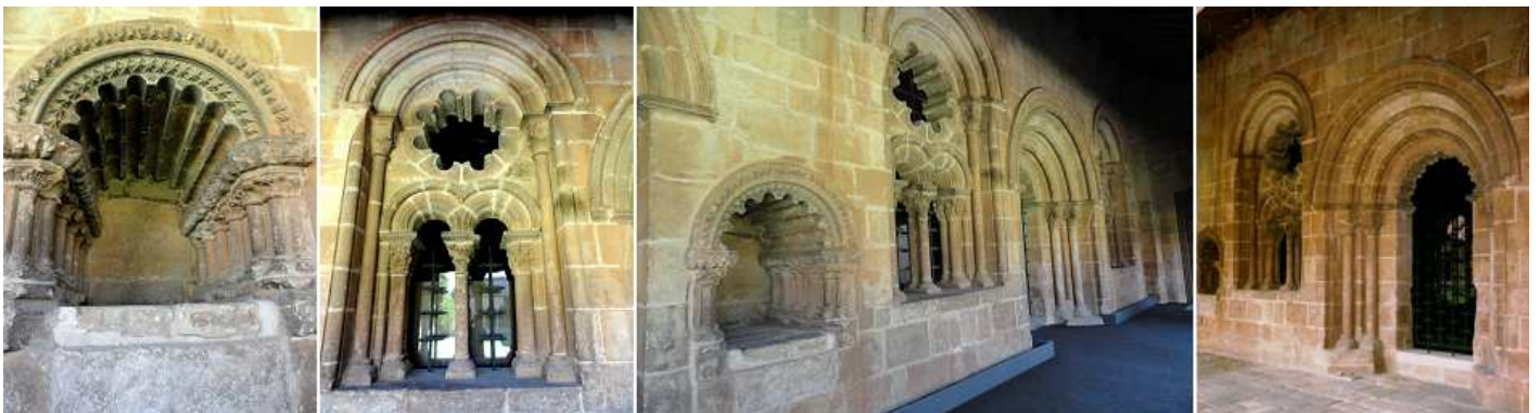
❶ Pequeña urna sepulcral con su bovedilla lobulada y que en sus laterales hay cinco columnillas ❷ Ventana de la sala Capitular con dos arcos y un óculo encima lobulado. ❸ Sala Capitular, hoy capilla de San Saturio. ❹ Portada con tres arquivoltas.
