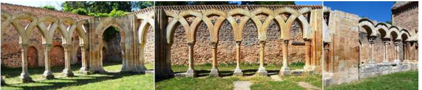
❶ La segunda parte de la panda sur ya con arcos cruzados y ligeramente apuntado con una bella puerta de herradura. ❷ Frontal del lado oeste, ya junto a la puerta de entrada en el recinto. ❸ Y su segunda parte que son con arcos de medio punto.
