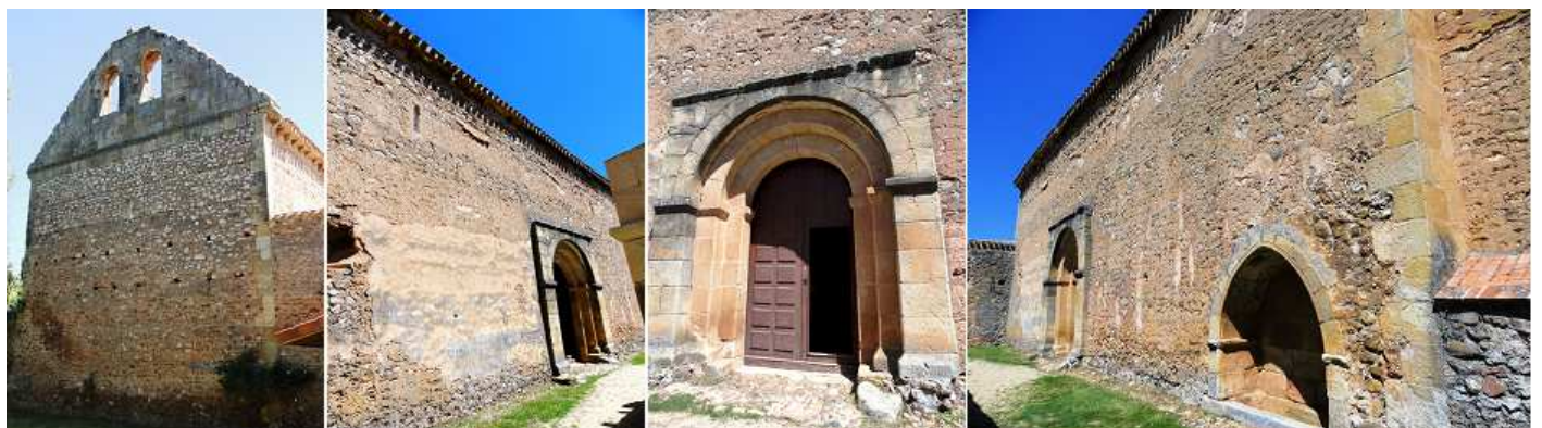
❶ Hastial culminado con una espadaña de dos vanos. ❷ Lateral con la portada adelantada. ❸ Puerta de tres arquivoltas lisas. ❹ En el lado de la portada, hay un arcosolio.
