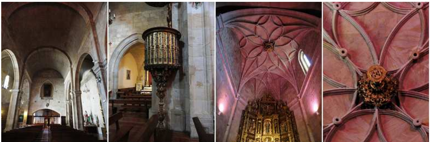
❶ Imagen de la bóveda de cañón de la nave central ❷ Púlpito sostenido por una columna. ❸ Bóveda de crucería del presbiterio y ábside. ❹ Clave de la bóveda con el escudo de los Calderones.
