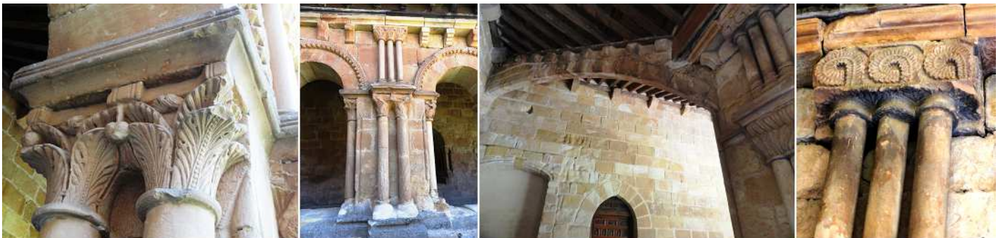
1 Capitel 1º a nuestra derecha doble con palmetas. 2 Pilastra con tres columnillas en la parte superior y dos en la inferior y sus capiteles con decoración vegetal. 3 Arco en la unión de las alas oeste y norte. 4 Pilastra de la esquina en su interior con tres columnillas arriba con un capitel con tres roleos formados por hojas.
