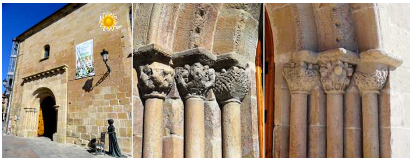
1 Portada adelantada bajo un tejazoz, con tres arquivoltas con arco de medio punto, que descansan sobre una imposta corrida y esta sobre tres parejas de capiteles decorados. Existe un Reloj de Sol en la parte derecha de su puerta. Debajo de una marca de cantero. Tipo: Canónico horizontal, posiblemente semicircular. Con los trazos excavados. Orientación al mediodía. Traza: de la Nona, Sexta y Nona. Gnomon de varilla inexistente. Estado: apenas perceptible 2 - 3 Detalle de sus capiteles con motivos vegetales, aves, lazos entrecruzados, centauros luchando, etc.
