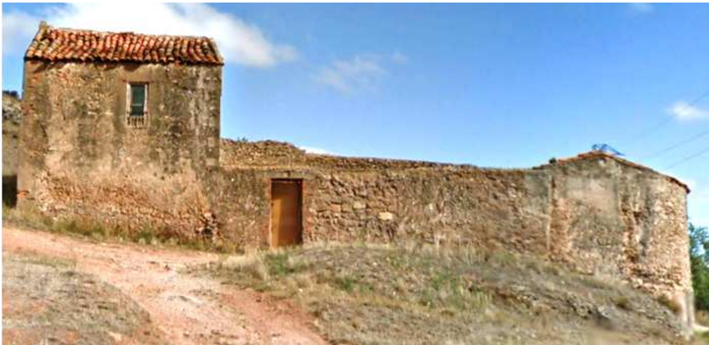
🕒 Fachada sur con la vivienda, la nave que ha perdido su cubierta que debió de ser madera, un corto presbiterio y si cabecera semicircular. Su puerta adintelada sustituyó a la de medio punto que debió de estar situada más a su derecha.
