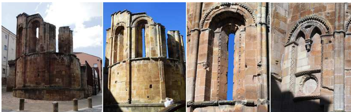
📍 Ábside de San Nicolás de Bari. 📍 Su ábside está dividido por pares de columnas redondas adosadas en cinco partes y abierto con tres ventanas y dos ciegas. 📍 Detalle de una de sus ventanas abiertas con doble derrame. 📍 Una de las ventanas ciegas, la otra opuesta ha desaparecido con doble arco cruzado.
