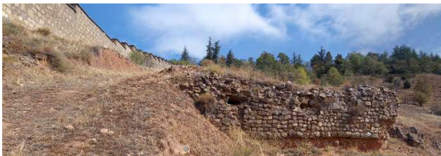
🕒 Restos junto a las tapias del Cementerio Municipal del Espino. ¿Son realmente de la iglesia o de las murallas?
