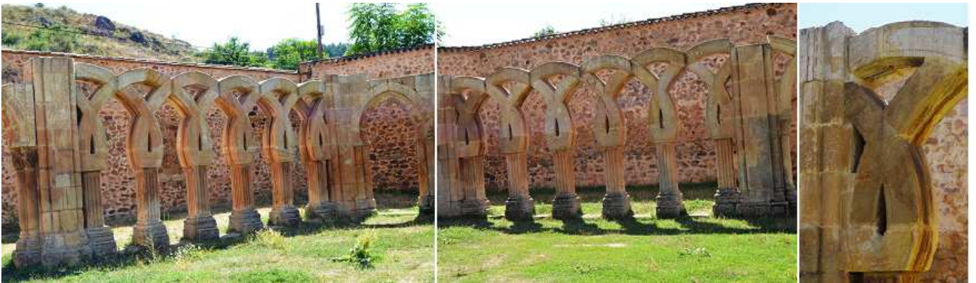
❶ Lo mismo ocurre en esta lado este, la segunda parte con arcos entrecruzados sobre columnas cuadradas y acanaladas. ❷ La ala sur continúa en el mismo tipo de arcos. ❸ Detalle de los arcos entrecruzados de forma secante.
