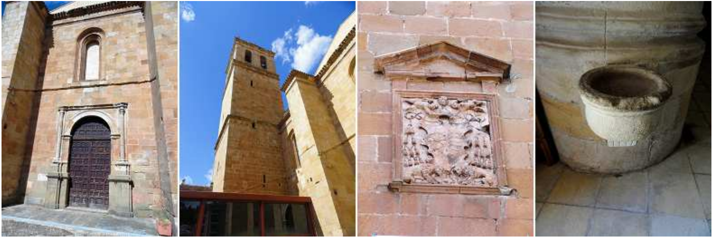
1 Portada oeste de medio punto con dos pilastras acanaladas a sus lados. 2 A los pies del templo esta adosada su torre, junto a la entrada para las visitas del Claustro. 3 Escudo de Obispo Acosta?. 4 Pila de agua bendita a la entrada de la puerta principal.
