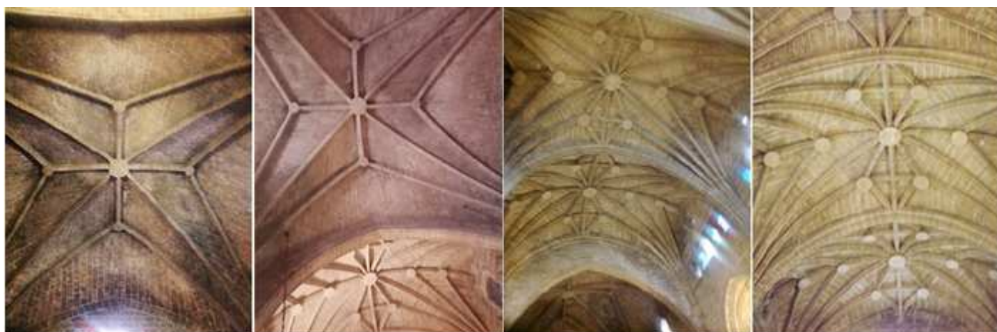
❶ Bóveda del presbiterio y cabecera. ❷ Desde este arco peripiaño que separa el ábside de la nave del S. XIV - XV. ❸ Tramo tras el presbiterio. ❹ Y primer y segundo tramo de la nave. En todos los tramos sus nervios con claves sin decorar.
