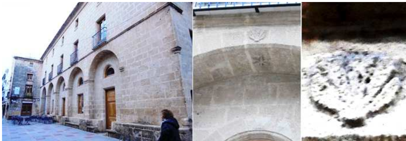
1 Sobre los cinco arcos (cuatro cegados Una imposta corrida recorre el edificio. 2 Los cinco arcos en su clave central ostentan una concha. 3 Emblema del Camino de Santiago.
