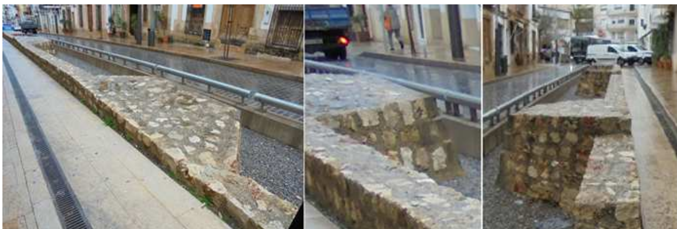
❶ Está construida con mampostería y bloques calcáreos. ❷ la intervención actual, a consistió proteger la obra original aumentando unos 60cm. Para hacer más visible. ❸ Sobre el muro se aprecian una ampliaciones, la mitad de un hexágono.
