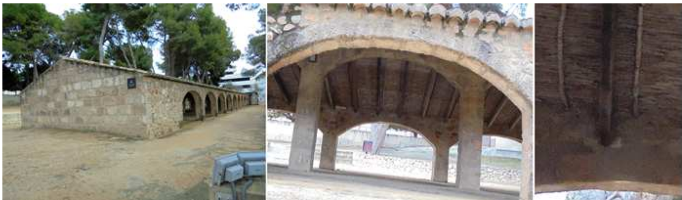
1) Cabecera de la parte norte. 2) Su interior lo componen dos naves que estas separados por arcos rebajados, lo mismo que los que posee hacia el exterior. 3) Con una cubierta a dos aguas con un entramado de tablonos y cañizos que sostienen las tejas.
