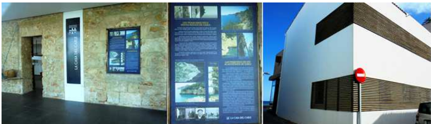
❶ Imagen interior. ❷ Información sobre las pesquerías de Jávea. ❸ Y la parte posterior de este moderno edificio tras su reforma. También aquí estuvo ubicado el oratorio o capilla marinera de la Virgen de Loreto.
