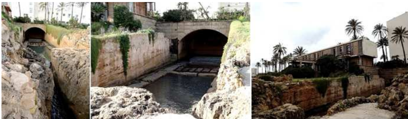
❶ Bajo nuestros pies la entrada del canal del mar. ❷ Este estanque-vivero para la conservación del pescado vivo. ❸ Sobre el mismo las instalaciones de del que fue gobernador del Banco de España, y economista.
