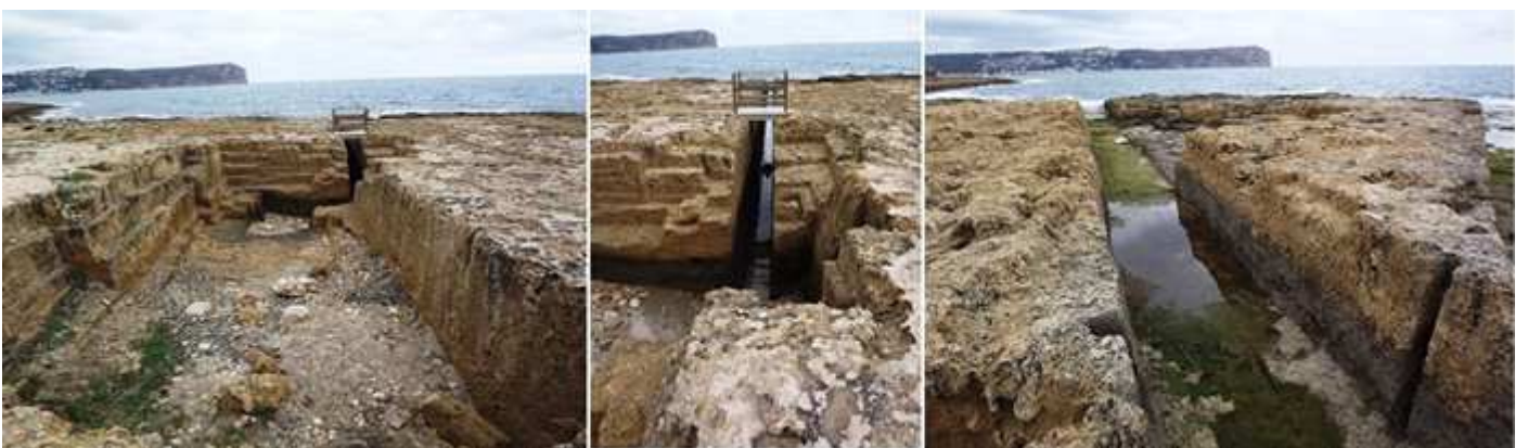
❶ También dispone de un espacio mucho mayor en su capacidad de embalsar el agua. ❷ Y la entrada final junto al mar. ❸ En los costados del este brazo igualmente se aprecia las hendiduras que con tablonjes harían de compuertas para retener el agua.
