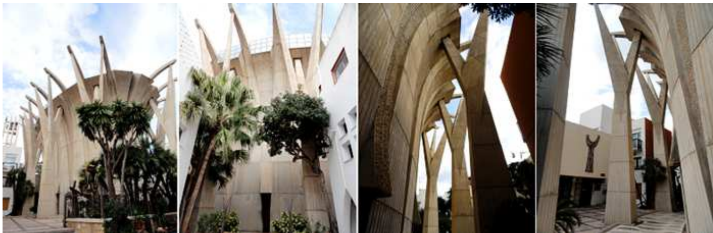
1 Entrada con un pequeño jardín. 2 Sorprende en su interés los tirantes arqueados. 3 Que contienen su fachada en forma de barco. 4 Detalle de los tirantes que tienen dos brazos al exterior más uno que perfora la fachada y por el interior suben por los muros uso nervios a modo de columnas que se unen a las puntas de los brazos.
