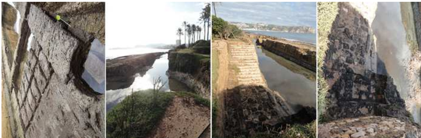
❶ En un lateral junto a las escaleras se encuentra una poza redonda. ❷ Continuamos y a la derecha otra parte de las instalaciones. ❸ Que parte de la misma tiene un trazado rectangular. ❹ Escaleras de bajada, esta foto como la anterior en un momento de marea alta. ❺ Al pie de las escaleras, parte del suelo conserva las losa del suelo y su parte de muro de sillar.
