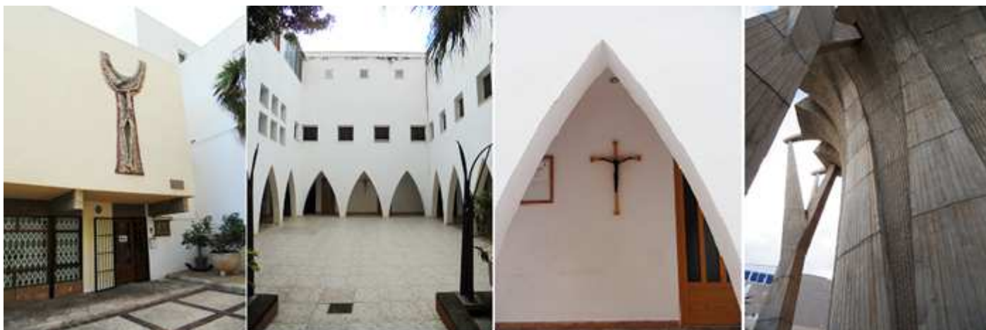
1 Edificio parroquial. 2 Patio colindante a modo de claustro. 3 Con tres pandas con estos arcos apuntados. 4 Detalle del exterior del templo que todo fue realizado con hormigón.
