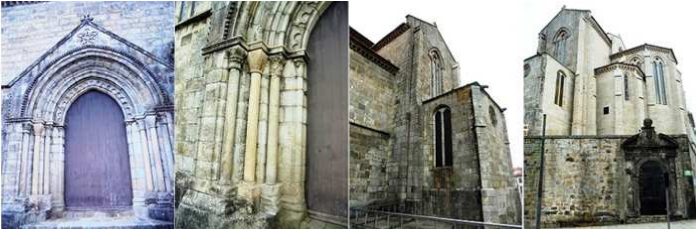
❶ Portal epistolar con cuatro arquivoltas las interiores con diferentes baquetones y la exterior con arquillos un guardapolvo decorado con bolas, sobre la puerta un gablete con un pentagrama. ❷ Lateral de las columnas y capiteles del lado izquierdo. ❸ En esta parte que colinda con la Rua do Infante D. Henrique mantiene una terraza que nivela el terreno con esta puerta lateral
