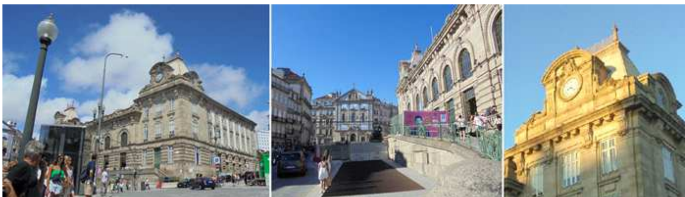
1 Esta construcción da a tres calles. 2 Y cuenta con un parqueo subterráneo. 3 En el ángulo superior de su fachada 2 relojes.
