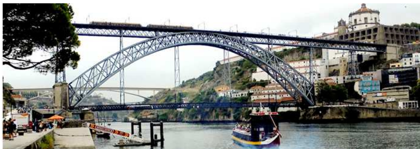
❶ Panorámica del puente Luis I, cuando se construyó fue el puente de hierro más grande del mundo.
