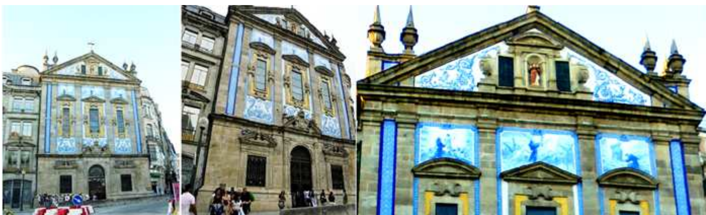
1 Fachada con dos cuerpos de la Iglesia de San Antonio de los Congregados 2 Una sobria fachada al gusto portugués. 3 En la parte superior del segundo cuerpo se aprecia las escenas de San Antonio Trabajando coronada con un frontis triangular con pináculos y una hornacina con el santo.
