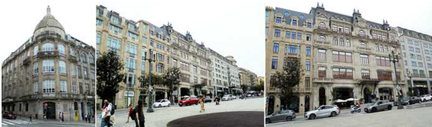
❶ Edificio con una gran cúpula cónica. ❷ Edificaciones que por lo general se encuentran en el estilo clásico. ❸ Edificio Monumental, Av. dos Aliados 221.
