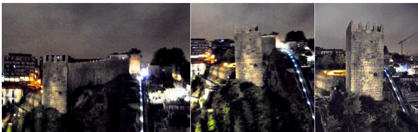
① Otra vista de esta parte de las murallas desde la plataforma alta del Puente de Luis I. ② Único fragmento que sobrevive de la Muralla Primitiva de origen romano. ③ El cubo de estas murallas que domina el río y la orilla opuesta de Vila Nova de Gaia. ④ m. ⑤ m.
