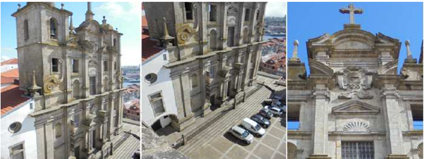
❶ Fachada con columnas corintias en su puerta principal. ❷ Su fachada marcada por dos cuerpos y dividida en cinco partes por sus columnas, dispone de dos torres campanario a los lados. ❸ Emblemas y escudos de la orden junto con la cruz que se alza en lo alto y otro escudo sobre la puerta.
