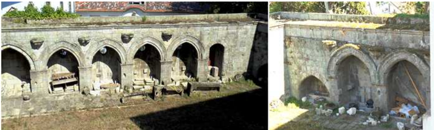
❶ Lateral oeste con arcos apuntados baquetonados donde se alojan restos constructivos y algunos sepulcros. ❷ Lateral sur se aprecian que los arcos poseen un guarda lluvias que con la arquivolta del arco descansa en una imposta.
