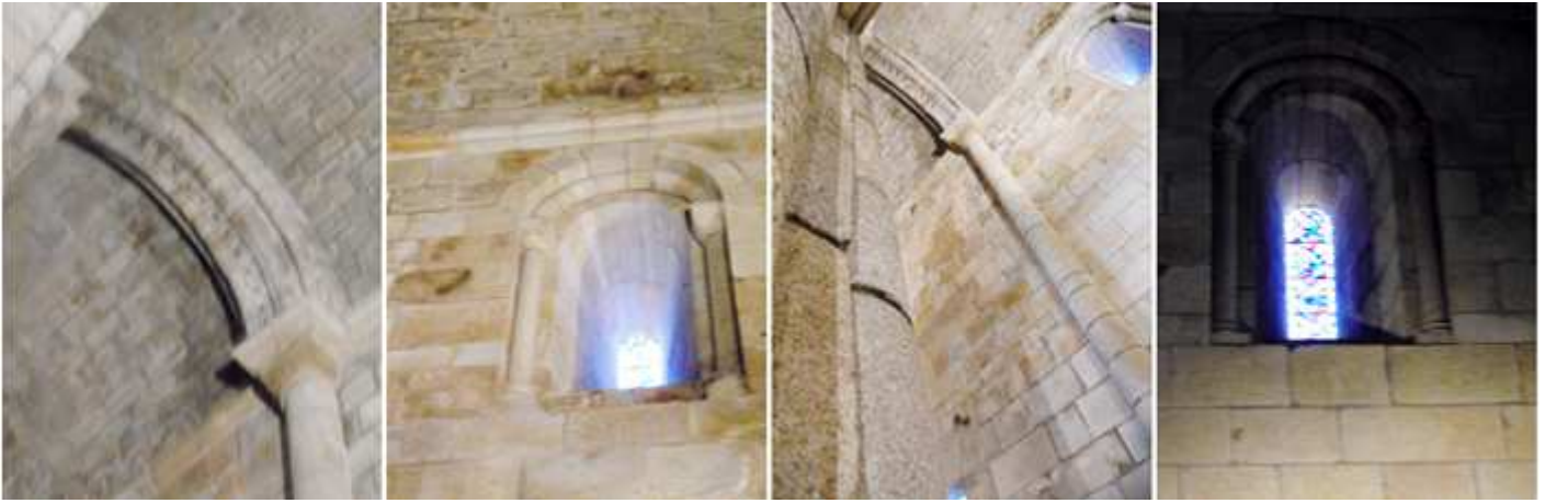
❶ Arco de nave lateral baquetonado y con decoración de bolas en su interior, sostenido por las columnas redondas adosadas con capiteles con decoración de cesta (algunos de estos capiteles pertenecen al original templo románico). ❷ Detalle de la imposta corrida sobre la ventana. ❸ Otro detalle de los arcos de este lado epistolar lateral. ❹ Las ventanas poseen vidrieras.
