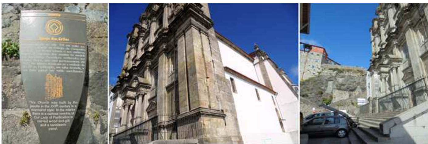
1 Información del templo. 2 El resto de sus muros son encalados. 3 La plaza con el enorme desnivel con el mirador . de Rúa das Aldas.
