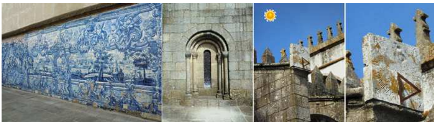
❶ En un lateral de la terraza este se encuentra este mural de azulejos. ❷ Ventana con tres arquivoltas baquetonadas las exteriores y recta la interior del lateral de la Epístola de la iglesia. ❸ En uno de de los contrafuertes de un arbotante posee este reloj de Sol. ❹ Tipo: vertical, cuadrado. Con los números y horas excavados. Orientación al mediodía. Traza: de las 7 a las 5h. p.m. en números romanos. Gnomon de escuadra. Estado: perfecto. Año: 1679.
