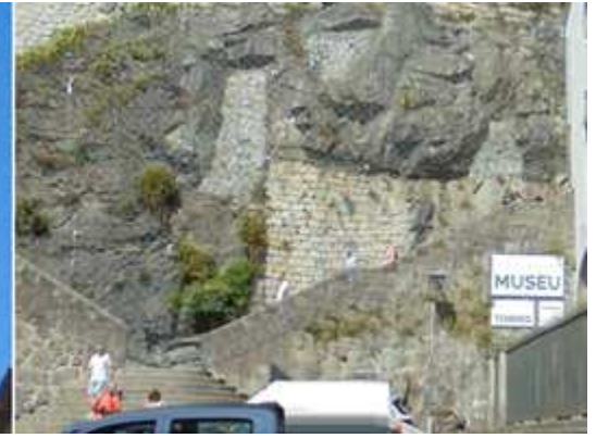
❷ Y las escaleras que descienden hasta la plaza
