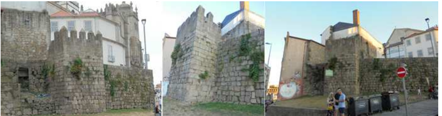
❶ De esta cerca solo se conserva dos tramos de mura y este cubo. ❷ Torre de planta cuadrada y que conserva sus almenas. ❸ Continuando a la derecha se acerca una a la catedral.
