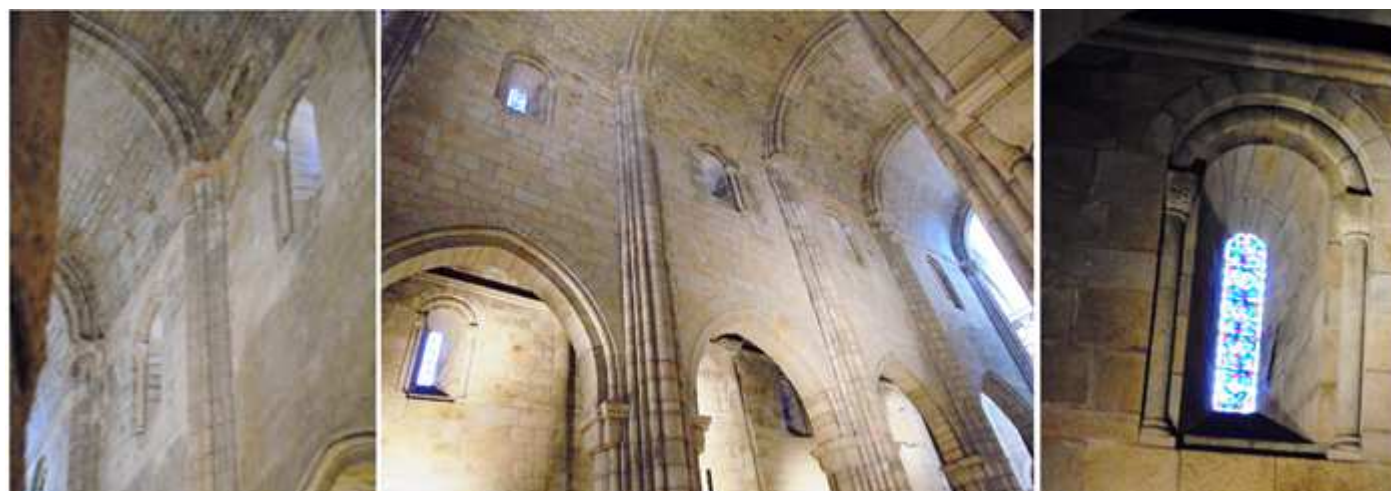
❶ En cada tramo de la nave posee una ventana de medio punto con una arquivolta. ❷ Pilares compuestos que sustentan los arcos torales de las bóvedas de las naves. ❸ Ventanas con gran derrame interior con una arquivolta baquetonadas con columnillas y capiteles con formas vegetales.
