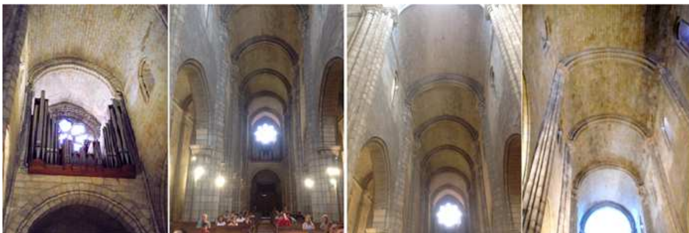
❶ En 1985 se instaló en el coro un gran órgano de tubos de la empresa alemana Georg Jann. ❷ Columnas redondas adosadas con capiteles sostienen los arcos formeros de la bóveda. ❸ Las naves poseen cinco tramos. ❹ En el rosetón, sus vidrieras nos muestran a la Virgen en el centro y rodeada de los cuatro evangelistas.
