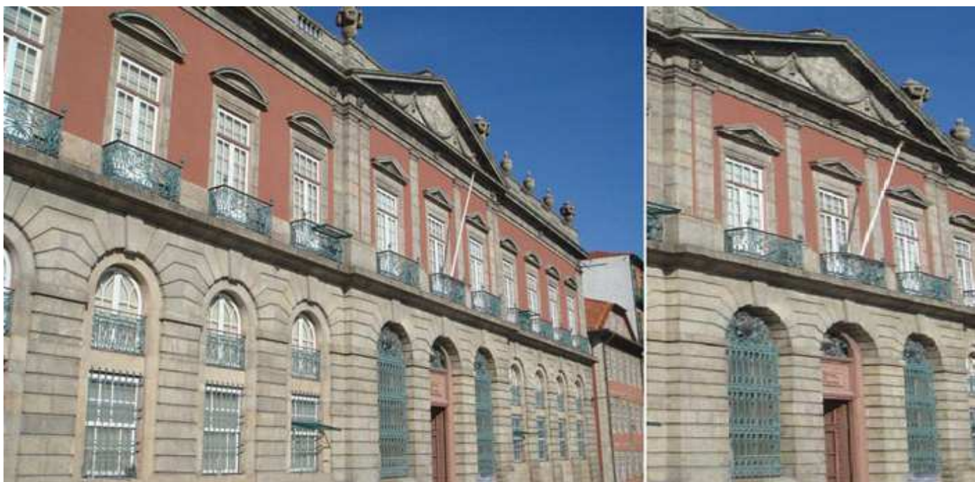
1 Fachada de este palacio llamado de Carrancas, por el mal genio de su propietario de la Familia Morais e Castro que asentaron aquí su residencia y fábrica. Este importante complejo cuyo edificio es de estilo neoclásico. 2 Y el cuerpo central con un frontis triangular con guirnalda y todo su alero con jarrones, Foto Wikipedia
