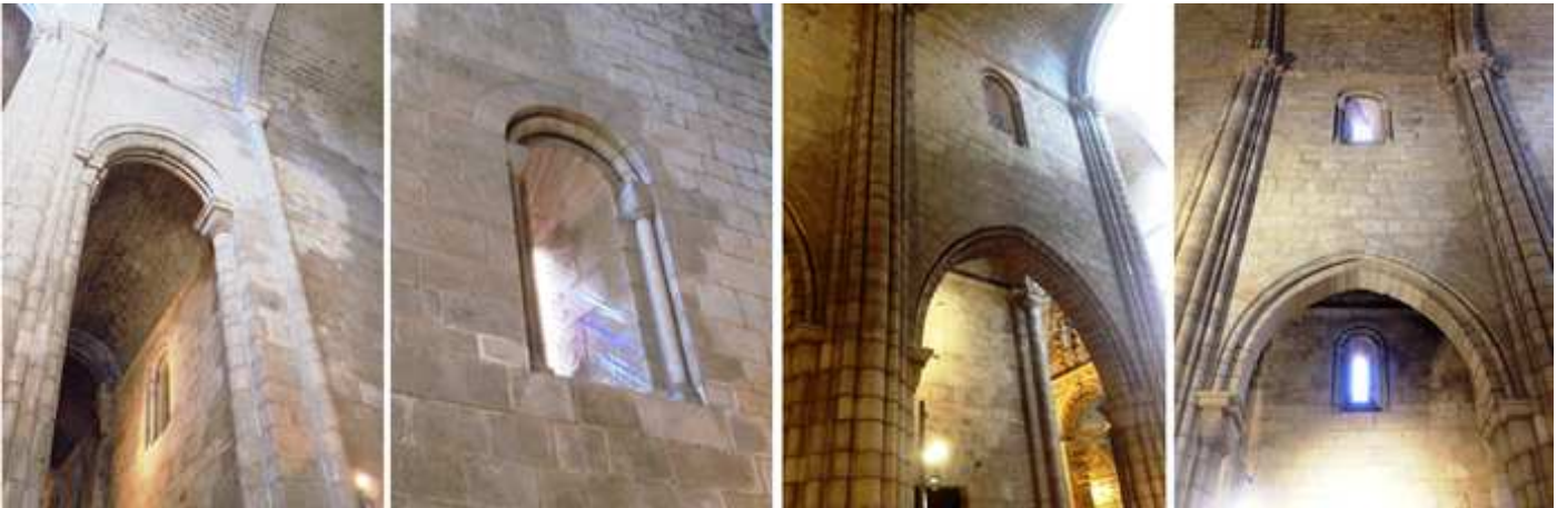
❶ Arco en el crucero derecho. ❷ El derrame de sus ventanas declara la profundidad de los muros laterales de la catedral. ❸ La nave central se comunica con las laterales mediante arcos apuntados. ❹ A sus lados los haces de columnas adosadas a sus pilastras.
