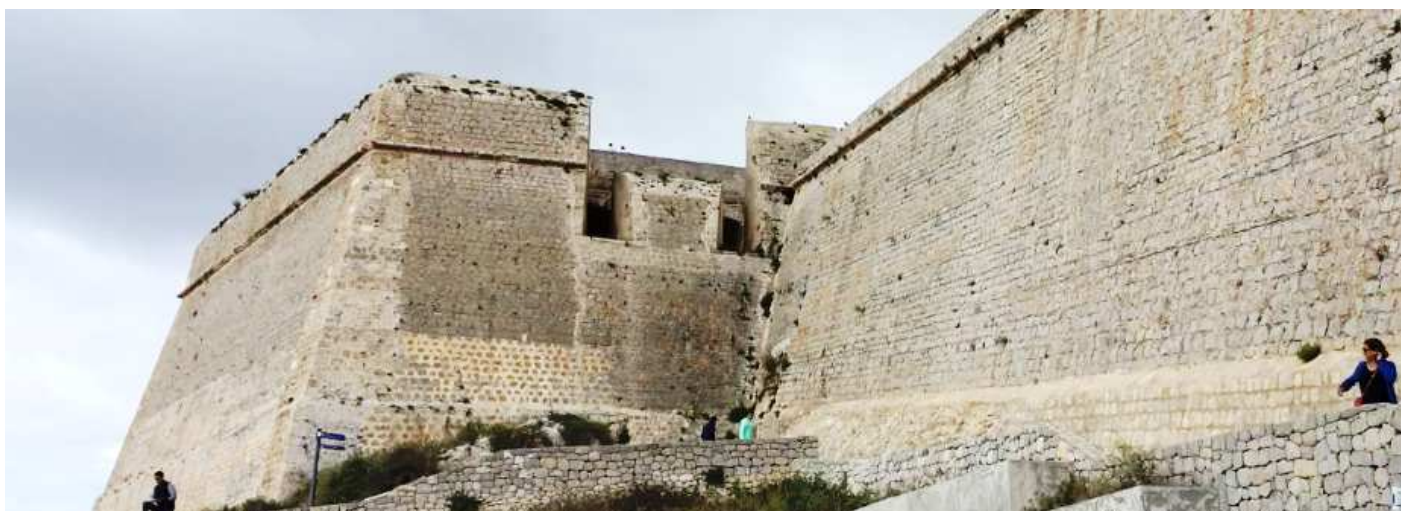
❶ Baluarte de San Bernardo. En la parte inferior de la foto se encuentra el aparcamiento de coches. Es la opción más cómoda para llegar a la catedral y después de forma descendiente por toda la ciudad vieja.
