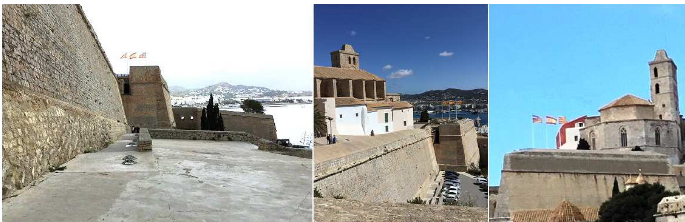
❶ Lienzo de la muralla entre el bastión de San Bernardo y el de Santa Lucía. ❷ Situado en la parte posterior de la catedral. Vista desde el baluarte de Santa Tecla. ❸ Instantánea con el ábside de la catedral y el otro lado del bastión
