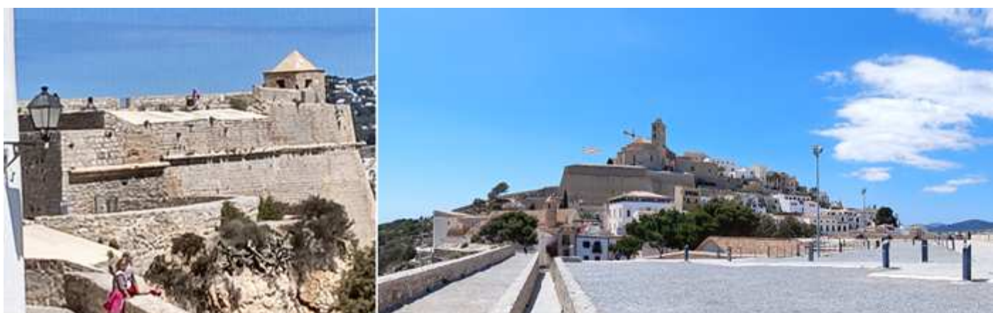
❶ Exterior del baluarte de Santa Lucia. ❷ Es el de mayor dimensión de todos los baluartes que dispone la cerca de esta fortaleza..
