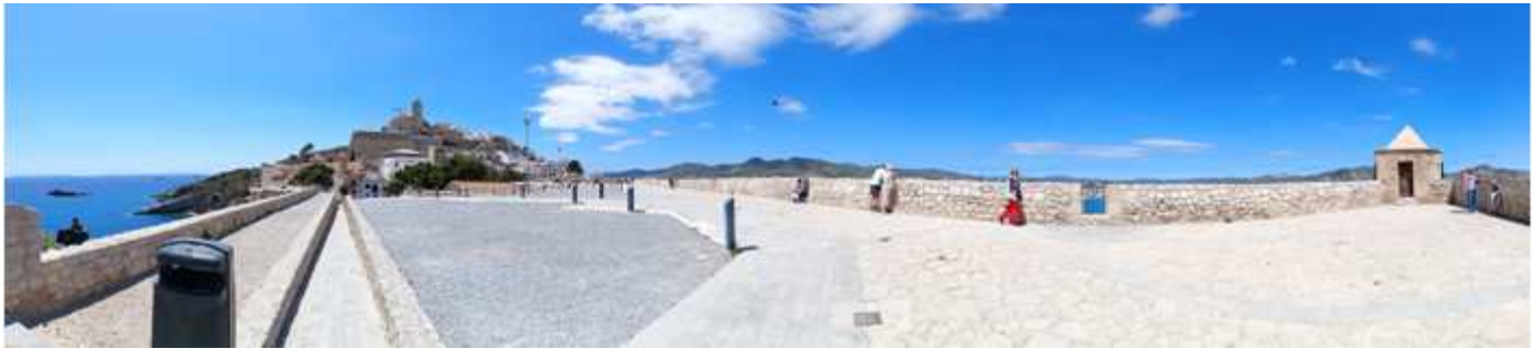
❶ Panorámica de este baluarte, en la parte central del mismo (que pasa desapercibido, se encuentra la instalación semi enterrada).
