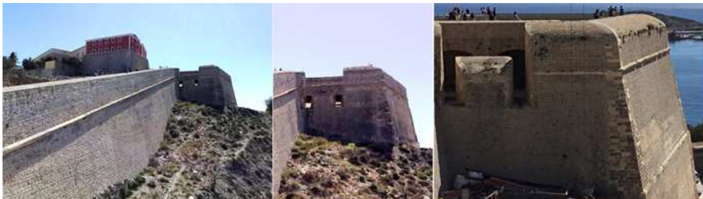
❶ Y llegamos al baluarte más alto de la fortaleza. ❷ En esta cara y en la opuesta dispone de dos espacios con casamatas para las piezas de artillería. ❸ Primer plano de este lado con la construcción con la característica en forma de talud.
