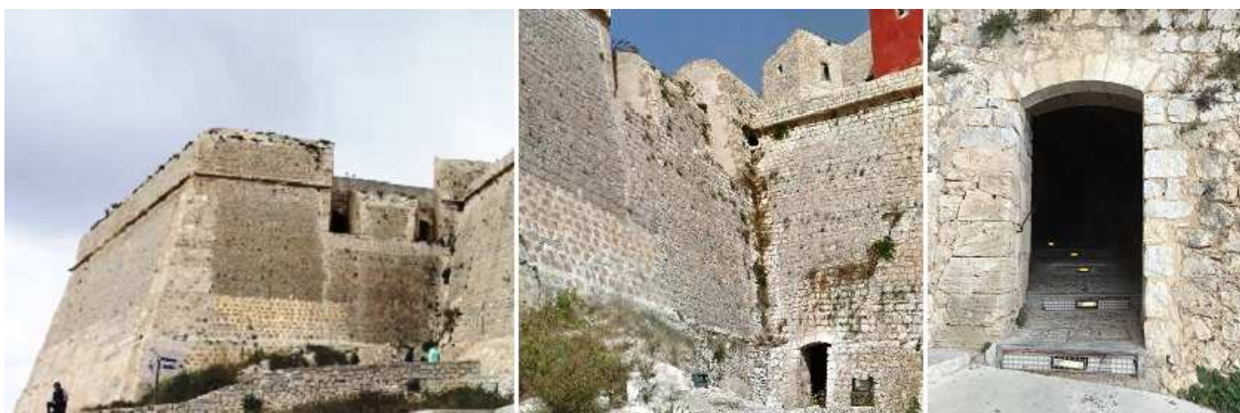
❶ Parte que mira hacia Santa Tecla con dos casamatas. ❷ En el ángulo con la muralla tiene una entrada. ❸ Que da al interior de la fortaleza.
