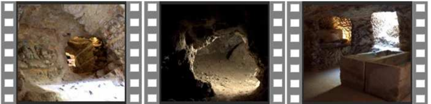
❶ Diversas perforaciones que emplearon los saqueadores. ❷ Por lo que algunas cámaras se comunican unas con otras. ❸ Otro lateral también perforados.
