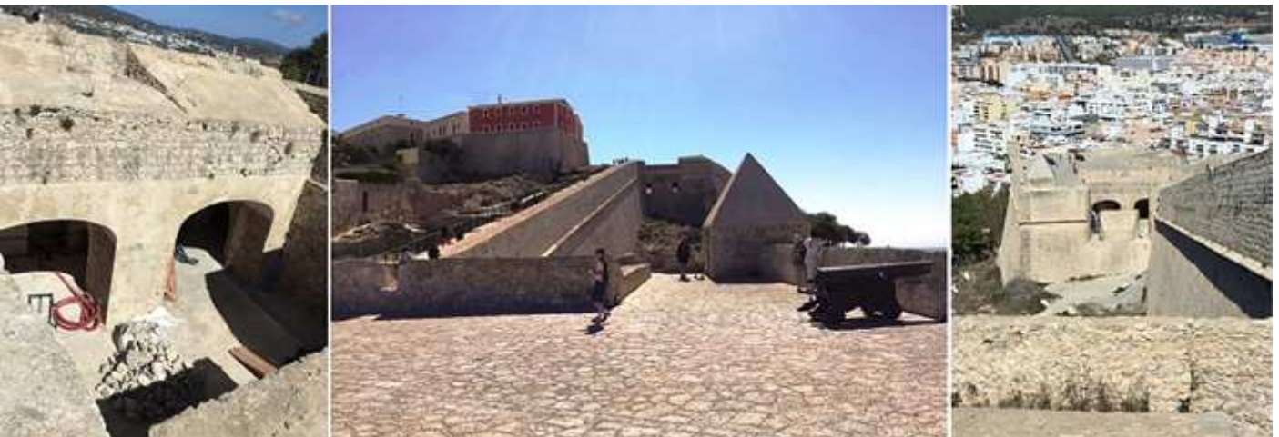
❶ Parte inferior en obras. ❷ Y algo mas alto el baluarte de San Jorge al fondo. ❸ Desde este último las instalaciones del de San Jaime.
