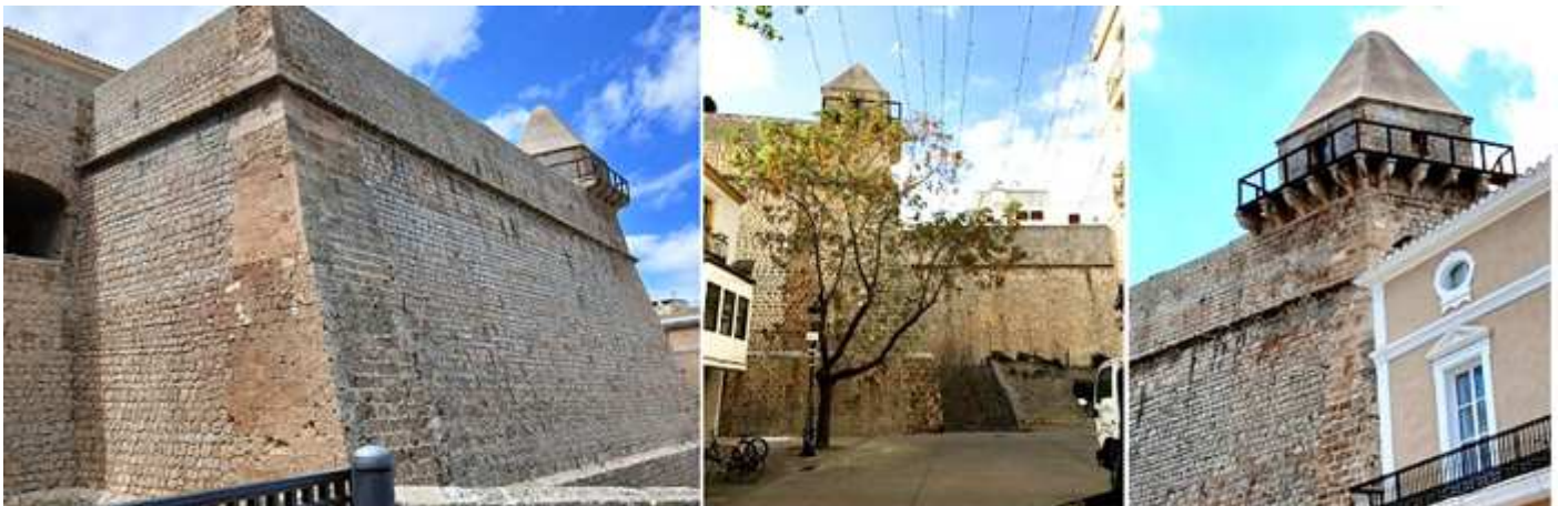
❶ Lateral del baluarte junto al lado derecho de la puerta del Mar que vigilaba. En su interior se encuentra el Museo de Arte Contemporáneo. . ❷ Escaleras que acceden a la rampa del portal de Mar en la calle Obispo Torres Mayans, y el baluarte al fondo.. ❸ Garita de vigilancia en su ángulo del pasaje de Simo Poulet.
