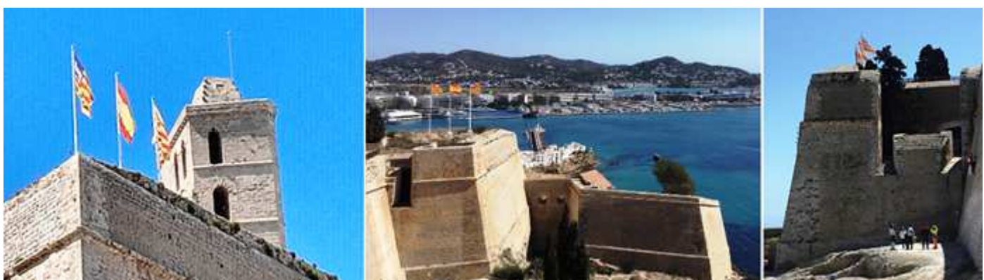
❶ Ángulo superior del bastión de Santa Tecla. ❷ Esta parte superior con el espacio del Es Revelli algo más baja. ❸ En este lado que da a la calle Santa María, posee una casamata para la defensa de este ángulo.
