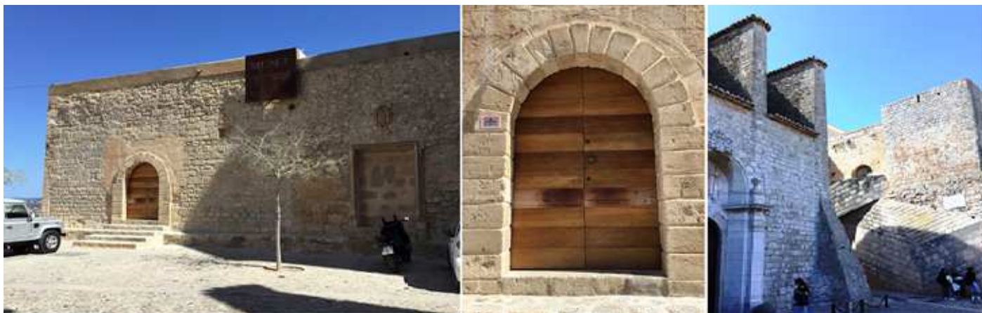
1 Edificio del antiguo Museo Arqueológico. Hasta que fue trasladado al museo de la Necrópolis Museo Monográfico de Puig des Molins. 2 Detalle de su puerta de medio punto con dovelas lisas. 3 Y a la derecha de la Catedral tenemos el castillo de la Almudaina (en obras, pues será el parador de Turismo local).
