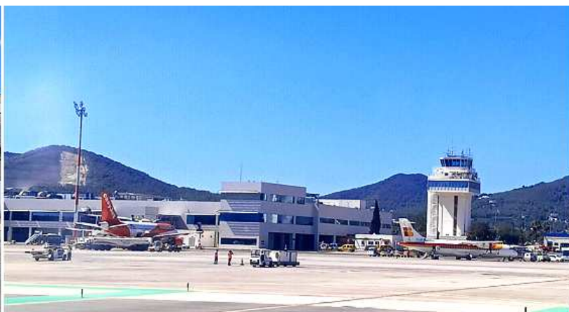
❷ Lateral con la torre de control y otras instalaciones.
