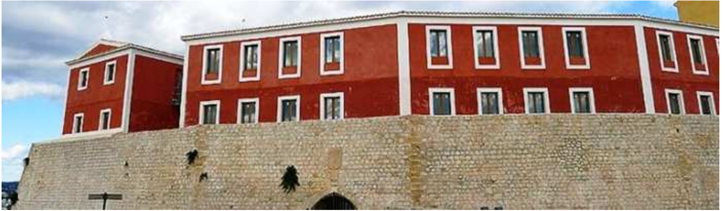
❶ Foto instalaciones del castillo tras la reforma Foto Turismo.
