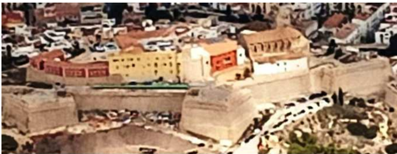
1 Foto reciente desde el avión en 2024, aún sin concluir sus reformas y con anuncio de apertura en 2025.
