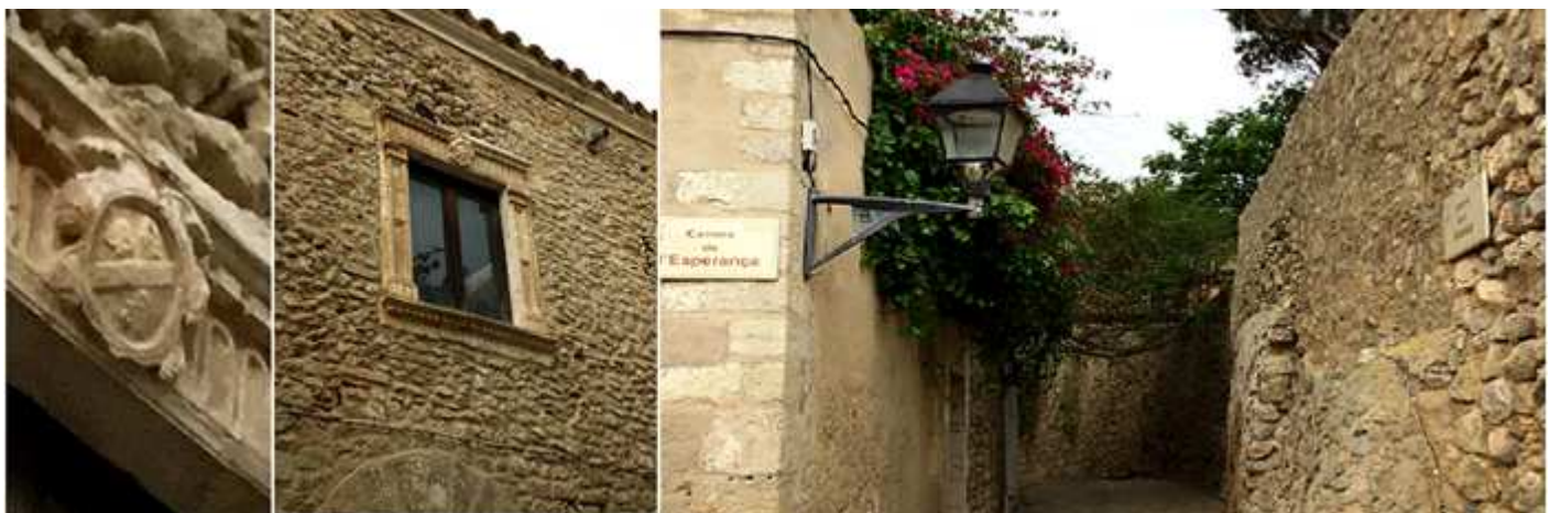
1 En el dintel de su ventana con un escudo heráldico. 2 Sobre su puerta de medio punto posee esta ventana renacentista.
