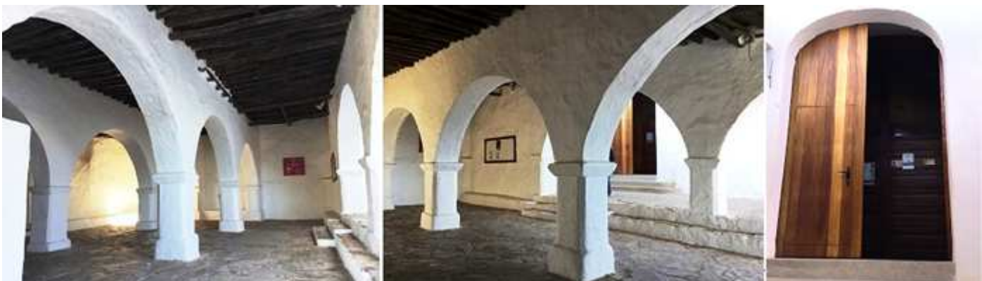
❶ Ante su puerta principal conserva un pórtico o porche compuesto por tres naves. ❷ Cada nave con tres arcadas rebajadas. ❸ Puerta de acceso al templo con unos escalones.
