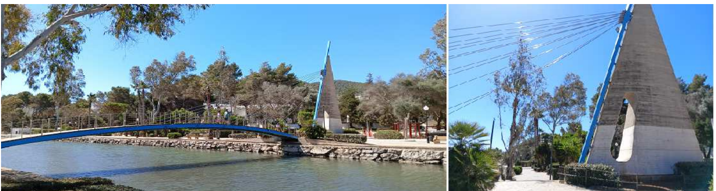
❶ Pasarela peatonal de arco tendido por cables. ❷ Y el contrafuerte de hormigón que mantiene los cables o tirantes del puente.
