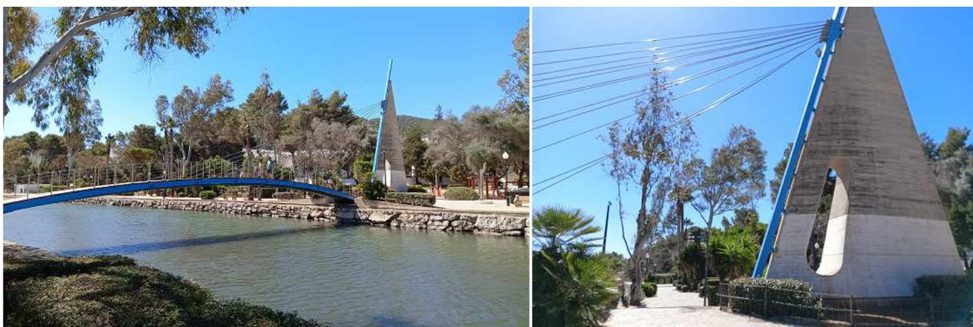
❶ Pasarela peatonal de arco tendido por cables. ❷ Y el contrafuerte de hormigón que mantiene los cables o tirantes del puente.
