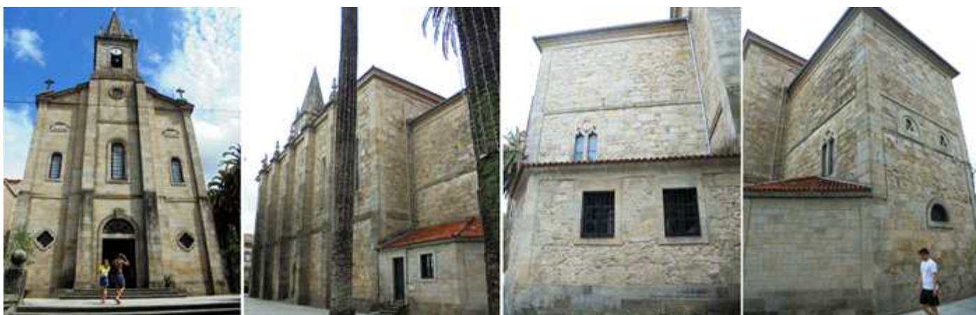
1 Fachada de tres cuerpos entre sus dos contrafuertes, y sobre la parte central se alza su campanario 2 Lateral epistolar del templo frente a la plaza Martín Herrera. 3 Tramo de su cabecera. 4 Y la parte opuesta. Algunos de los bloques de la Torre de Dña Urraca como las ventanas y los pretilos que se pueden ver incrustados en los muros del ábside. Una ventana se aprecia en estas dos fotos.
