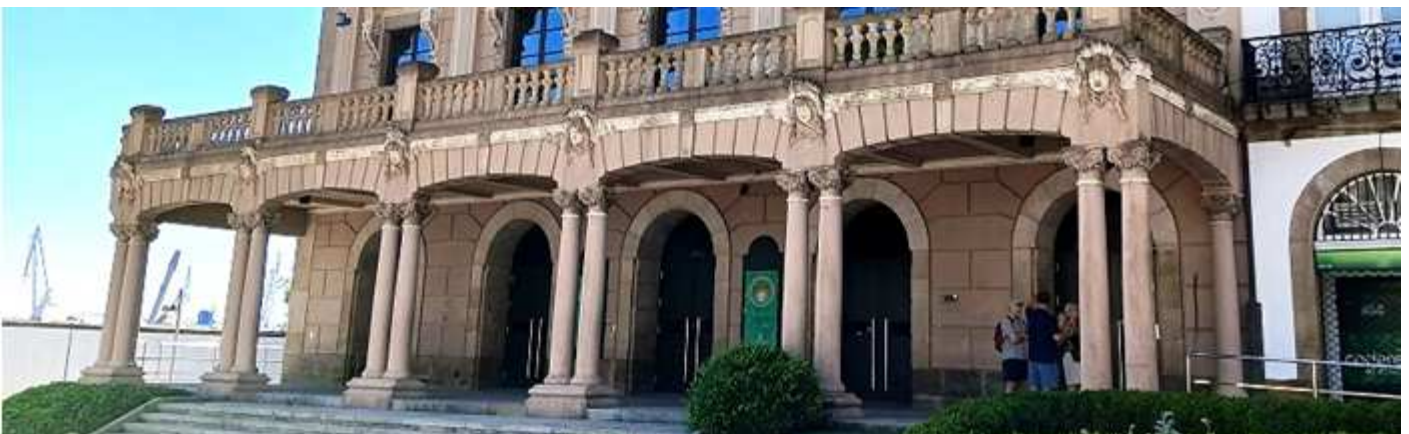
❶ Detalle el pórtico con sus columnas pareadas y los mascarones que ostentan encima de ellas.
