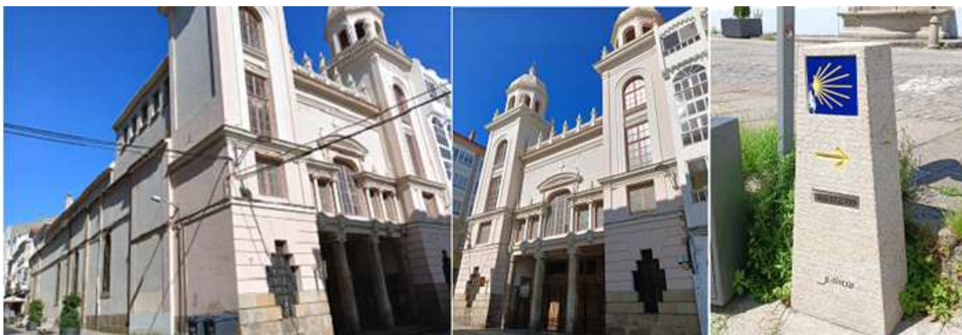
1 Templo construido en 1923 en estilo ecléctico. 2 Su fachada marcada por sus dos torres laterales, y el cuerpo central con atrio abierto adintelado y sobre este una galería con cinco ventanas con un friso sobre la centran de mayor tamaño y culmina con un alero con pináculos. 3 Calle de San Francisco con el hito que nos marca los 112,7 que hay hasta Santiago de Compostela
