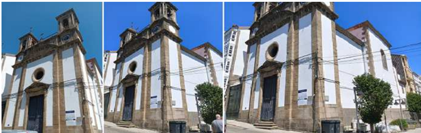
❶ Fachada de la Iglesia de Nuestra Señora de los Dolores con tres calles. Una puerta adintelada sobre ella un óculo con vidriera en la central. ❷ Encalada y con bloques de granito. A ambos lados las torres de planta cuadrada. ❸ Lateral del templo a la calle Dolores.
