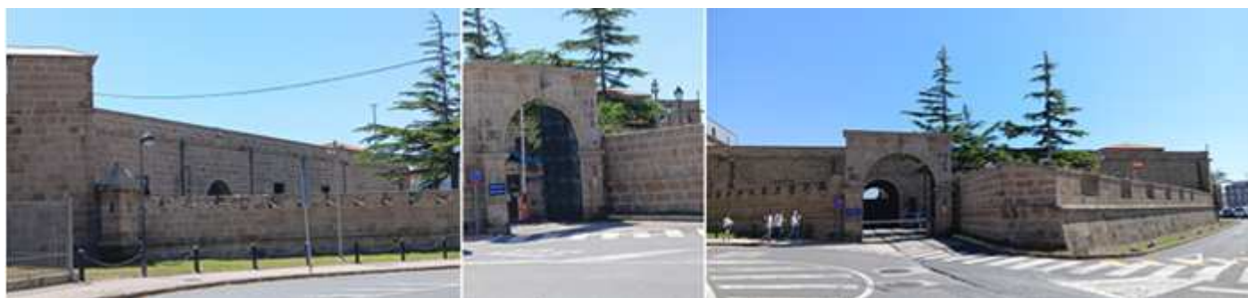
❶ Antiguo CIM Ferrol Centro de Instrucción de Marinería. ❷ Este antiguo cuartel se encuentra adosado a los 740m defensivos de La Cortina del Arsenal. Es un edificio neoclásico de la antigua Sala de Armas del Arsenal, fue construido con piedra de granito en 1759, es de planta rectangular. ❸ En esta parte posee sus murallas que dan a la ría. Albergó el Cuarte de Instrucción de Marinería, y hoy día cumple la Función de Alojamiento Logístico de la Marina para el personal destinado en Ferrol.
