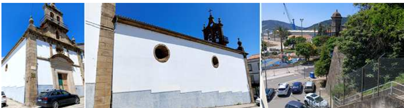
❶ Iglesia Nuestra. Sr a . del Socorro. ❷ Se construyó en el S.XVIII, en estilo neoclásico y con una sola nave con espadaña. Posee el Cristo de los Navegantes S. XVII y la Virgen del Socorro S. XVIII. ❸ Ángulo con una garita del Baluarte de San Juan.
