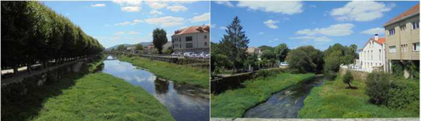
❶ Dos estampas del río Sar, aguas abajo con la pasarela al fondo. ❷ Y desde el otro lado del puente aguas arriba con la vegetación en las márgenes del cauce.
