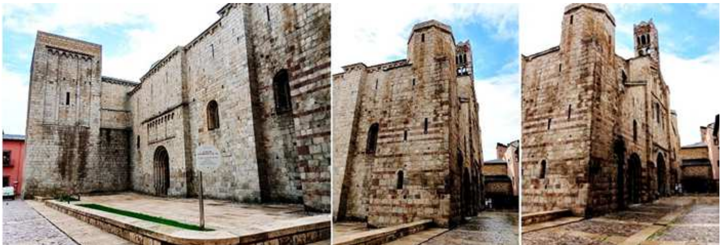
❶ Lateral del templo por su lado norte que da a la plaza de Oms, ayuntamiento y antigua iglesia de Santo Domingo. En la parte superior de esta fachada se abren finas ventanas de aspillera para la defensa. ❷ Torre de planta cuadrada que evoluciona a octogonal en el primer tramo de la nave. ❸ Y la fachada principal que da a este callejón, calle de Santa María.
