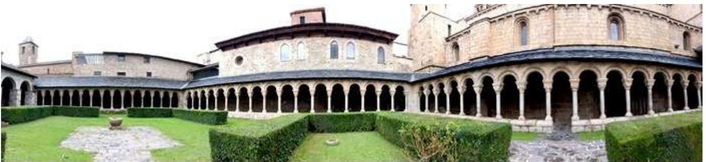
1 Panorámica con las tres pandas que poseen arcos y capiteles sobre sus columnas. La panda sur, la oeste y la norte (de izquierda a derecha).
