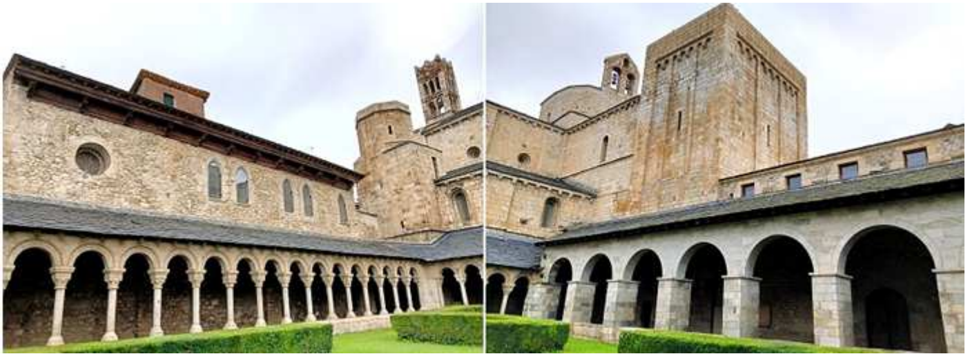
❶ Vista de la panda oeste, a punto de salir del claustro. ❷ Y la opuesta donde se aprecia la espadaña con tres vanos del cimborrio y la torre de San Justo. Esta galería se destruyó en 1603 con siete arcos rectos y desproporcionadas columnas.
