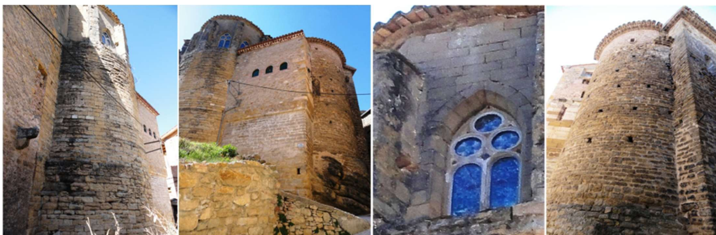
❶ Cabecera de San Vicente de gran altura compensando la pendiente del templo en esta parte. ❷ Esta parte muestra la inclinación de la calle San Vicente y las dos cabeceras. ❸ La cabecera central semicircular, está en su parte superior poligonal, abierta entre sus contrafuertes con tres ventanas góticas de arco apuntado que aloja otras dos dentro de la misma y con tres óculos sobre ellas con vidrieras. ❹ Cabecera de San Salvador (o la nave del Evangelio).
