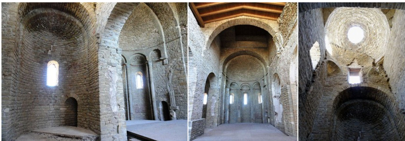
❶ Ábside de lado del Evangelio, abierto con una ventana.. ❷ Ábside central con cinco arcos adosados con columnas que llegan hasta el suelo con sendas ventanas en los tres centrales. ❸ Detalle de la cúpula sobre trompas de la nave del Evangelio. ❹ Detalle de la cúpula con linterna u sus trompas.
