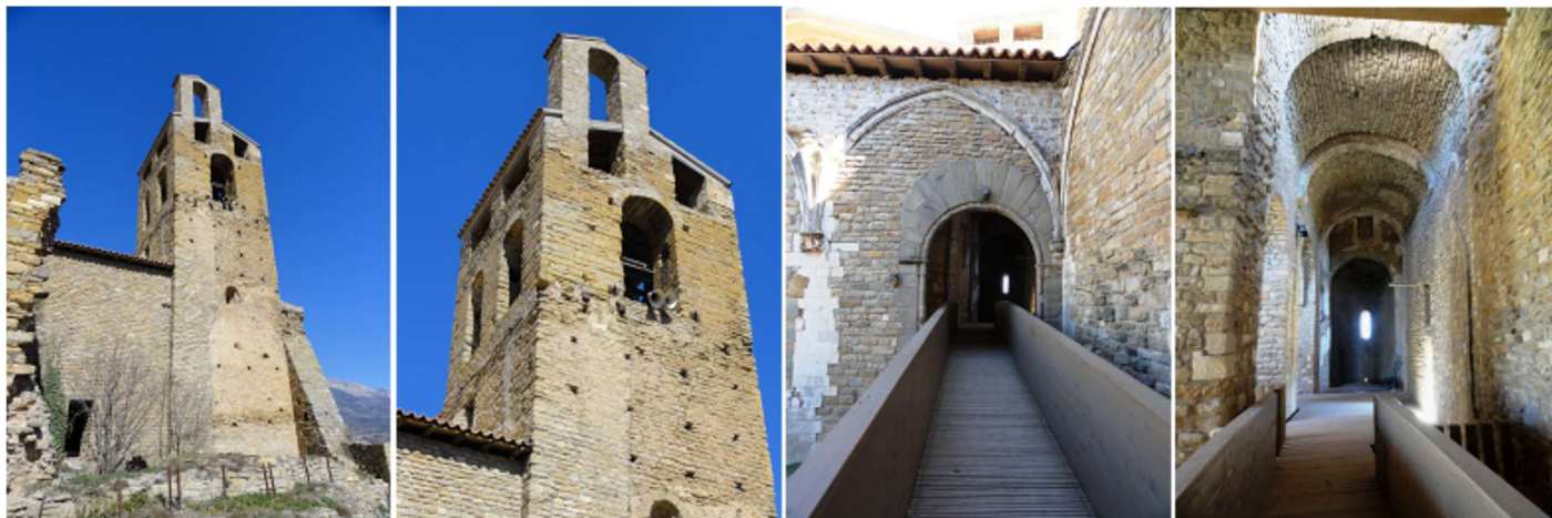
❶ La torre está sobre la nave de la Epístola. ❷ Otra imagen del campanario. ❸ Lateral del claustro que da acceso al templo. ❹ Nave lateral de la Epístola.
