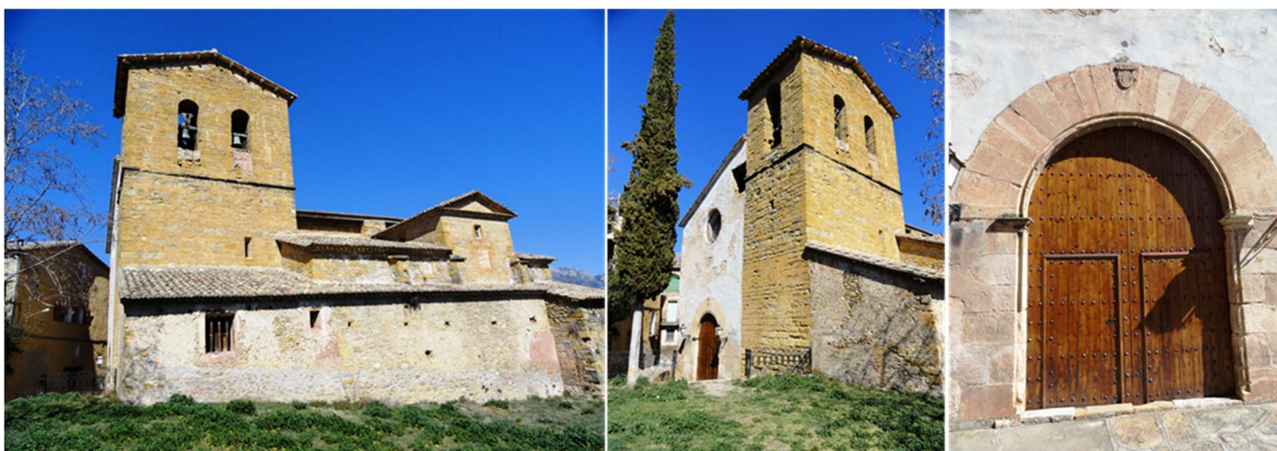
1 Fachada lateral orientada al sur. 2 El campanario, adosado a la iglesia de San Vicente, tiene marcas de cantero en el interior, lo que nos permite situarlo entre el final del románico o el inicio del gótico. 3 Puerta de acceso, de arco de medio punto dovelado
