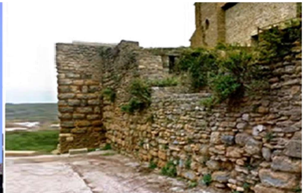
2 Y en la parte posterior de sus ábsides los restos de las murallas.
