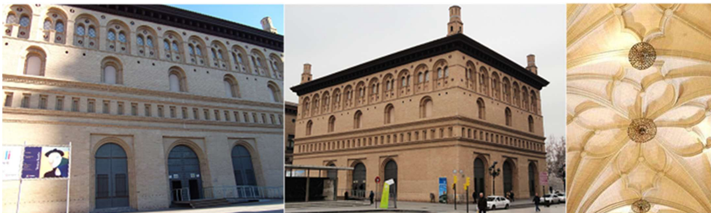
❶ En la fachada se aprecian unos medallones cerámicos policromados a base de retratos de diferentes personajes. ❷ De planta rectangular y abierta con puestas en sus cuatro lados. ❸ Detalle de los nervios y claves de sus bóvedas.
