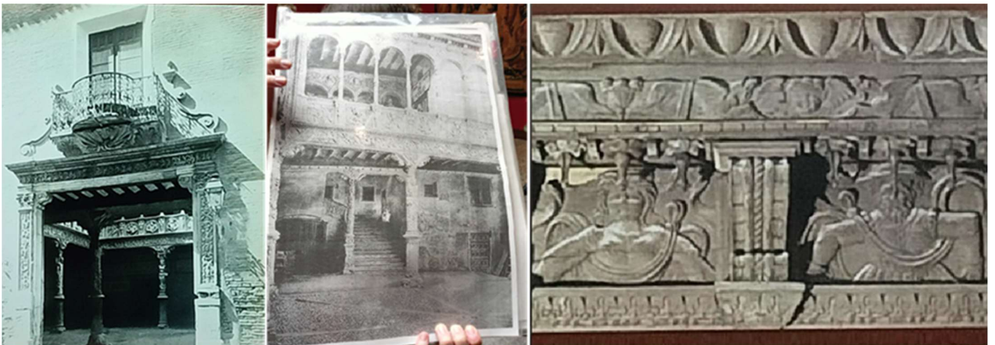
❶ Fachada del palacio Zaporta en la calle Nueva en el límite de la vieja Judería, construyó su casa en 1549 en una zona nueva, buena y cristiana, reuniendo varias fincas, con un amplio jardín y un total de 1,700m2. ❷ Otra imagen de esta magnífica mansión ❸ Los propietarios Sabina Santángel y Gabriel Zaporta están representados con vestimentas a la usanza de patricios romanos (moda de la época) en el alero del patio sobre la esquina de Marte.
