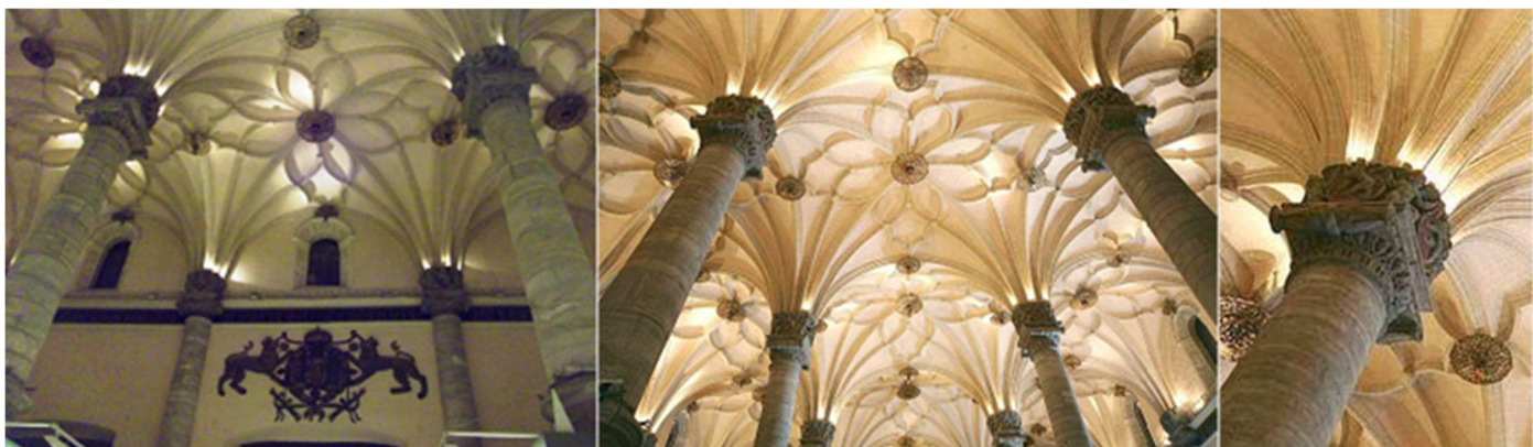
❶ Un detalle son las columnas laterales integradas en los muros. ❷ Bóvedas con las características renacentistas aragonesas. ❸ Columna cuyos nervios forman la imagen de una palmera, partiendo de su capitel.
