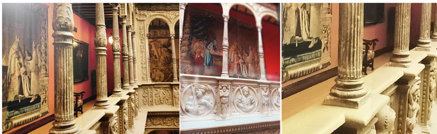
❶ Detalle lateral de la primera planta. ❷ Loas arquillos de medio punto sobre columnas torneadas, estriadas y anilladas. ❸ Parte inferior de las columnas estriadas con toro escocia y estilóbato.
