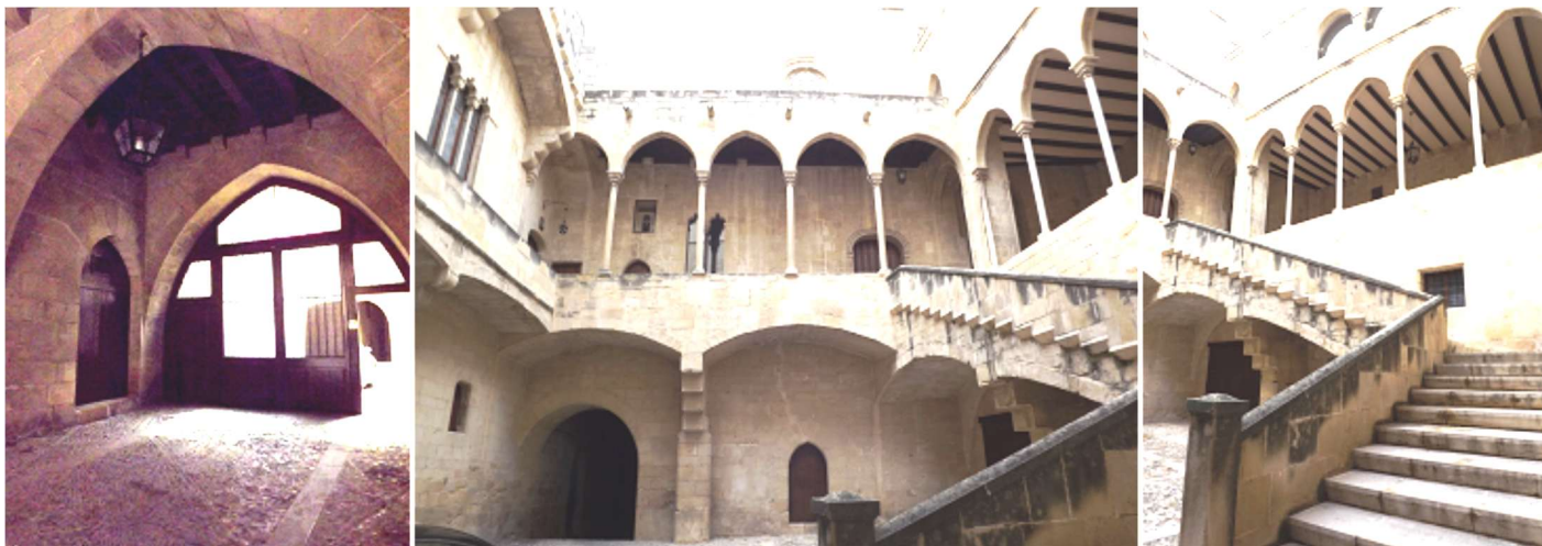
❶ Zaguán de entrada con dos arcos apuntados. ❷ Patio con una gran escalera y corredor del primer piso. ❸ Tras sus escaleras voladizas se accede a un corredor que da a tres lados del mismo patio.
