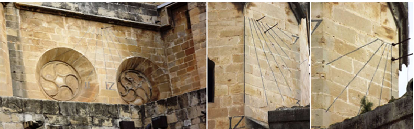
❶ En esta pared meridional se encuentran los relojes de Sol. ❷ Emplazamiento: en el muro del templo gótico de la catedral de Santa María, 2º tramo de la nave. Tipo: vertical, rectangular horizontal. Con los números y horas pintados. Traza: de las 8 a las 4 h. p.m. en números árabigos. Gnomon de varilla.
