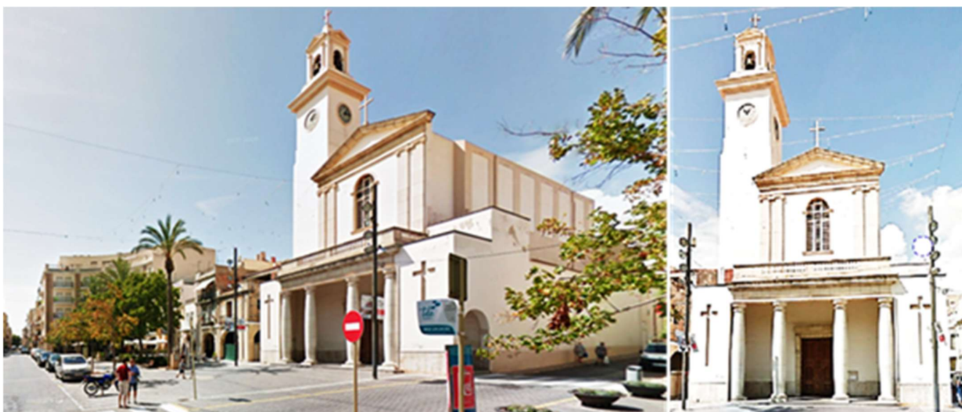
① El templo consta de una amplia nave central, flanqueada por unas de colaterales muy estrechas, a modo de capillas. ② La fachada presenta un atrio cubierto y cerrado por cuatro columnas con éntasis y capiteles toscanos., y su torre adosada a la izquierda.
