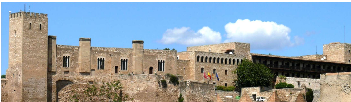
❸ Panorámica con la fachada sur del castillo donde se encuentran las salas con ventanas triforas. Y tres chimeneas ambas góticas. Esta parte del castillo junto con la necrópolis andalusí son las más antiguas.
