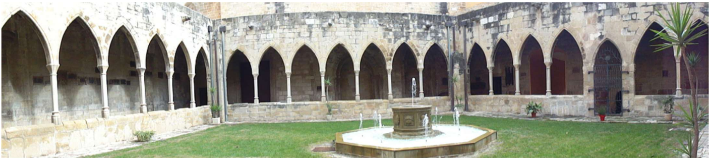
❶ Panorámica del claustro, en el lado derecho están los capiteles románicos.
