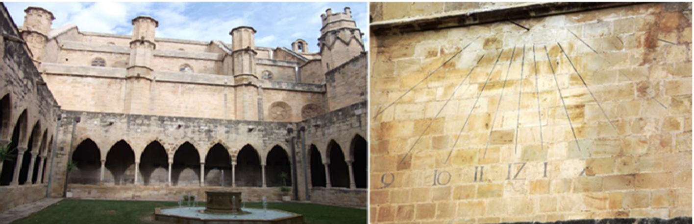
❶ En esta pared meridional se encuentran los relojes de Sol. ❷ Emplazamiento: en el muro del templo gótico de la catedral de Santa María, 2º tramo de la nave. Tipo: vertical, rectangular horizontal. Con los números y horas pintados. Traza: de las 8 a las 4 h. p.m. en números árabigos. Gnomon de varilla.
