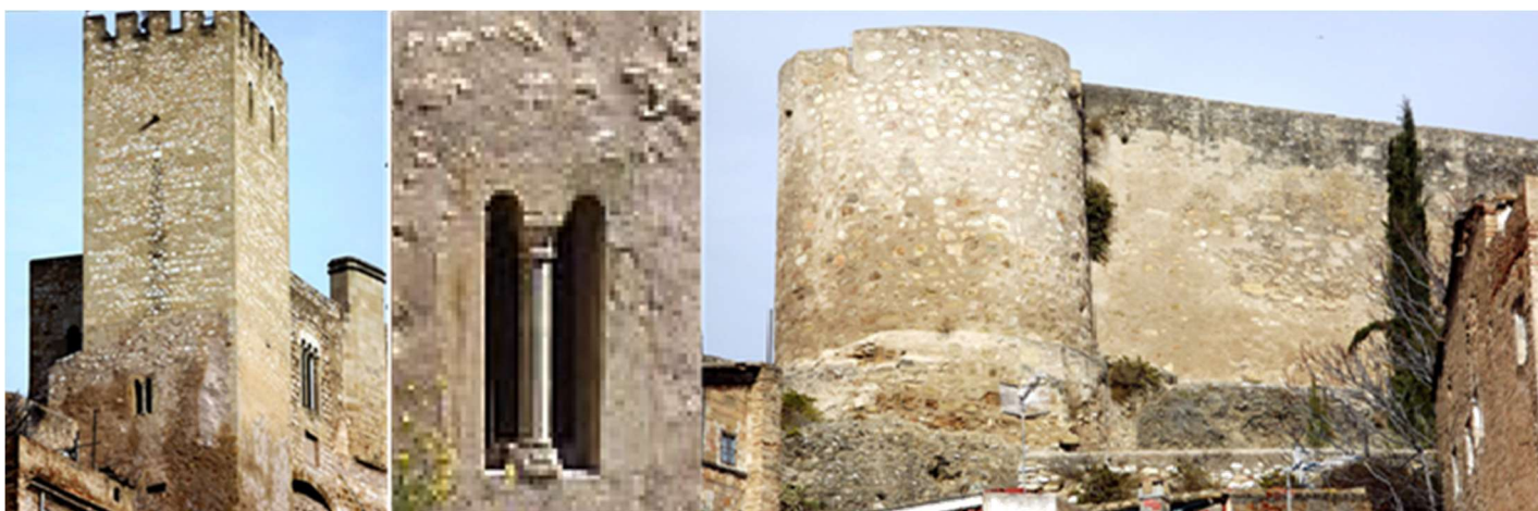
1 Torre del homenaje almenada y adosada a lo que era el palacio real. 2 Doble ventana con mainel. 3 Espolón redondo (la Torre Túbal o punta de diamante) de sus murallas sobre la ciudad.
