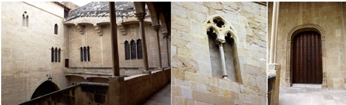
❶ Al fondo varias ventanas con arquería trilobulada. ❷ Otro ventana gótico sobre la fachada lateral izquierda. ❸ Puerta de arco rebajado con una arquivolta acanalada.
