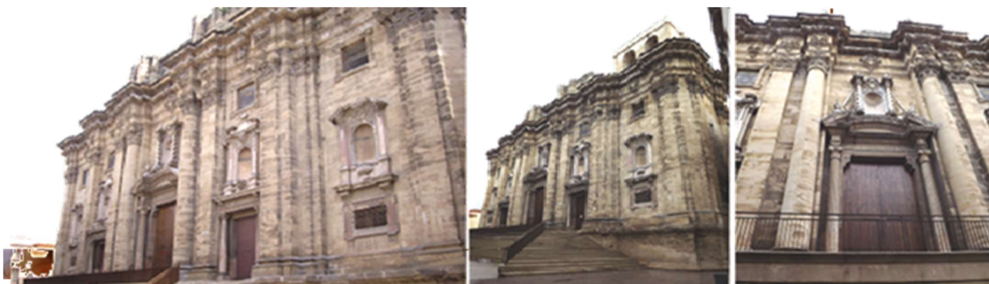
❶ Portada occidental levantada en el S. XVIII. Estructurada simétricamente en cinco cuerpos verticales ❷ Esta fachada cuenta con tres puertas sobre una zona elevada con escaleras en sus laterales para compensar el desnivel. ❸ Cuerpo central de la fachada.
