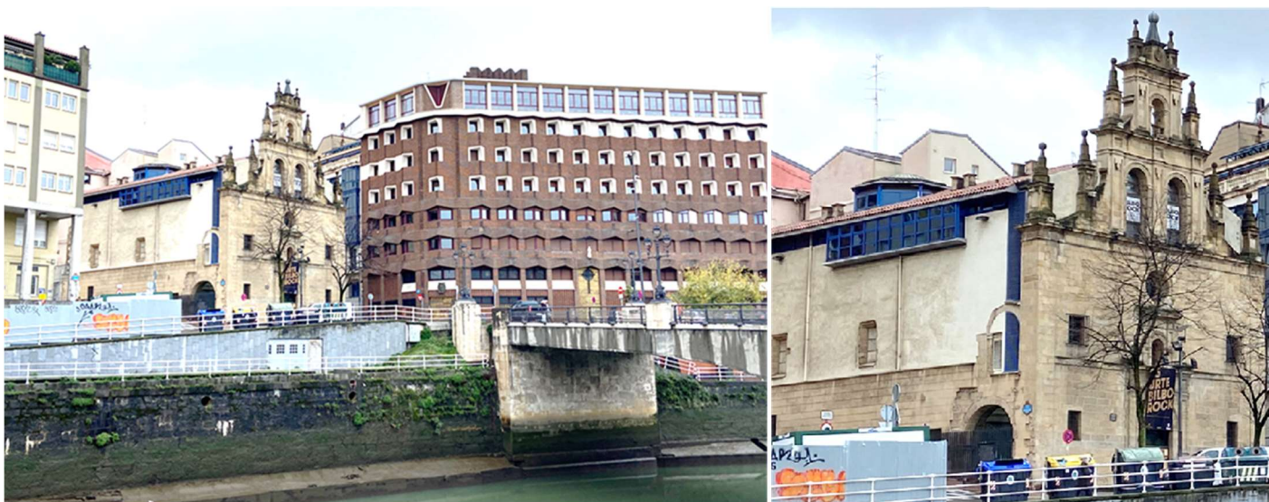
❶ Al finalizar el sitio carlista de Bilbao, el 2 de mayo de 1874, solo quedaba en funcionamiento el puente de San Antón. Ante esta situación se proyecta uno provisional sobre pilotes enfrente de la iglesia de La Merced. ❷ Convento e iglesia de La Merced. Tras afincarse en Bilbao en 1532 las mercedarias se trasladan en 1567 al lado izquierdo de la ría.
