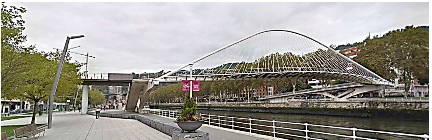
❶ El diseño consiste en un arco inclinado que une dos plataformas, con rampas de acceso y escaleras en ambas orillas
