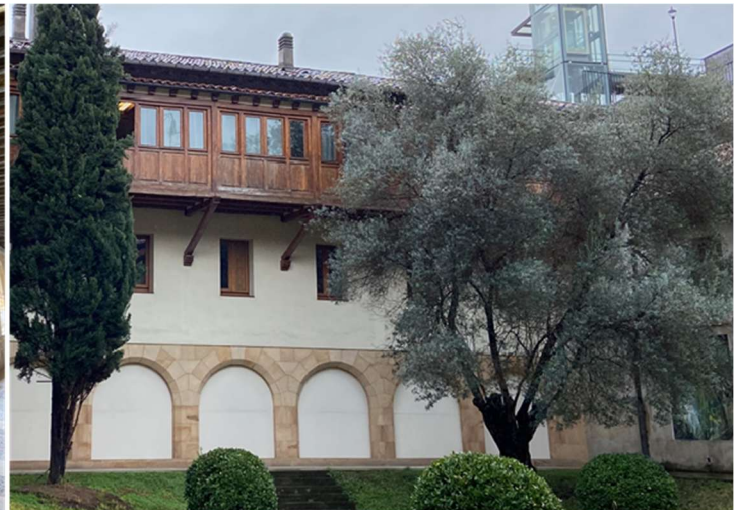
2 La otra panda poseen su arcos cegados, y detalle de sus galerías voladas.
