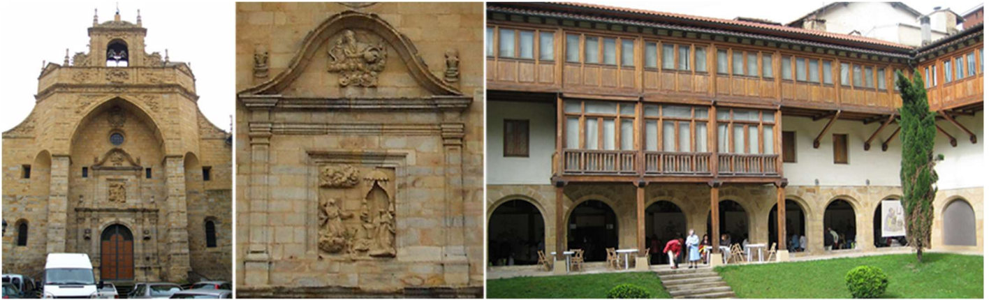
❶ Portada construida en 1554 con un gran arco que cobija su puerta de entrada y sobre el entablamento un relieve con frontis curvo. La espadaña se construyó en 1690. ❷ Relieve con la Anunciación de la Virgen. ❸ Imagen del claustro con tres plantas.
