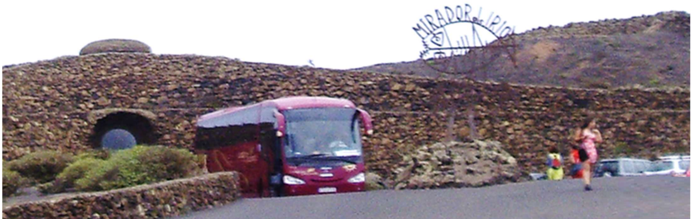
❶ Panorámica desde el aparcamiento que dispone con distintas construcciones con piedra seca. El edificio apenas es visible desde el exterior, al estar camuflado bajo una superficie de piedra que se mimetiza con el entorno.
