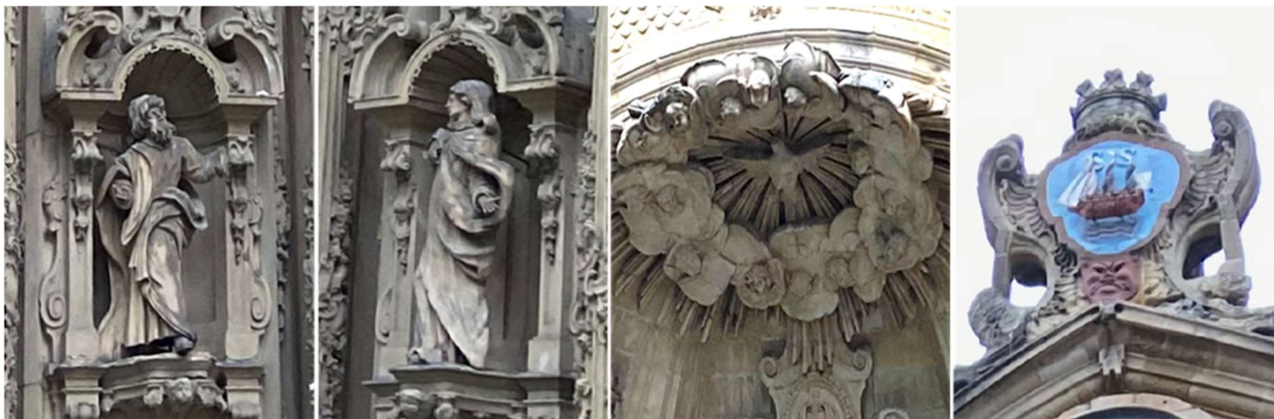
❶ Hornacina izquierda de la fachada. ❷ Y la ubicada en la parte opuesta. ❸ En la bóveda de horno de la fachada el Espíritu Santo rodeado de nubes. ❹ Coronando la fachada el escudo de la fachada
