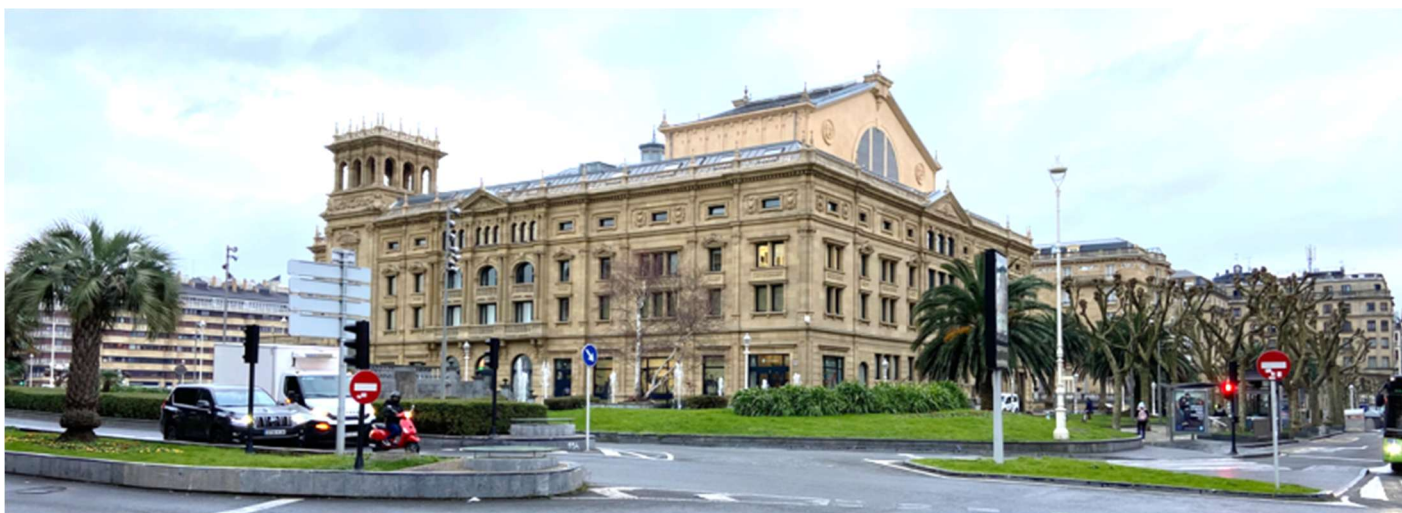
① Lateral con una de sus torres y la parte posterior del teatros desde la Avenida Reina Regente.
