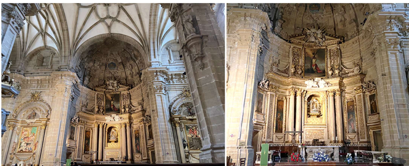
❶ Crucero y cabecera del templo con bóveda de crucería. ❷ Su cabecera semi circular cuyo retablo Mayor se adapta, consta de tres calles dos pisos con ático y banco, sus calles del primer piso separadas con dobles columnas y con la hornacina de la Virgen del Coro.
