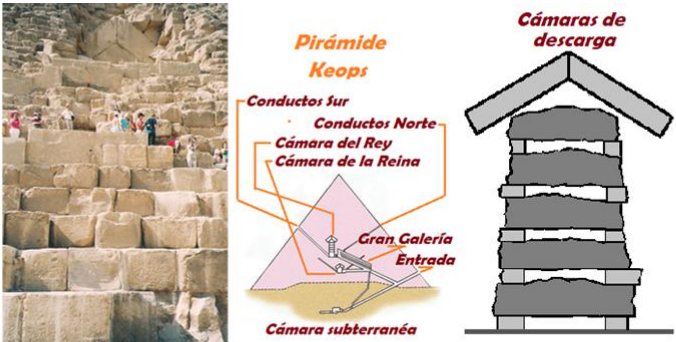
❶ El punto de la entrada. Detalle de las losas en cuña soportando una estructura. ❷ Croquis de la pirámide de Keops. ❸ Las cinco cámaras de descarga que hay sobre la cámara del rey.
