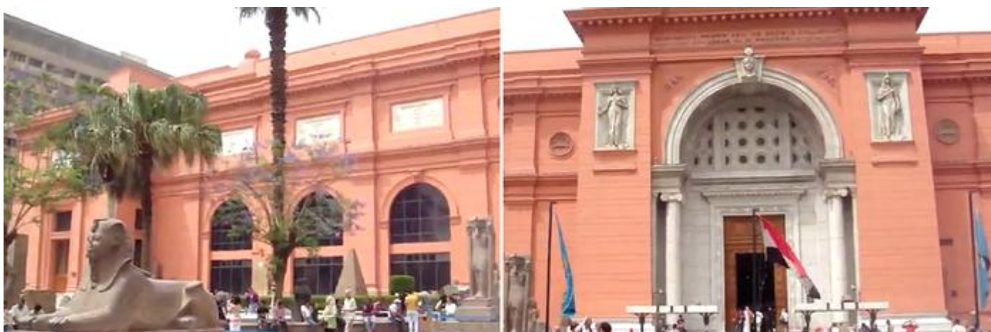
① Edificio con una fachada de estilo colonial. ② Su puerta principal adelantada sobre un arco de medio punto con columnas.
