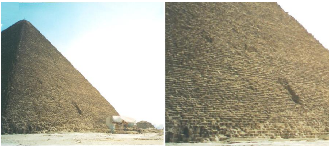
❶ Lateral con su puerta principal y la instalación de la barca sagrada y detrás las pirámides de las reinas. ❷ Esta entrada está a una altura de más de 10m.
