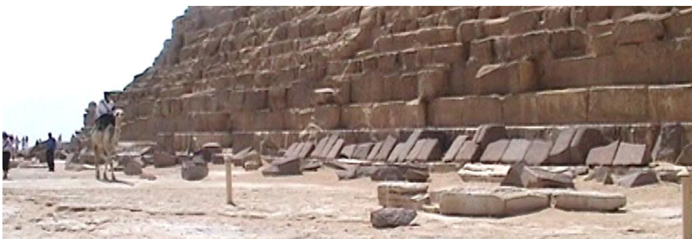
❷ Y en la base de la pirámide aún se conservan algunos bloques de granito rojo, que disponía recorriendo el perímetro.
