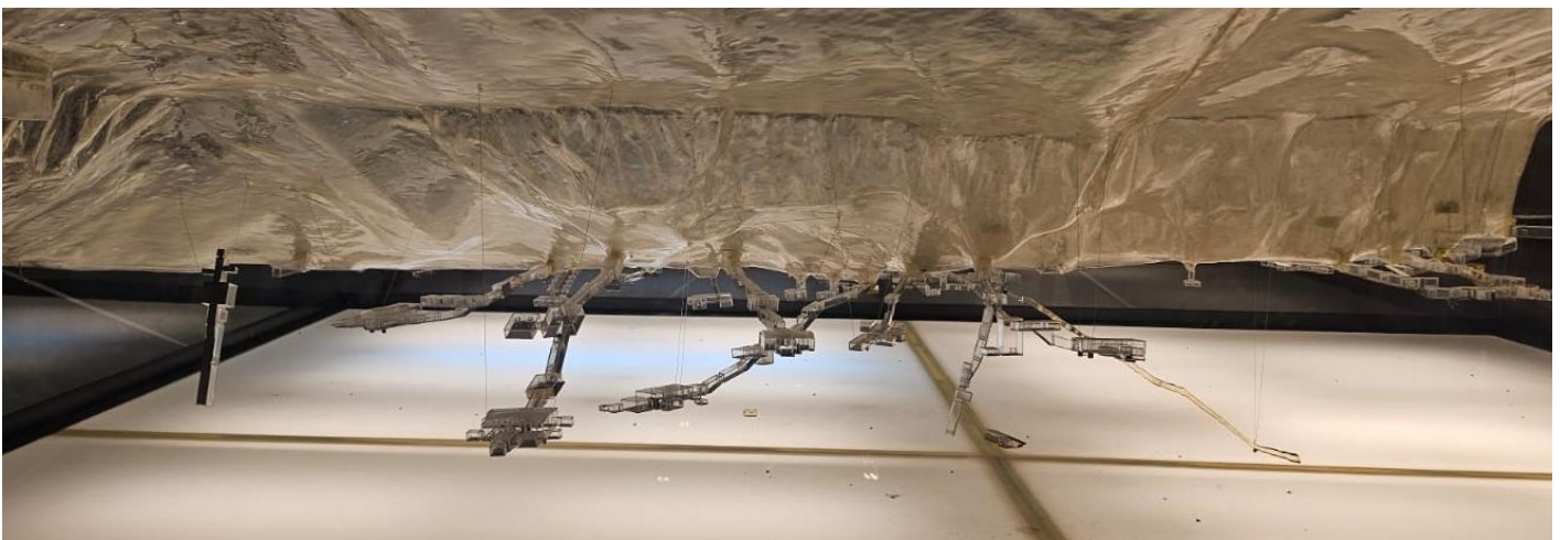
❸ Y que se puede apreciar con detalle los conductos y cámaras que posee las tumbas además de su profundidad..
