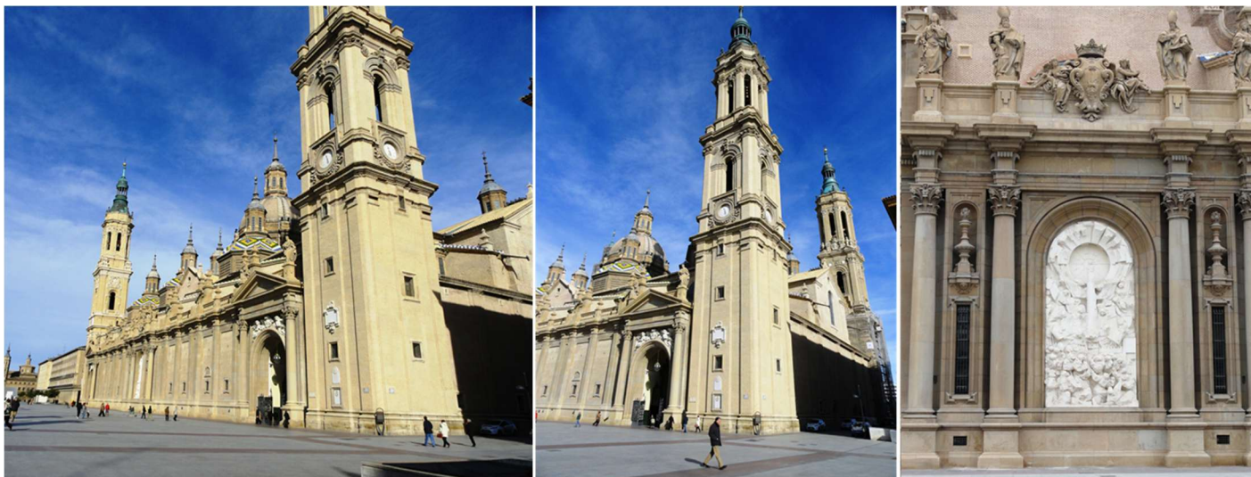
❶ Torre con la puerta sur. ❷ Y la torre de este ángulo. Esta es la primera que se construyó en el S. XVIII bajo la dirección del maestro aragonés Gaspar Serrano. ❸ Retablo de piedra blanca con la Venida de la Virgen del Pilar de Pablo Serrano.
