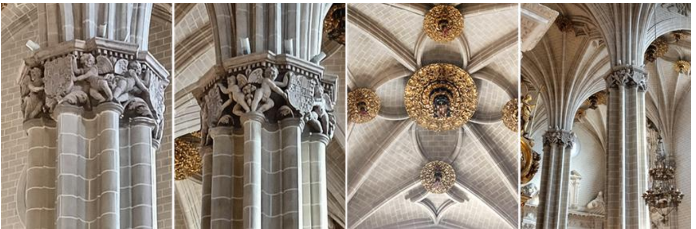
❶ Otras columnas emplean en la decoración escudos heráldicos con angelitos que los sostienen. S. XVI. ❷ Estos pilares blasonados son de la ampliación de don Hernando de Aragón (1539-1575), y se terminó la ampliación del templo. ❸ Detalle de una bóveda estrellada que porta una decoración dorada de gran tamaño con sus claves doradas. ❹ Estas bóvedas están formadas por nervaduras (arcos que se cruzan) que soportan los paños entre ellas y distribuyen las cargas hacia los pilares.
