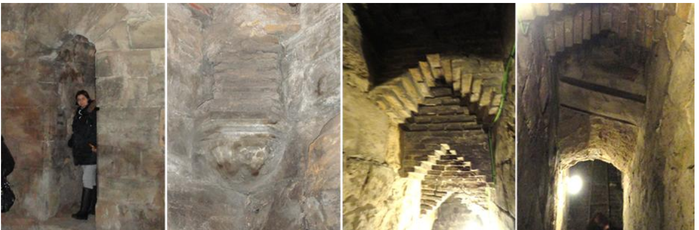
❶ Estrecha puerta de medio punto algo apuntado de arista viva. ❷ Ménsula en uno de sus ángulos. ❸ Bovedillas de ladrillo por aproximación de hiladas. Y sobre los muros de piedra. ❹ En una parte se muestra la alteración para el paso.
