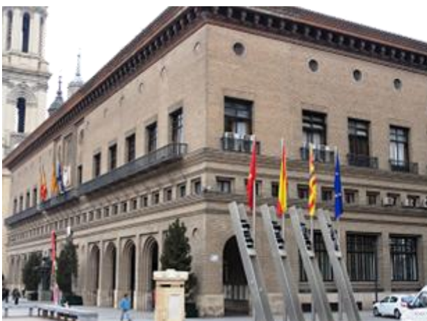
1 Perspectiva del edificio junto a la Lonja.
