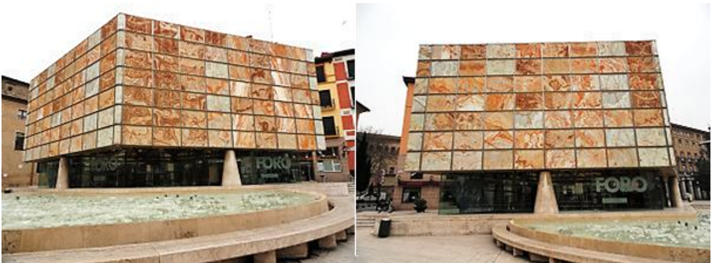
❶ El museo del foro, está ubicado bajo el subsuelo de la Plaza de la Seo. ❷ Y el acceso se realiza a través de un prisma de placas de ónice iraní.
