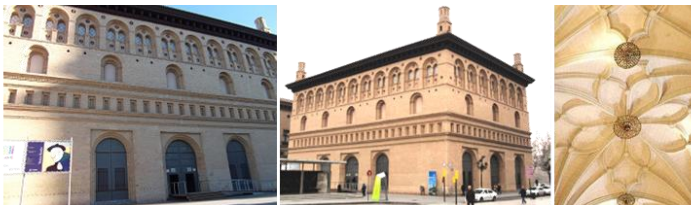
❶ En la fachada se aprecian unos medallones cerámicos policromados a base de retratos de diferentes personajes. ❷ De planta rectangular y abierta con puestas en sus cuatro lados. ❸ Detalle de los nervios y claves de sus bóvedas.
