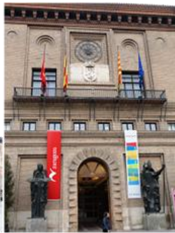
2 Puerta principal de acceso.
