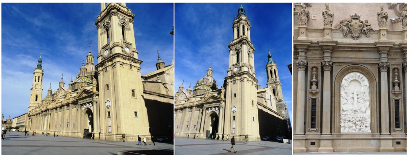
❶ Torre con la puerta sur. ❷ Y la torre de este ángulo. Esta es la primera que se construyó en el S. XVIII bajo la dirección del maestro aragonés Gaspar Serrano. ❸ Retablo de piedra blanca con la Venida de la Virgen del Pilar de Pablo Serrano.
