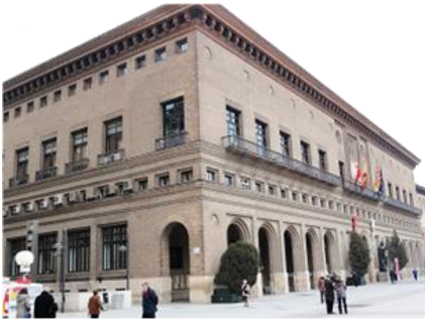
1 Fachada típicamente aragonesa.
