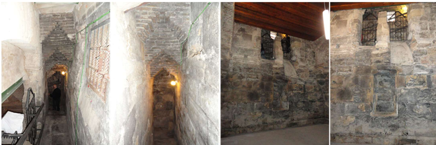
❶ Descendemos a la cripta por un estrecho pasillo y escaleras realizada intramural. ❷ Cubierta mediante bovedillas enjardadas de ladrillo. ❸ Lo primero que llama la atención son las dos ventanas exteriores que posee en el muro norte y que se comunican a través del pasillo con las dos que hay en la cripta con derrame inferior, por donde introducirán el carbón para la calefacción de la catedral. ❹ Detalle de esta misma y de una hornacina bajo los mismos vanos.
