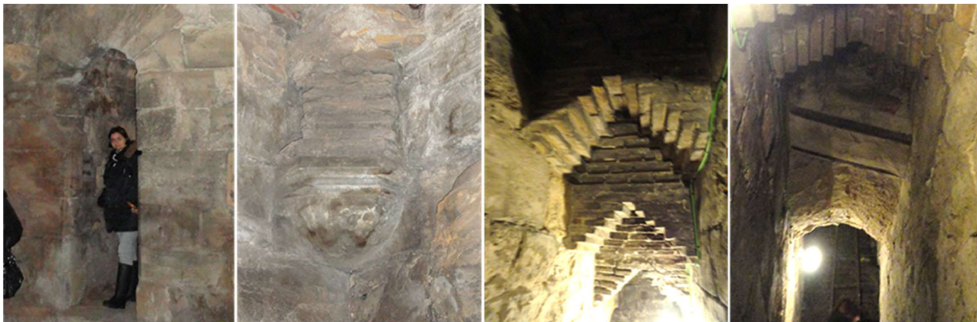
1 Estrecha puerta de medio punto algo apuntado de arista viva. 2 Ménsula en uno de sus ángulos. 3 Bovedillas de ladrillo por aproximación de hiladas. Y sobre los muros de piedra. 4 En una parte se muestra la alteración para el paso.
