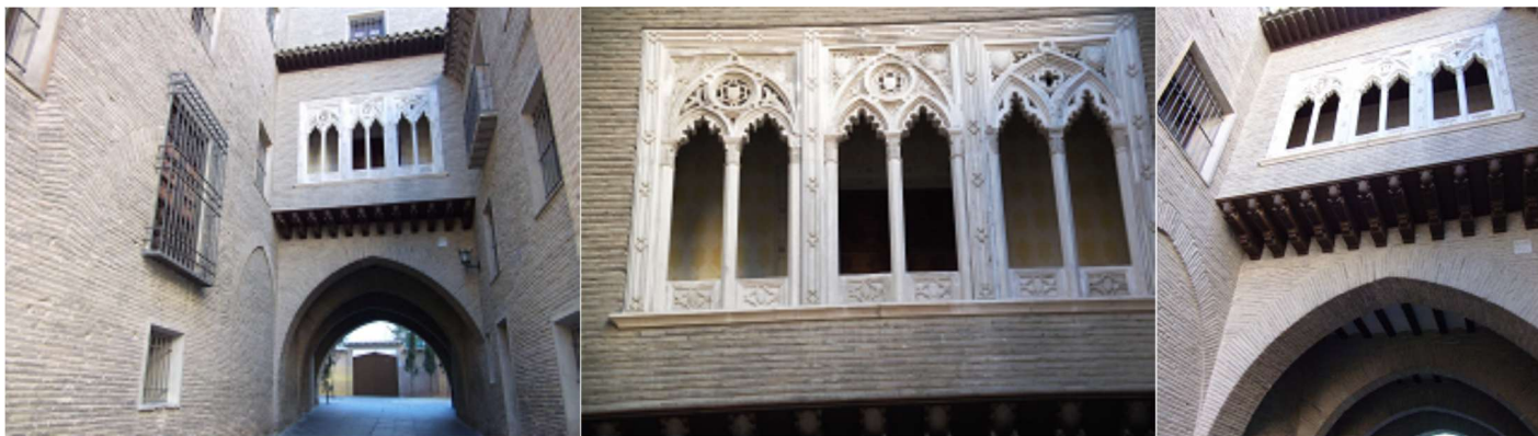
Preciosa construcción en ladrillo, destacando el mirador con ventanales. Con tres arcos ajimezados de tracería plateresco mudéjar. Galería que da a la plaza de San Bruno.
