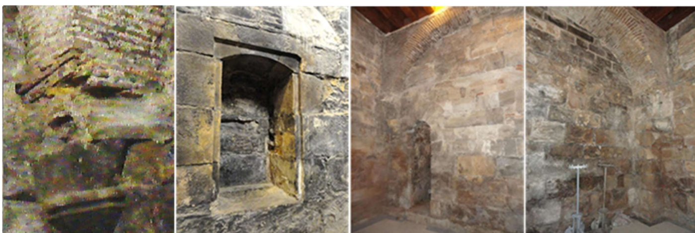
❶ Otra ménsula donde descansa uno de los arcos de ladrillo. ❷ Hornacina bajo las ventanas. ❸ Ángulo con otra ménsula distinta.
