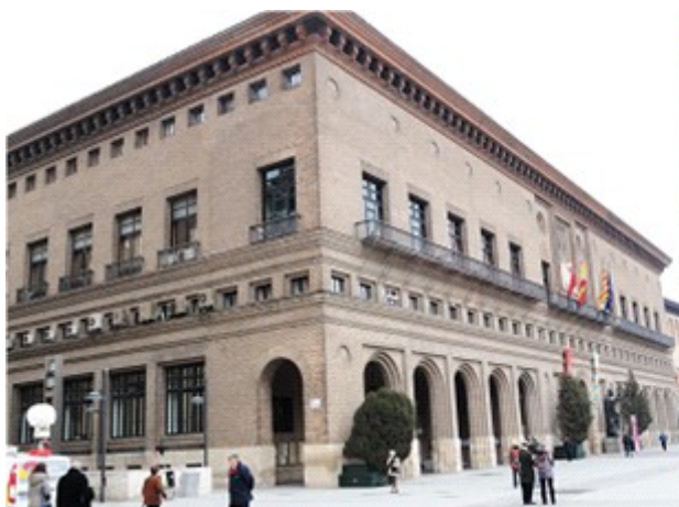
① Fachada típicamente aragonesa
