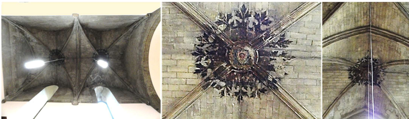
❶ Bóveda de crucería simple de la nave y separada por un arco fajón apuntado, compuesta por dos tramos. Cullos ventanales abiertos guardan simetría con cada tramo. Los finos nervios parten de ménsulas laterales. ❷ En la decorada clave ostenta el escudo del arzobispo Lope Fernández de Luna. ❸ Segundo tramo junto al arco fajón y el presbiterio.
