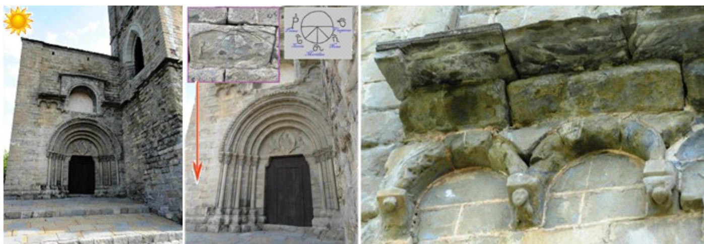
❶ Adosada a su puerta en este lado epistolar esta su torre del S. XV. La torre de planta rectangular de cuatro cuerpos. ❷ Reloj de Sol. Tipo: Canónico horizontal, rectangular. Con los tramos de horas excavados. Orientación al mediodía. Traza: con la Prima, Tertia, Meridies, Nona y Vísperas. Gnomon de varilla inexistente. Estado: se han desprendido algunas capas de la piedra. ❸ La portada dispone de un tejazar abierto con un arco posiblemente abierto y realizado en época posterior, el tejazar posee unas arcuaciones ciegas son ménsulas con motivos geométricos y otros.
