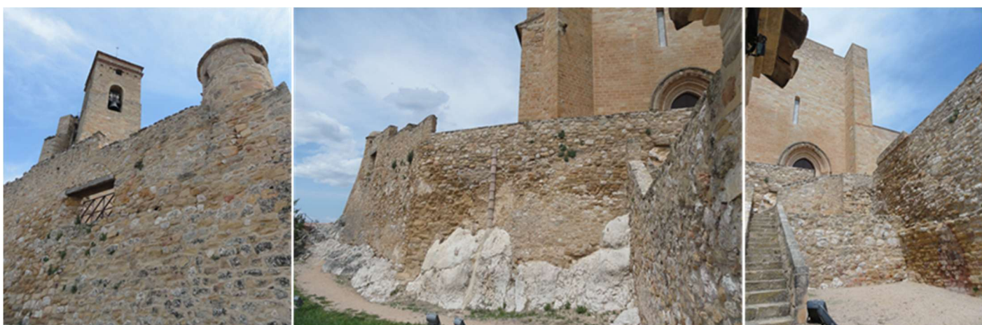
❶ En los extremos este y oeste se observan los torreones de vigilancia de planta circular perforados por saeteras adaptados para las armas del siglo XIX. ❷ Los muros sobre la roca viva junto a su entrada. ❸ Acceso hacia la iglesia
