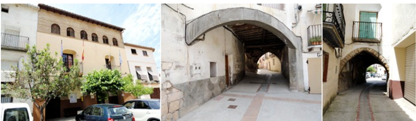
❶ Ayuntamiento de tres plantas y galería con arquillos. ❷ Pasadizo en la calle de la Iglesia con la Plaza Mayor. ❸ Y la parte posterior del mismo.
