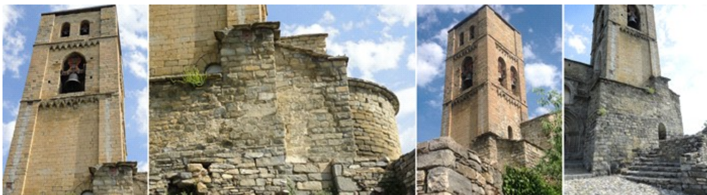
❶ Su torre abierta en el tercer cuerpo con ventanas apuntadas. Con uno o dos vanos por cara, con arquillos trilobulados junto a las impostas. ❷ Construcción de la abadía junto a la torre y el ábside. ❸ En esta parte inferior de la torre posee una puerta.
