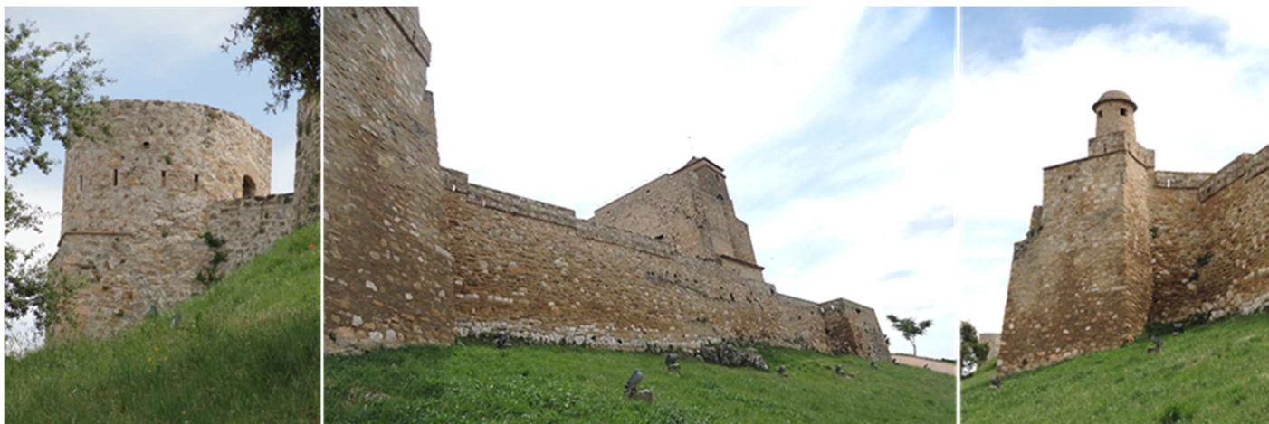
❶ Cubo con los restos de su torre. ❷ Lateral de las murallas abierto en su parte superior con los vanos para los fusileros. ❸ Baluarte de formato rectangular que aloja una garita.
