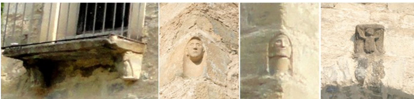
❶ Bajo el balcón se encuentran los capiteles. ❷ Carita en el ángulo izquierdo del edificio a la altura del balcón. ❸ Y la que está en la parte derecha. ❹ Ángel que nos muestra con sus manos alzadas la palmas, y que esta sobre el arco izquierdo de la casa consistorial. Fotos: Javier Torres
