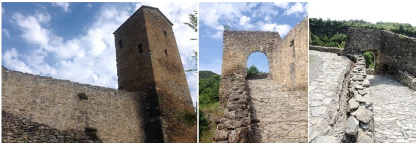
❶ Lienzo de las murallas y la Torre de la Cárcel. ❷ Rampa con la puerta de entrada. ❸ Parte posterior del arco de entrada desde la terraza amplia de la torre a sus pies.
