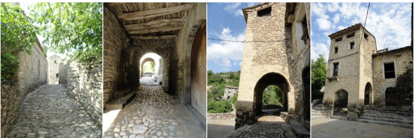
❶ Una de las calles paralelas al barranco. ❷ Pasadizo de varias casas. ❸ Lateral de la Casa Consistorial que posee un porche abierto en su primera planta. ❹ La plaza con el edificio del Ayuntamiento. Montañana se administró como municipio propio desde 1830 hasta 1956, que paso a depender de Puente de Montañana.
