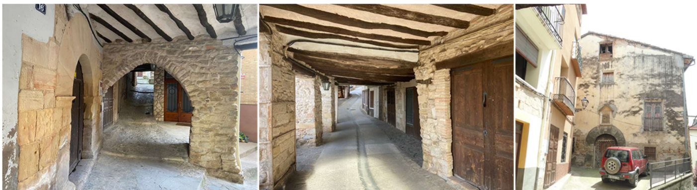
❶ Pasaje con arcos apuntados y adintelados de distintas anchuras ❷ Otro tramo de pasaje. ❸ Casa de los Cambra con una puerta de medio punto con dovelas lisas y que sobre su arco posee el escudo de armas, es de tres plantas más la solana.
