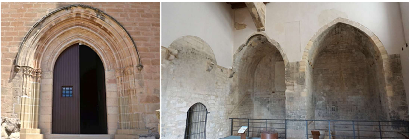
❶ Su puerta orientada al mediodía compuesta por un arco apuntado con dos arquivoltas baquetonadas, la interior sobre jambas rectas y la exterior sobre capitel corrido decorado con motivos vegetales. Y cubierta con un guardapolvo. ❷ Lateral de la Epístola con dos capillas abiertas con arcos apuntados. Y a la izquierda la puerta de acceso a la torre.
