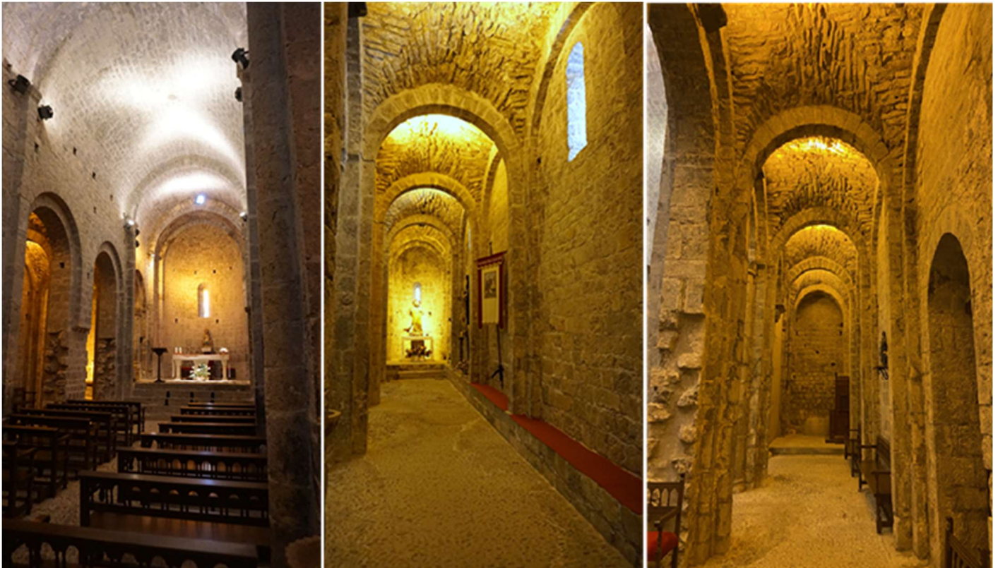
❶ Nave central con cubierta de bóveda de cañón y la cabecera al fondo con una ventana de derrame interior. ❷ Nave y ábside epistolar, con el Sagrado Corazón de Jesús y un Santo Cristo crucificado a su derecha, en su cabecera. ❸ Lateral del Evangelio desde la cabecera a los pies. Una puerta lateral de esta nave comunica con el claustro desaparecido en parte. Con arcos de arista viva que sostienen las bóvedas de arista.
