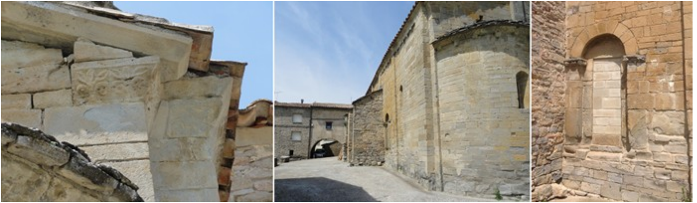
❶ Detalle decoración sobre el ángulo del presbiterio. ❷ Los contrafuertes del lado epistolar. ❸ Portada con una arquivolta dovelada sin decoración y descansan sobre jambas con un ábaco que en sus ángulos poseen cabezas de pájaro y figuritas humanas. Las jambas interiores sostienen un tímpano con una cruz griega y motivos alegóricos (una cruz trifoliada dentro de dos círculos a la izquierda y un dragón a la derecha ambas en la parte inferior), y la inscripción PETRUS sobre el arco y MAR sobre el brazo derecho horizontal.
