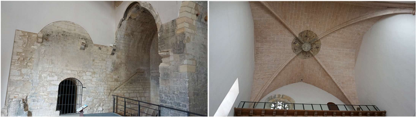
❶ El acceso a la torre y una de las capillas laterales. En ellas se puede observar el subsuelo donde las excavaciones han sacado los restos del anterior templo. ❷ Espacio del muro sur donde dispone de un rosetón con tracería gótica, y un coro elevado
