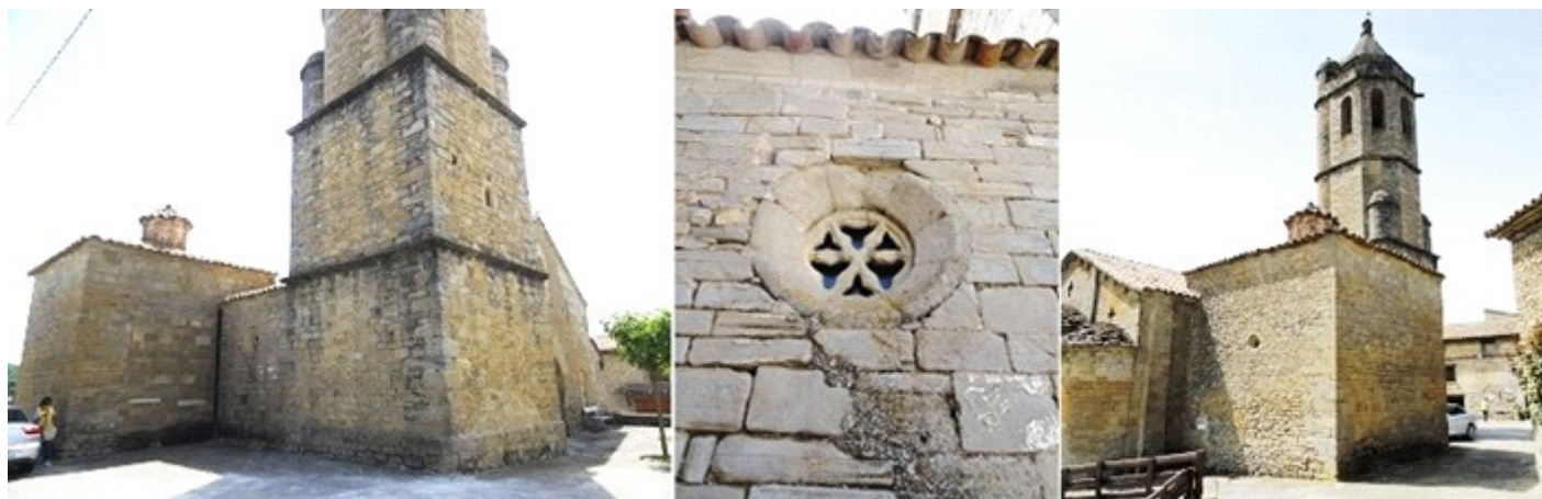
❶ Lateral del Evangelio con la capilla barroca con su linterna. ❷ Óculo en este lado exterior de la nave. Que corresponde a la capilla gótica con la pila bautismal. ❸ Exterior de la capilla.
