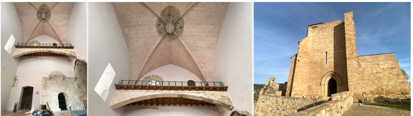
❺ Pies del templo. ❻ Sobre un arco rebajado el coro elevado. Ⓣ En el primer tramo del muro este se encuentra su puerta y sobre ella una amplia aspillera. A la derecha están las ruinas que faltan. A finales del S. XIX fue empleada como pabellón militar.
