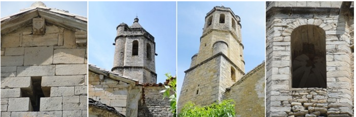
❶ Ventana cruciforme en el presbiterio central, y lo mismo ocurre en las otras dos naves laterales. ❷ En el exterior de los tres cuerpos octogonales dispone de una escalera de caracol. ❸ La torre de planta cuadra y octogonal, posee tres campanas de los años 1613, 1726 y 1849. ❹ Detalle de uno de los ventanales del campanario.
