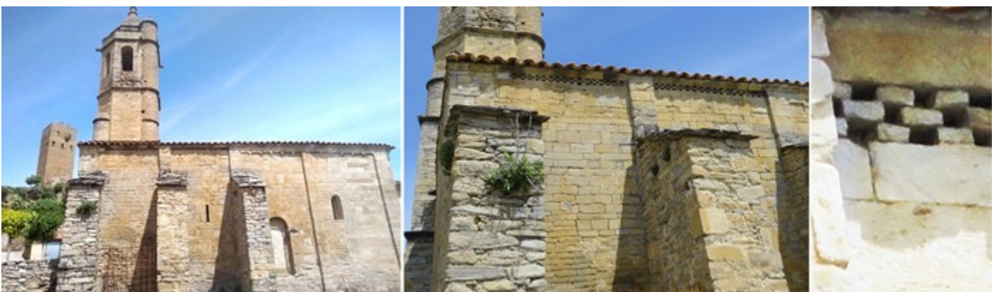
❶ Lado exterior epistolar. ❷ Los tres primeros tramos posee potentes contrafuertes. ❸ Detalle decorativo bajo el alero que semeja un taqueado.
