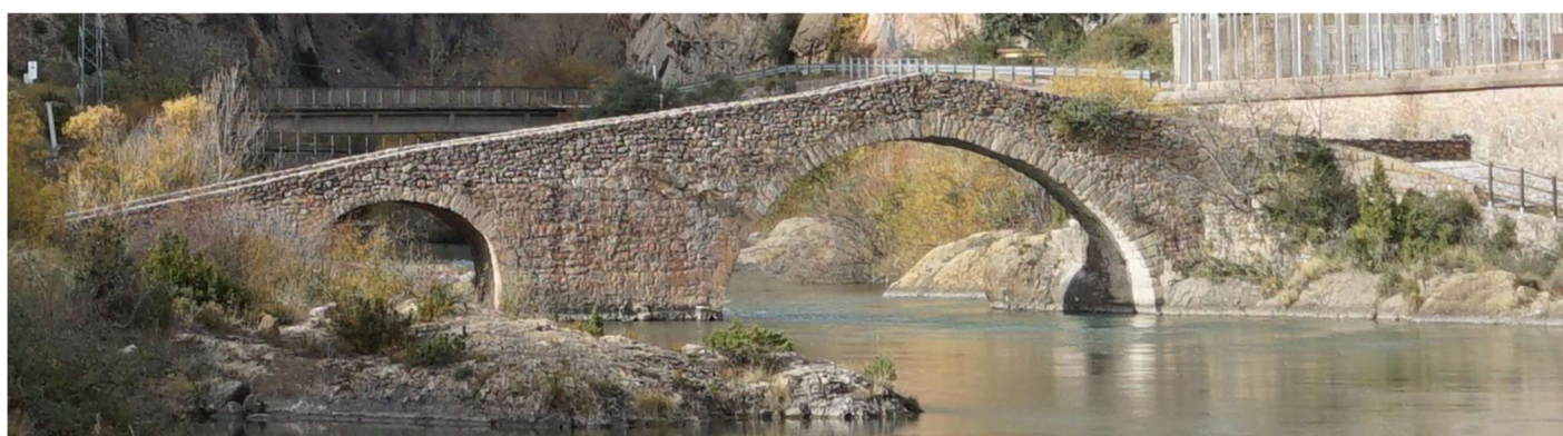
❶ Puente con lomo de asno, con tres arcadas que van en reducción de sus vanos de derecha a izquierda. Tiene tres arcos + rebajados. Se estima que dado servía para acceder al castillo de Sopeira y al Monasterio de Alaón podría datarse en el S. IX, aunque ha tenido modificaciones. Y la posibilidad de que originalmente tuviera dos arcos más.
