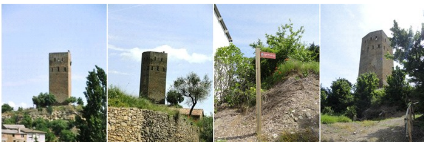
❶ Esta soberbia torre albarrana exenta de la muralla presenta en su exterior forma pentagonal y cuadrada al interior. ❷ Esta presumiblemente sea los restos de la muralla por su ubicación respecto al cartel informativo. ❸ Tras dejar el coche al lado tomamos esta señal con una rampa. ❹ Y en unos metros hemos coronado la loma.
