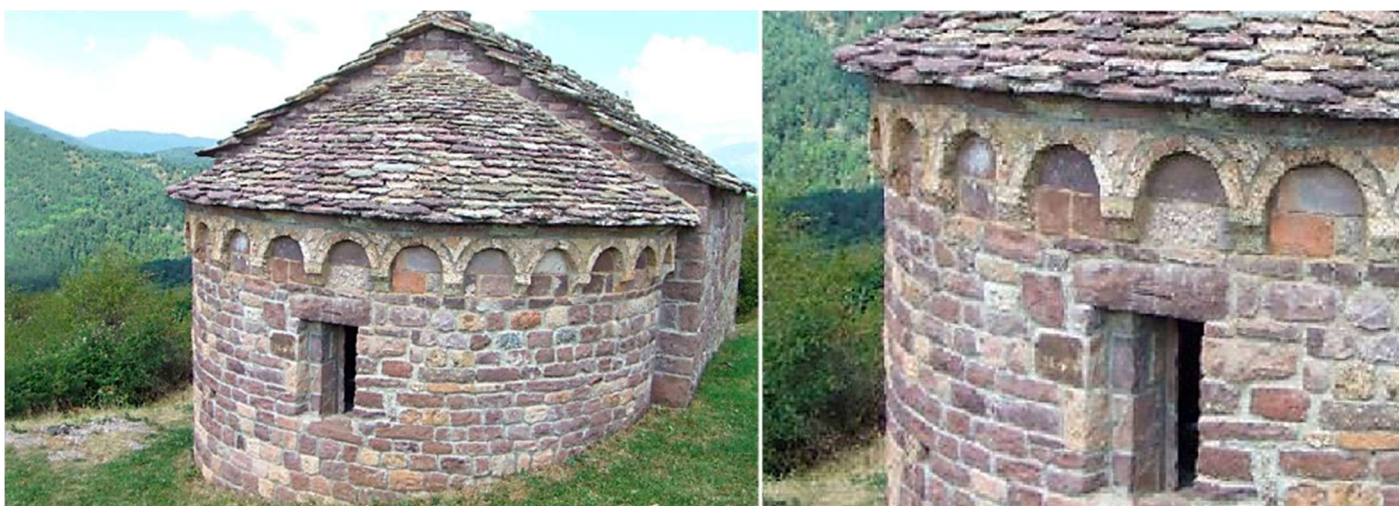
❶ Su cabecera con arcuaciones de estilo lombardo. Y sus cubiertas con lajas de piedra. ❷ Posee esta amplia ventana que en su interior se convierte en aspillera con gran derrame. Templo que fue ampliado S. XIV-XV y restaurado recientemente. ❸ Fotos Mar García -Herraiz.
