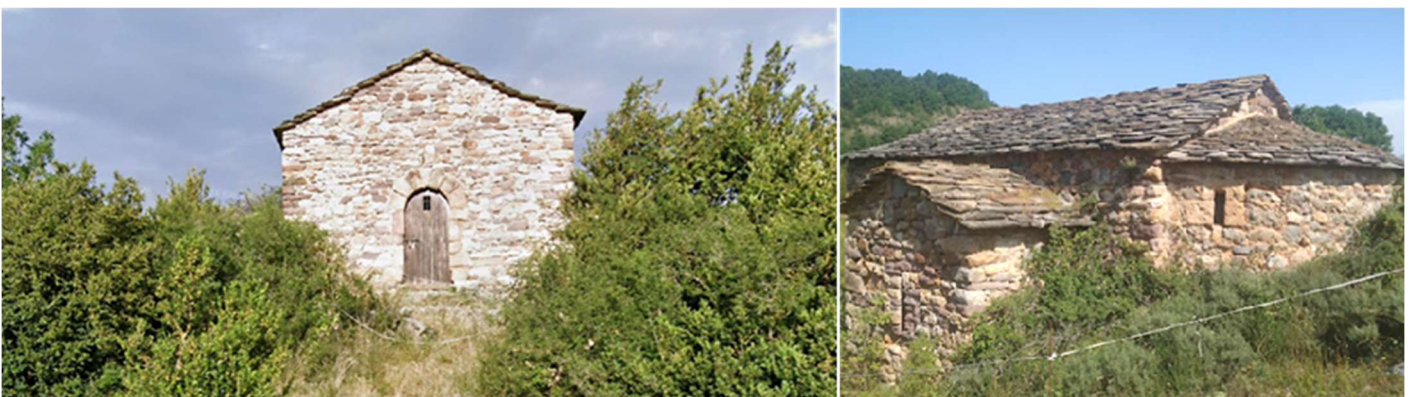
① Hastial con su puerta. ② Lateral sur del templo.
