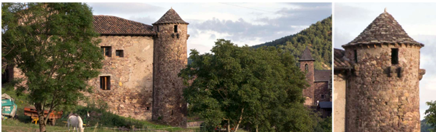
① Su casa de planta cuadrada y modificada en los S. XVIII o principios del XIX no queda nada de su estado original. A su derecha la torre de cuatro pisos de planta circular. ② Parte superior de su torre con forma cónica y que en su parte superior conserva las
