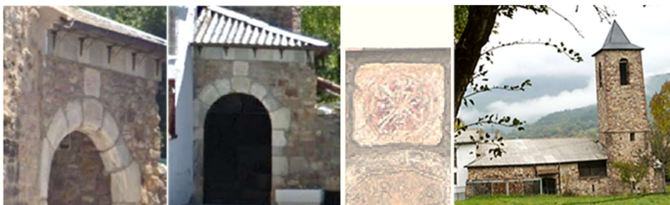
❶ Su pórtico con un arco de medio con dovelas irregulares, en el cual tiene una inscripción de 1836 (de alguna de sus reformas). ❷ Sobre el arco del pórtico posee un crismón, previsiblemente de su anterior templo. ❸ Crismón trinitario con doble aro, el exterior con puntas formando un ziz-zag con seis brazos patados, más dos los horizontales que son más cortos. La P sobre el superior con una pestaña a sus pies, la S sobre el palo inferior invertida y en la parte inferior del palo dos tildes, con A a Alfa, y Ω ω Omega pinjantes en los oblicuos. En el fondo conserva una pigmentación roja de su policromía. ❹ Lateral exterior del lado del Evangelio. Foto, Oficina Turismo.
