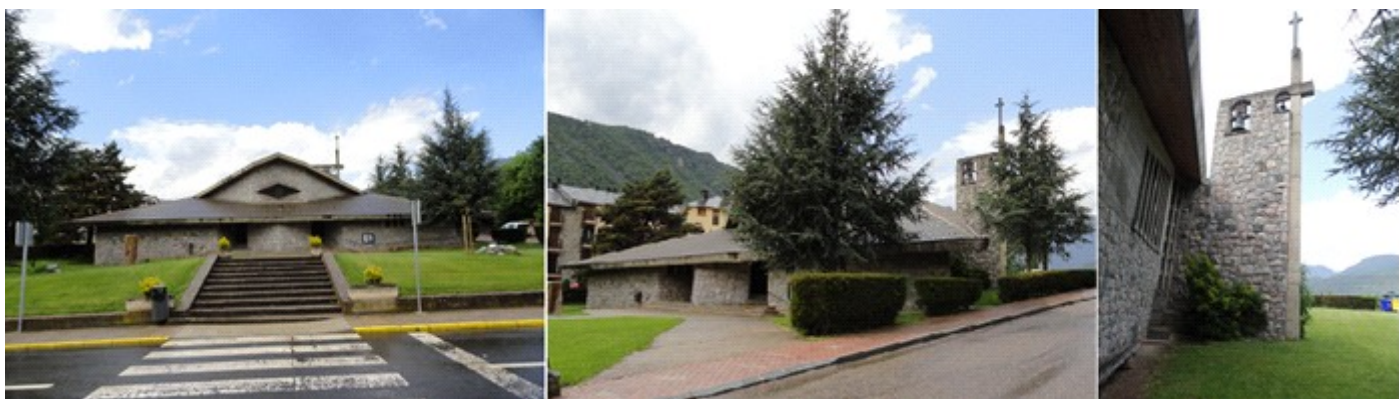
1 Fachada ante la nacional con amplios espacios verdes. 2 Construida en piedra y cubierta con tejados de pizarra. 3 Espadaña lateral que hace de campanario con dos vanos.
