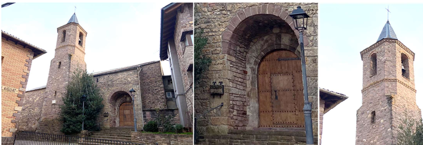
① Lateral del Evangelio con su puerta cobijada en un gran arco rehundido de medio punto sin decoración. En este lado norte tiene adosada su torre de planta cuadrada de dos cuerpos, los primeros y los dos segundos octogonales separados por una imposta corrida y culminada con un chapitel piramidal. ② Detalle del arco de entrada. Como el resto del templo con sillarejo de distintos tamaños. ③ Los tres últimos cuerpos de su torre, con el campanario abierto en sus cuatro lados altas ventanas de medio punto y sus ángulos achaflanados. Esta torre se restauró en 1994.
