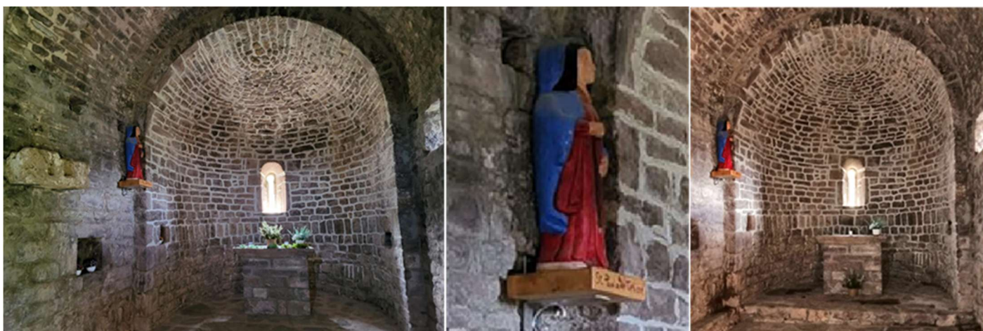
❶ Su cabecera con bóveda de cuarto de esfera, sin decoración salvo la posición de las piedras en una franja de forma vertical. ❷ Talla de la Santa policromada de factura moderna. ❸ El efecto de su ventana con un vano estrecho de herradura, y junto al arco triunfal posee una pequeña ventana de aspillera en el lado epistolar. Fotos Patricia Tarrafeta Borrueil.
