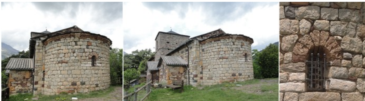
❶ Parte posterior con el ábside y la capilla adosada. ❷ En este lado epistolar cuenta con una capilla y a los pies su sacristía. ❸ Ventana del ábside con piedra tosca.
