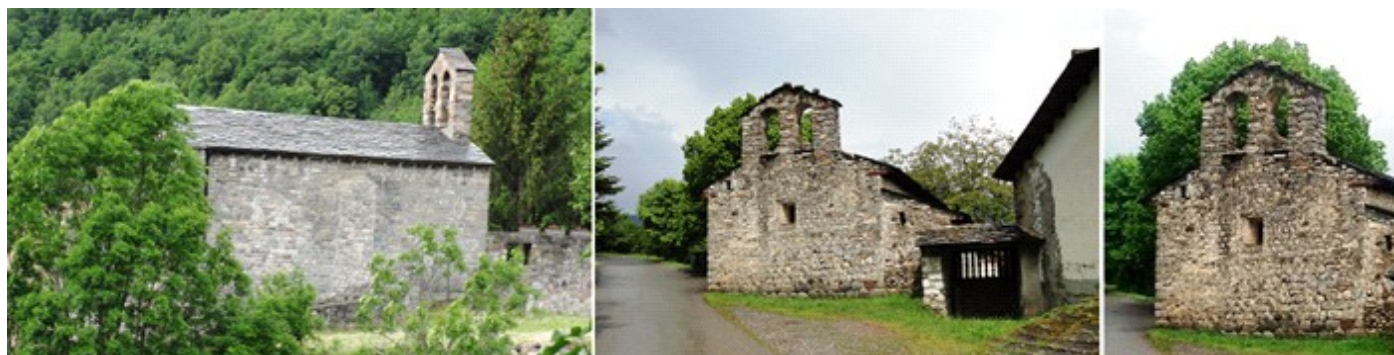
① Lateral del Evangelio. Templo de influencia jaquesa. ② Su hastial abierto con una venta adintelada y a su derecha un porche de entrada al recinto. ③ Con una amplia espadaña de dos vanos vacía.
