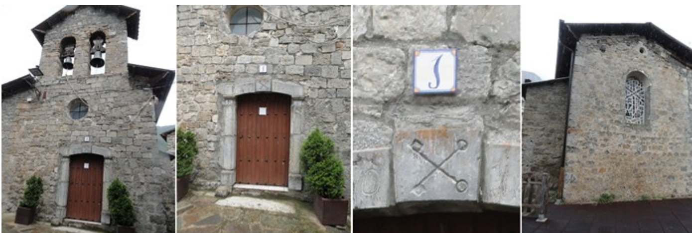
1 Capilla San Hilario, su hastial con una puerta adintelada, sobre la misa un óculo y su amplia espadaña con dos vanos y campanas. 2 Su puerta con un dintel ligeramente arqueado y con la inscripción Año 1807. 3 En su clave las dos llaves cruzadas. 4 La parte de su cabecera recta y con una ventana cegada, pero con la P y dos brazos de un crismón realizado con trozos de cristal formando una vidriera.
