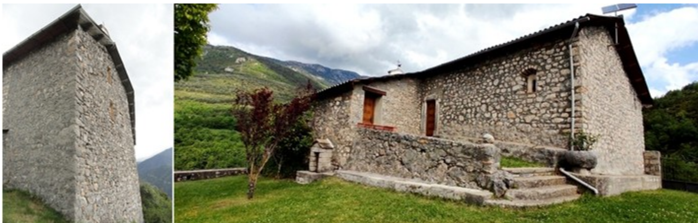
❶ parte inferior del templo junto al precipicio. ❷ Fachada del lado de la Epístola, con una construcción adosada y un pozo. Foto: Margarita Pallaruelo.
