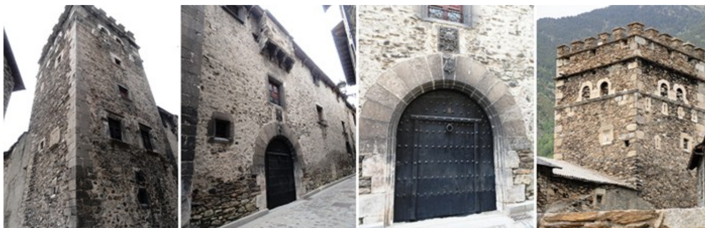
❶ La torre dispone de varios cuerpos y culmina con unas almenas de la Casa Juste. ❷ La vivienda se articula en torno a un patio, y cuenta con tres pisos. ❸ Sobre la clave de su puerta de medio punto ostenta el escudo que data de 1567. Y encima otro escudo donde en uno de sus cuarteles hay una cruz de Malta. ❹ En la torre podemos apreciar algunas ventanas de medio punto adinteladas y aspilleras.
