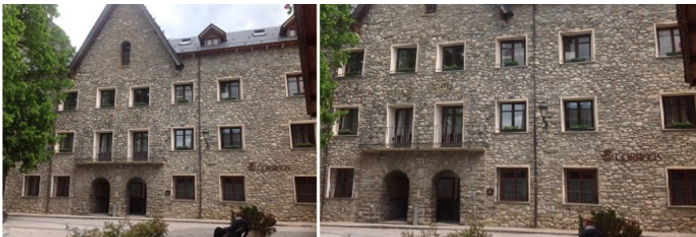
❶ Fachada de este amplio edificio de la casa Consistorial. ❷ Entre los dos arcos de entrada se encuentra el escudo de Juan de Aragón conde de Ribagorza
