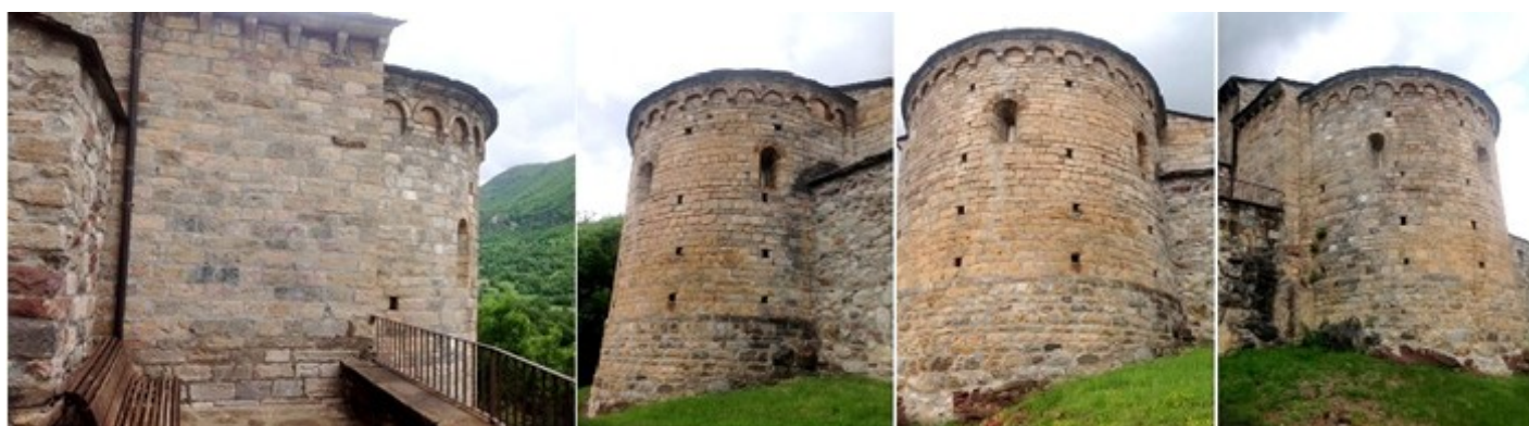
❶ Lateral epistolar con un balcón mirador. Y el tramo del presbiterio que en más bajo que la nave. ❷ Su ábside salva el enorme desnivel en esta parte del templo. ❸ En él se aprecian los mechinales de su construcción. ❹ Y se encuentra abierto con tres ventanas
