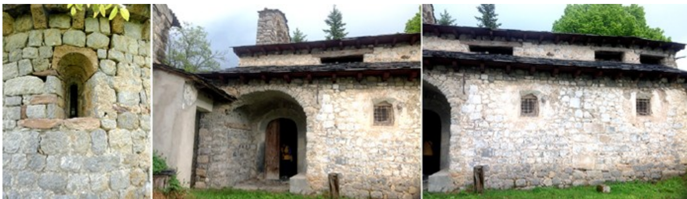
❶ Ventana del ábside con gran derrame exterior. ❷ La parte inferior del templo con su pórtico y un banco a la derecha. ❸ En esta parte exterior está abierta con sendos óculos que iluminan sus capillas.
