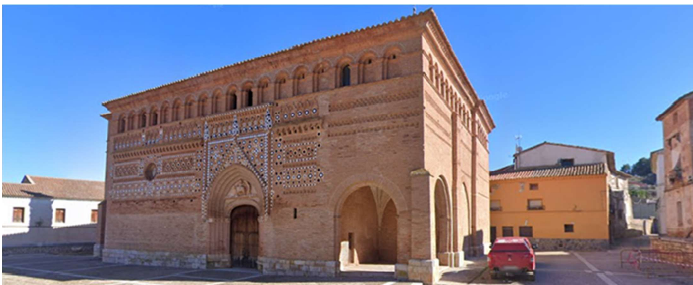
❶ Panorámica de esta iglesia. Está catalogada como patrimonio de la localidad. Perteneció al tipo de iglesias-fortaleza que se construyeron en el siglo XIV. Posee una sola nave con dos tramos, además del coro a los pies y el presbiterio en la cabeza. Tienes más información: https://www.moratadejillocaturismo.es/patrimonio-iglesia-san-martin-morata-jiloca.html
