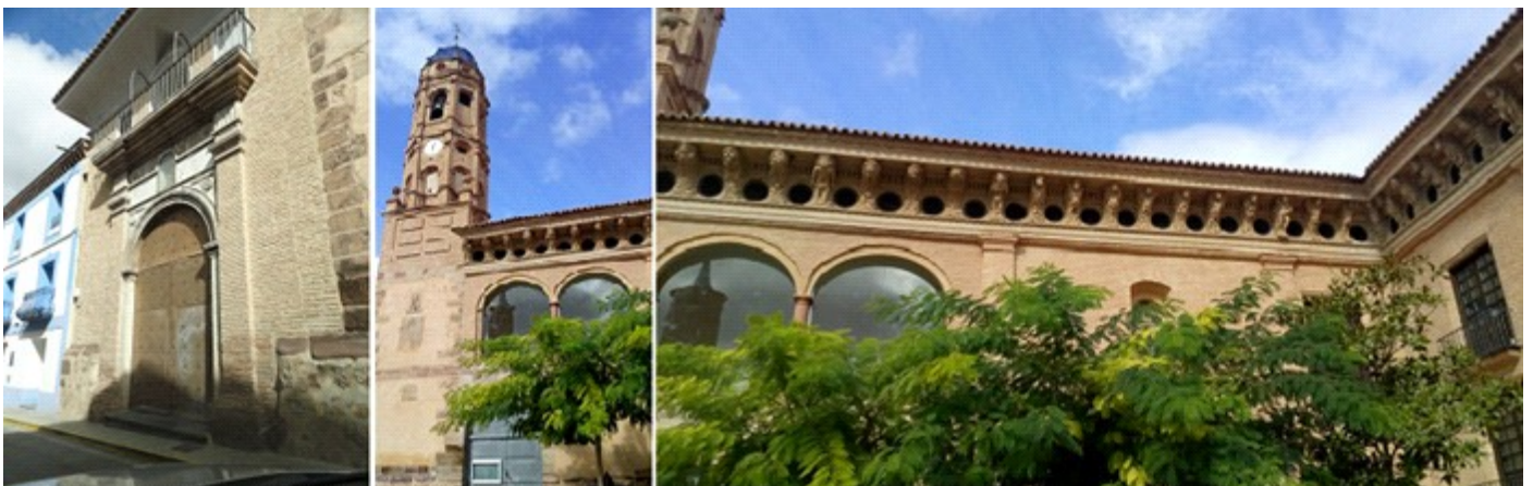
❶ Puerta a los pies de medio punto, que da a la calle Mayor Baja, 2. ❷ Su torre de planta cuadrada construida en mampostería y ladrillo el tramo inferior y el superior de planta octogonal construidos en ladrillo. ❸ Tanto el alero correspondiente al templo como el del colindante del palacio tienen el mismo estilo decorativo de ménsulas y figuras sobre las mismas alternadas con óculos.
