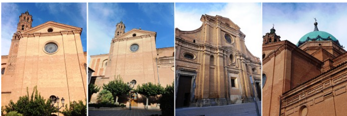
❶ Paño exterior del brazo del crucero del Evangelio. ❷ El brazo del crucero ofrece un gran óculo con vidrieras y otro abierto en el frontis triangular. ❸ A los pies su fachada principal con varios cuerpos y tres puertas adinteladas, de las cuales la central se ha cegado dejando una ventana. ❹ Vista del crucero con su cúpula de 13 m de diámetro.
