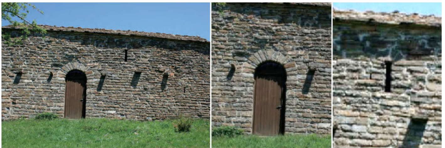
① Su puerta ubicada en el muro meridional. ② Con un arco de medio punto de herradura. ③ Pequeña ventana de aspillera coronada con dovelas en cuña en esta fachada a la derecha de su puerta. ④ Fotos: Jesús Sanz.
