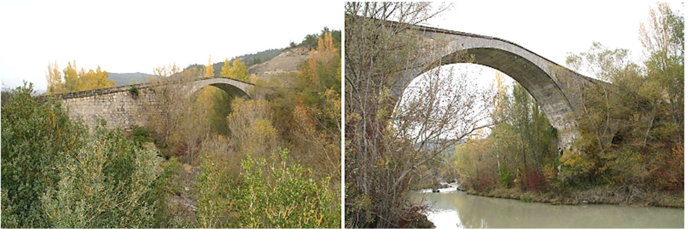
① Con la característica de tener "lomo de asno". Esta construido con piedra sillar y sillarejo. ② Su arco central, a la derecha se encuentra el otro arco más pequeño.
