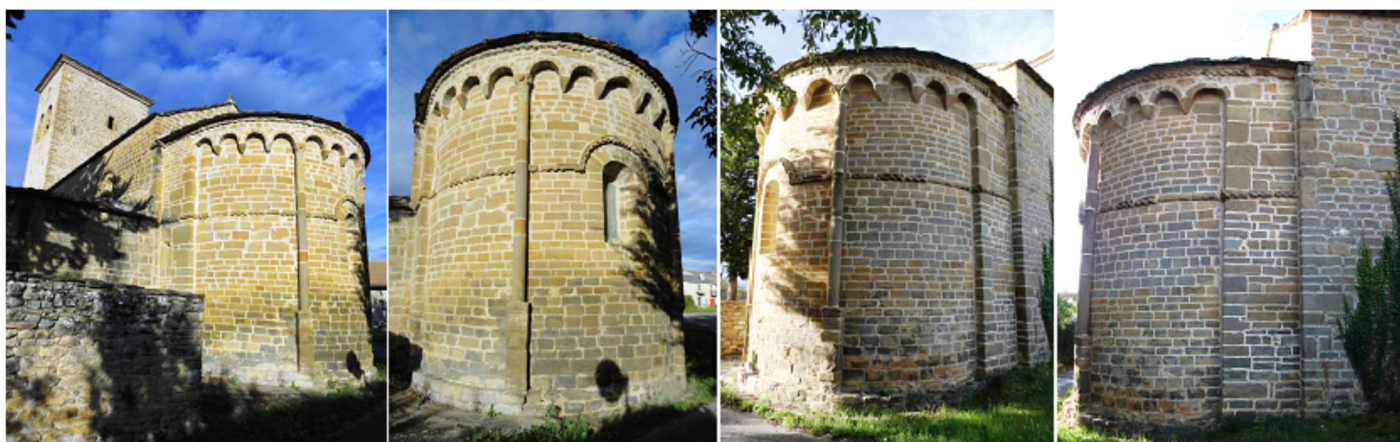
❶ El ábside con una arquería ciega lombarda. ❷ Con tres tramos separados por dos columnas redondas sobre una parte inicia recta y con una imposta corrida y taqueada. ❸ Dispone en el paño central de una ventana y bajo el alero. ❹ En esta foto se puede apreciar arriba que las columnas adosadas o exentas pues dejan pasar en algún tramo la luz.
