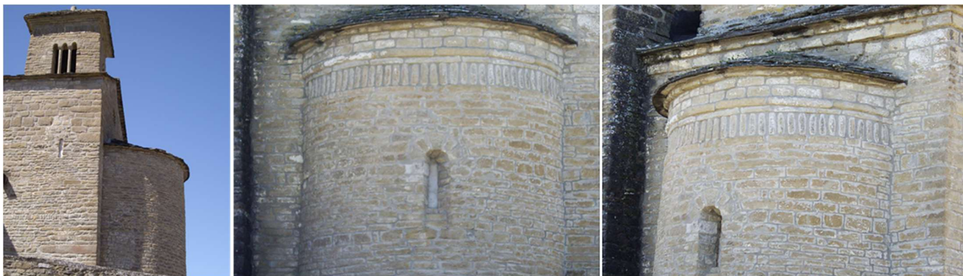
❶ Lateral epistolar del templo donde posee dos finas ventanas de aspillera con arco de medio punto. ❷ Detalle del ábside derecho con el friso de baquetones. ❸ Y que posee en su parte central una ventana de pedio punto con doble derrame.
