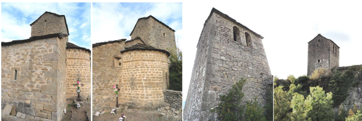
❶ Exterior de la sacristía junto al camposanto. ❷ Su ábside con un tejazoz sostenido por canecillos cóncavos simples, y en este lado un óculo para dar luz al templo. ❸ Torre de un solo cuerpo con dos ventanas de medio punto al oeste. ❹ Silueta del templo desde la carretera que lleva a la localidad.
