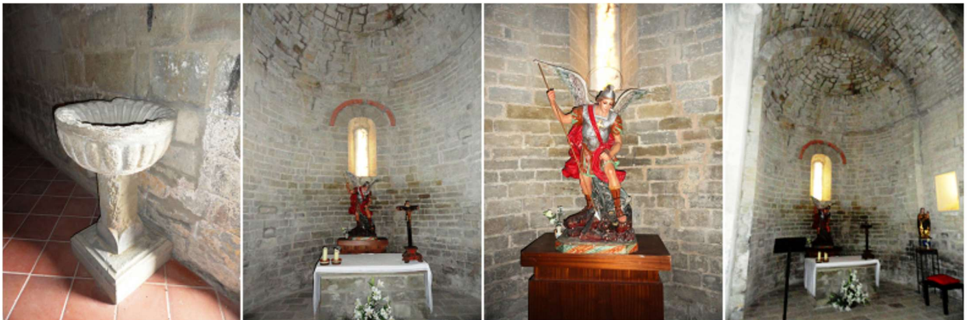
❶ Pila de piedra arenisca con taza semicircular, que exteriormente está decorada con gallones en relieve y el interior con excavados, sobre un fuste redondo con basa cuadrada. ❷ Ábside abierto con una ventana de medio punto con derrame interior cubierta con un guardapolvo taqueado y con una imposta corrida lisa a la atura de la bóveda. ❸ Talla de San Miguel Arcángel. ❹ Detalle del presbiterio.
