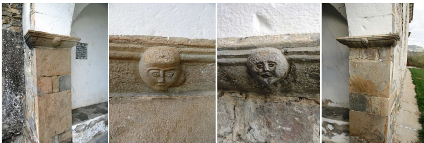
❶ Las columnas del atrio rectas con una imposta que en si cara central dispone de una cara. ❷ - ❸ Caritas. ❹ lateral derecho.
