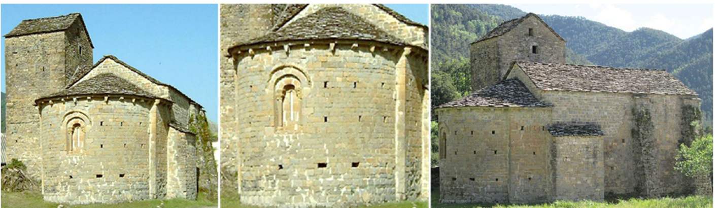
❶ Adosada a la fachada epistolar donde se encuentra su puerta, en un atrio abierto y que ha perdido su cubierta se alza la torre de planta cuadrada de un solo cuerpo y con cubierta a dos aguas, en el lado sur se abre su campanario con dos vanos de medio punto. ❷ Ventana con dos arquivoltas la interior descansa en capiteles con motivos vegetales muy erosionados y columnillas, y cubierta con un guarda lluvias taqueado. ❸ Lateral del muro norte donde se aprecian sendos contrafuertes del primer tramo de la nave, todo el templo sus cubiertas son a base de lajas. Foto Wikipedia Don Camilo.
