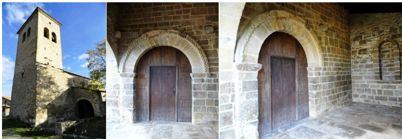
1 Imagen de la iglesia con su portada orientada al sur. 2 Portada con una arquivolta con dovelas lisas y cuenta con un guardapolvo con ajedrezado jaqués. 3 Portada que está cubierta con un pórtico
