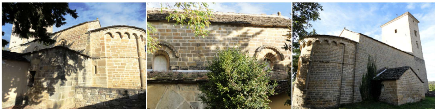
❶ Lateral del medio día con la capilla de crucero y su ábside. ❷ En este lateral hay dos ventanas de medio punto que disponen de guarda lluvia con taqueado jaqués. ❸ Lateral exterior del Evangelio con la otra capilla y su torre.
