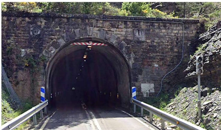
1 Entrada túnel de Cotefablo.
