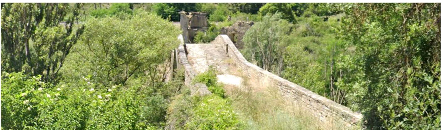
❶ Instantánea desde el arcén de la carretera. Antes km 618 tiene la posibilidad de aparcar y tomar un camino que te acerca al mismo.
