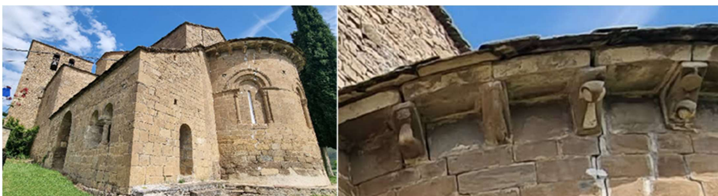
1 Esta iglesia le da un aspecto fortificado por su torre. en esta imagen vemos su pórtico abierto con un vano de medio punto y a su derecha una doble ventana de dos arcos con mainel. 2 Una variada colección de canecillos bajo su alero en el ábside.
