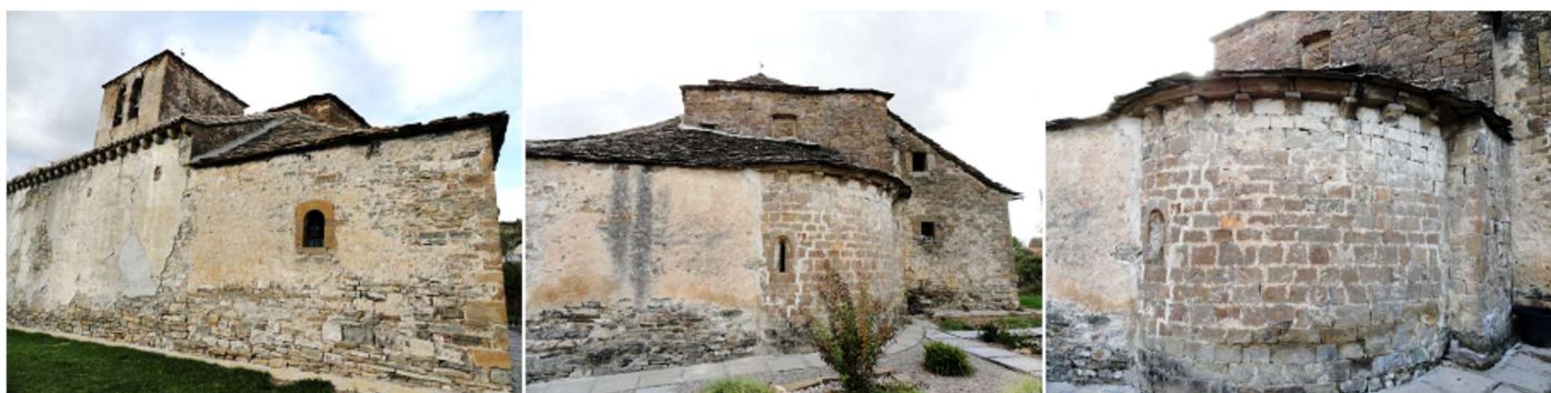
❶ Lateral epistolar del templo con las capillas y sacristía. ❷ Sacristía que adosada a la cabecera tapa la mitad de ábside exterior. ❸ Detalle del ábside el único resto del románico de este templo con un vano con derrame exterior y los canecillos lisos de su alero.
