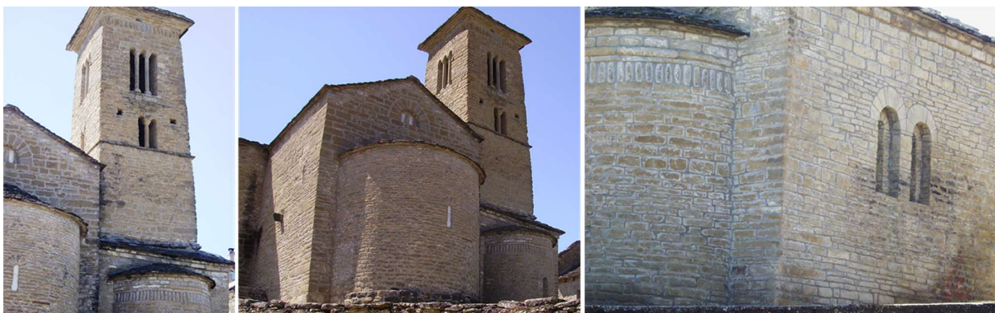
❶ La torre tiene tres cuerpos separados por impostas corridas, el bajo sobre la parte del templo, el segundo con sus muros liso y el último con dos superposiciones de ventanas. Con una cubierta a cuatro aguas con lajas de piedra. ❷ La nave lo hace a dos aguas e igualmente cubierta de lajas. ❸ Cuerpo inferior donde se levanta la torre con una doble ventana de medio punto.
