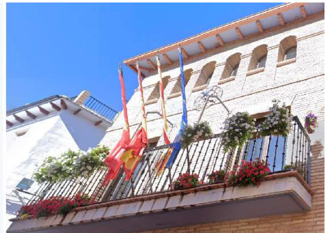
2 Fachada de Ayuntamiento en la calle Mayor, 9.
