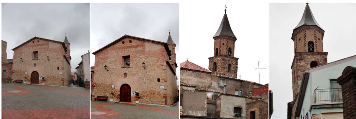
1 Ante una gran plaza se encuentra el templo Dedicada al cura del pueblo. 2 Con una puerta de medio punto son dovelas grandes y donde se aprecian las reiteradas ampliaciones. 3 En el Lateral del Evangelio se encuentra su torre de planta cuadrada y que culmina con un chapitel octogonal este cuerpo realizado en ladrillo. 4 Imagen de la torre desde la plaza del Ayuntamiento.
