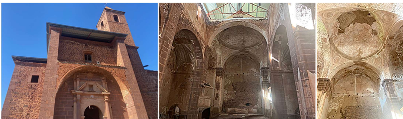
❶ La portada, de corte clasicista, se abre en el frente occidental y junto a ella, en el ángulo suroccidental, se eleva la torre campanario. En la parte baja interior del arco aún conserva los relieves de yeserías barroco – mudéjares de cruces y estrellas. ❷ La iglesia tiene cabecera recta, nave única y capillas entre los contrafuertes comunicadas entre sí. ❸ El presbiterio está cubierto por una gran cúpula que señala el lugar bajo el que sitúa el panteón familiar de los Luna, motivo de la construcción del convento.
