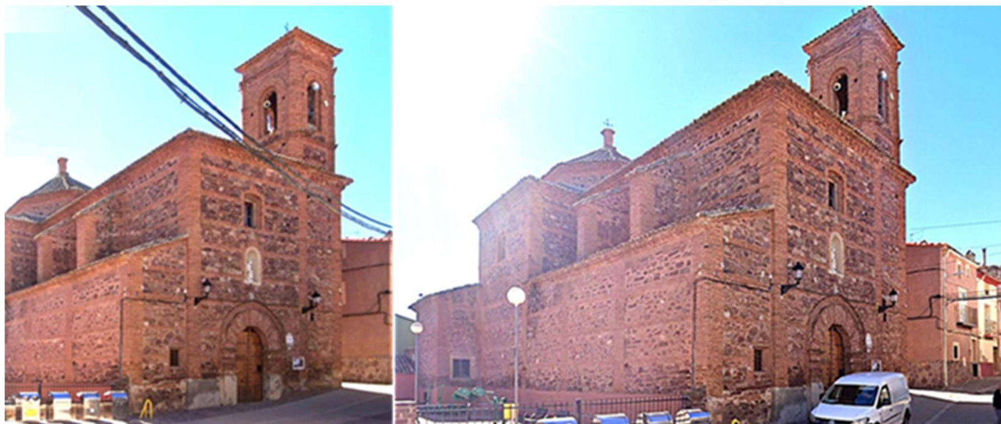
❶ La construcción del templo con hiladas de ladrillos que alojan la argamasa con piedra irregular en sus muros. ❷ Lateral del Evangelio y su fachada con la torre adosada en su lateral epistolar.
