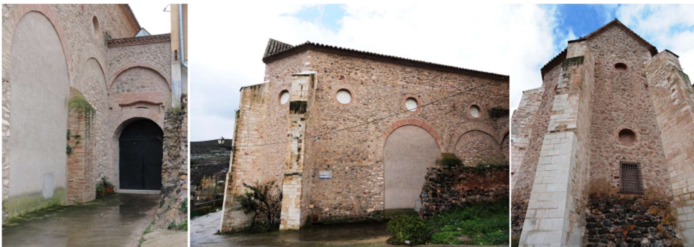
❶ Puerta en el lado del Evangelio. ❷ Lateral del lado del Evangelio que aún quedan los arcos del monasterio y óculos con alabastro. ❸ Cabecera poligonal con gruesos y altos contrafuertes realizados con piedra sillar.
