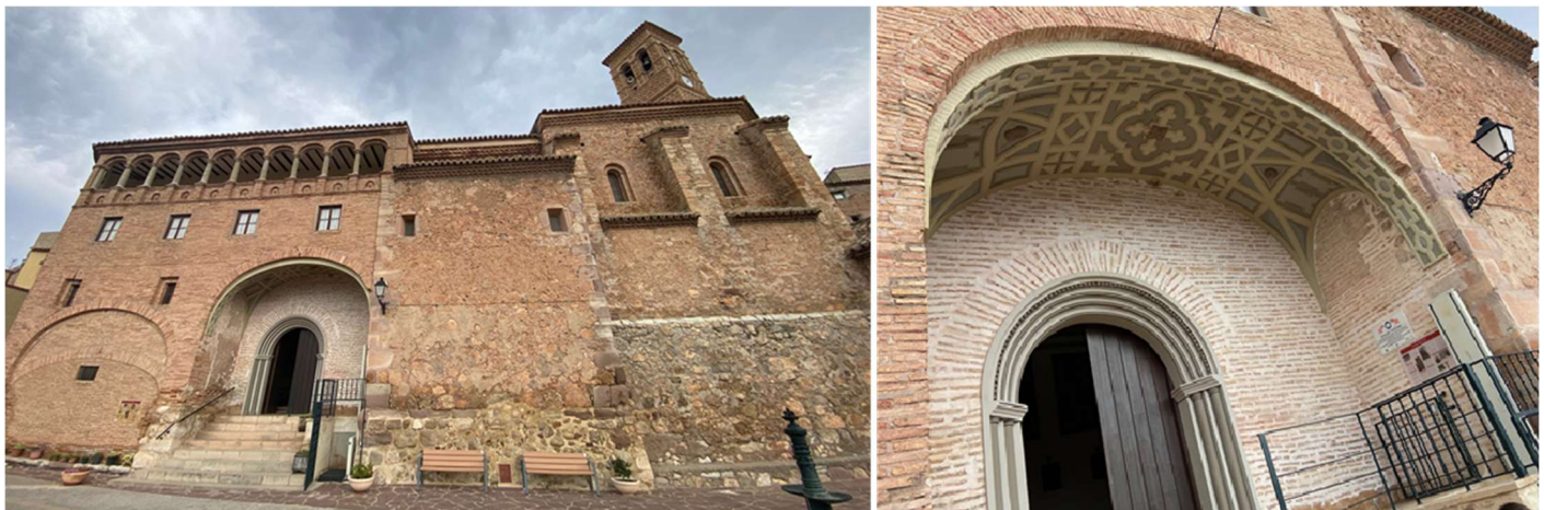
❶ Fachada con el lado de la Epístola.
