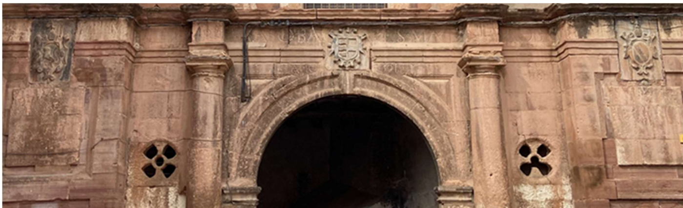
❶ En el primer cuerpo de la fachada tenemos en el centro su arco de medio punto con sendas columnas dóricas sobre pódium. En la parte superior del arco hay la siguiente inscripción: "Trasobares mandó construir año 1621" en la clave un escudo armero adaptado a los criterios del tratadista italiano Vignola.
