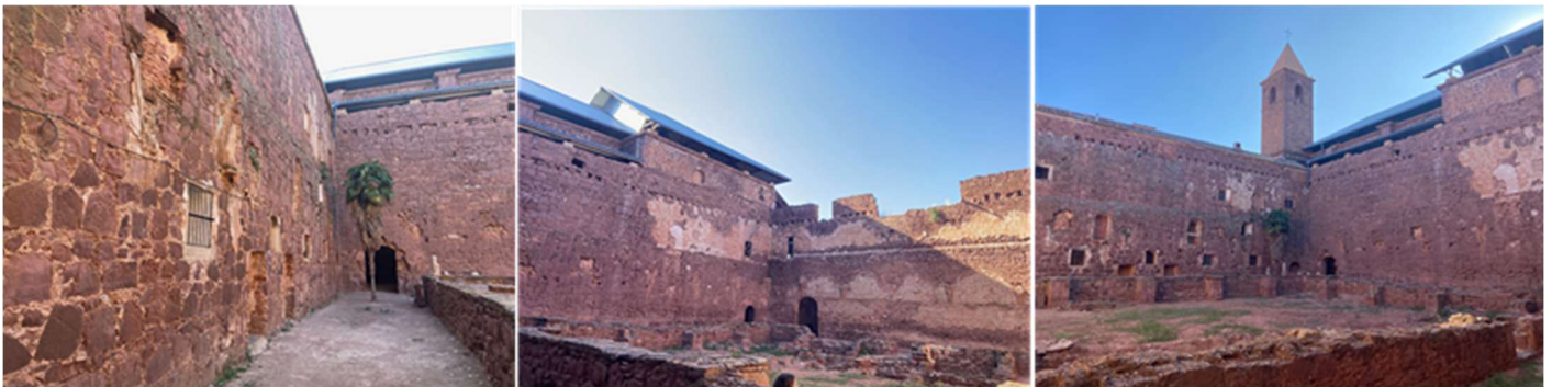
❶ Del claustro apenas se conservan los muros perimetrales y el arranque de las bóvedas de crucería de las crujiás. Al fondo la entrada al templo desde el claustro. ❷ Otra ala del claustro en su interior, dado el brote de cólera de 1893 se encontraron 57 enterramientos que emplearon el espacio como cementerio y posteriormente la arquería de sus pandas se derrumbó. Hasta que en las excavaciones de 1988 aparecieron. Parte de estas momias se pueden apreciar en el pequeño museo que tiene. ❸ A la izquierda los muros de los dormitorios.
