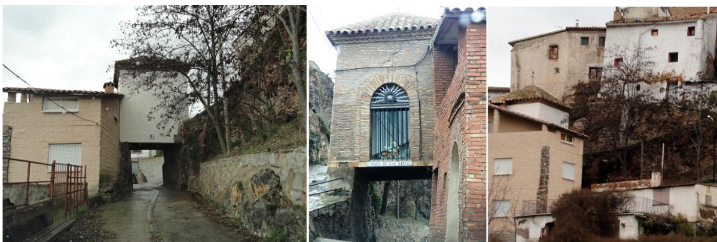
❹ Arco por donde se accede al interior del pueblo. ❺ Este arco es la capilla de la Virgen de las Nieves. ❻ Detalle de sus casas escalonadas.
