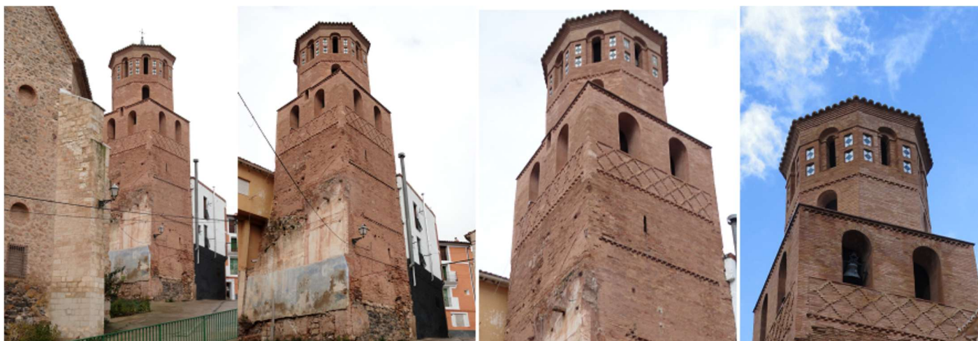
❶ La torre se encuentra actualmente exenta. ❷ Que estaría adosada a la construcción conventual. Y en ella se aprecian dos bandas con decoración de esquinillas. ❸ Su parte inferior de planta cuadrada y la superior octogonal ambas abiertas con ventanas de medio punto. Y azulejería rehundida ❹ La parte superior de la torre cuadrada con decoración en ladrillo de rombos y esquinillas.
