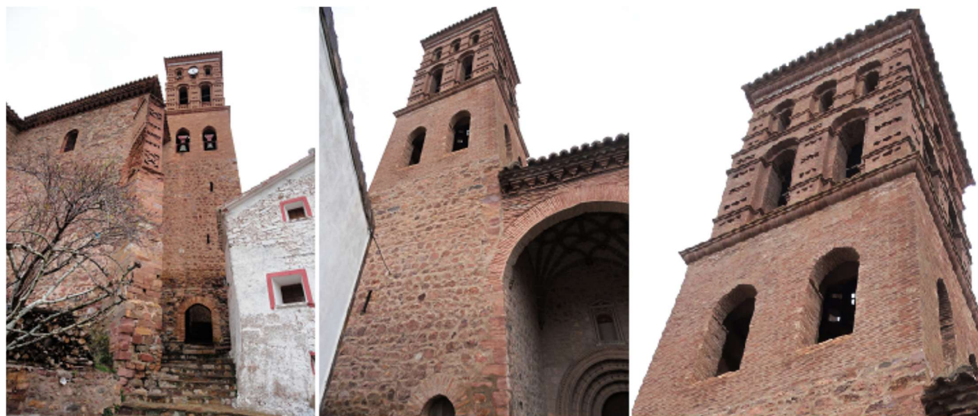
❶ Escaleras que nos dejan bajo la inmensa torre que está abierta con pasaje con dos arcos de medio punto. ❷ Torre, sobre esta se realizaron dos cuerpos más en ladrillo. ❸ Parte superior con motivos de decoración mudéjar.
