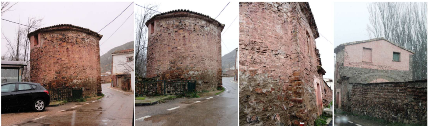
1 Junto a la carretera A-2302. 2 Nos queda su ábside construido en mampostería. 3 Lateral del lado del Evangelio orientado al sur. 4 Y en esta se aprecia el arco del presbiterio con la vivienda recrecida encima.
